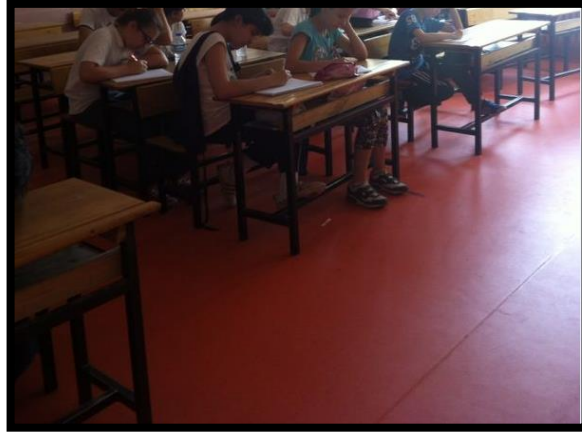
Şekil 4.80 : 3B/7B sınıfına birinci iyileştirme kapsamında pvc zemin kaplaması yapılmış hali
