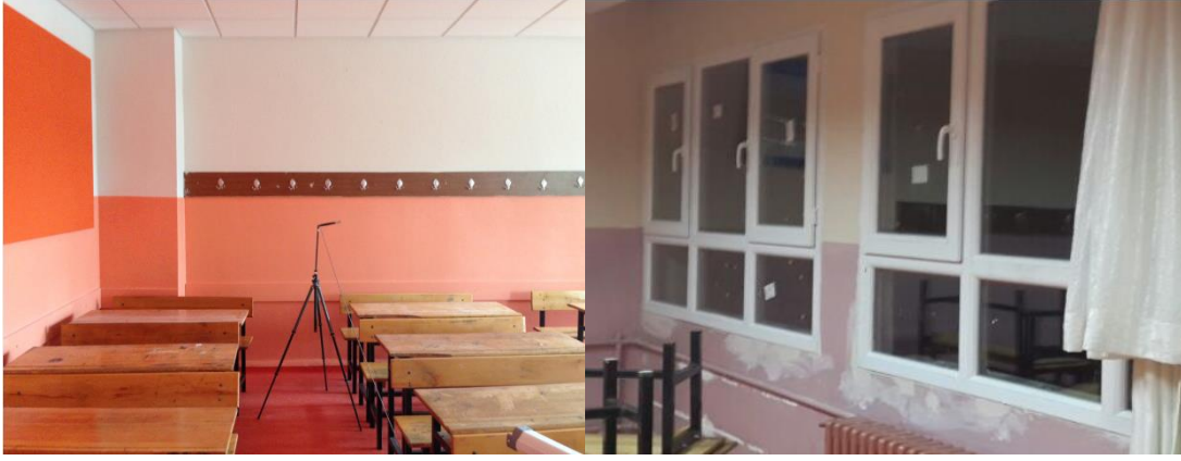
Şekil 4.93: İkinci akustik iyileştirme sonrası uygulaması tamamlanmış kumaş kaplı duvar paneli ve pvc cephe doğraması
