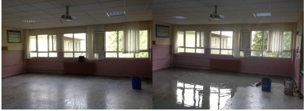
Şekil 4.79 : Birinci iyileştirme kapsamında, pvc zemin kaplama yapılabilmesi için yüzey düzeltme şapı uygulaması
