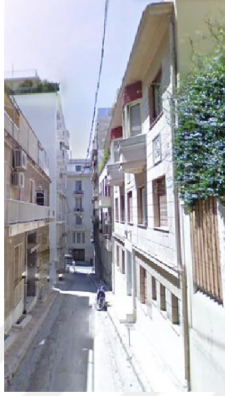
Şekil 4.75: 5 Gianni Statha Sokak'ta bulunan apartman (URL-28).
