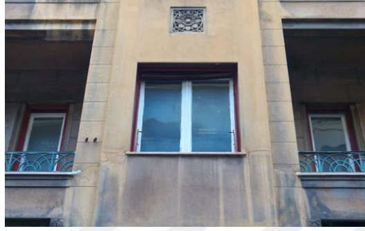
Şekil 4.81: Kyriakopoulos Apartmanı çiçek motifi detayları (URL-28).
