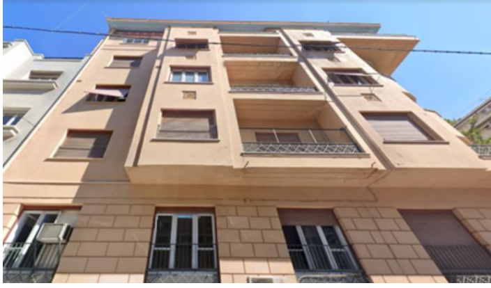
Şekil 4.66: Mavrommati Apartmanı cephesi (URL-28).
