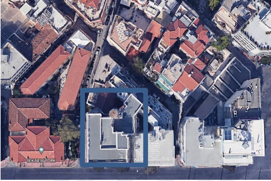
Şekil 4.59: Lykiardopoulou Apartmanı'nın kuşbakışı görünümü (URL-28).
