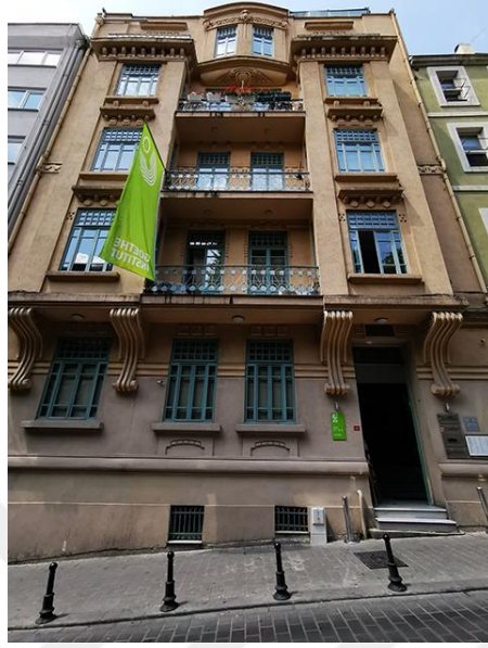
Şekil 4.6: Vernudaki Apartmanı'nın ön cephesi (Kişisel çekim, 2023).
