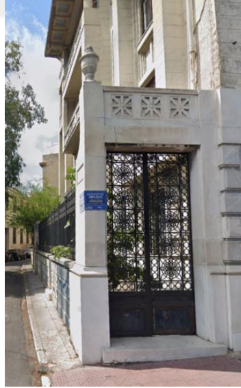
Şekil 4.55: Lykiardopoulou Apartmanı’nın dış kapısı (URL-28).
