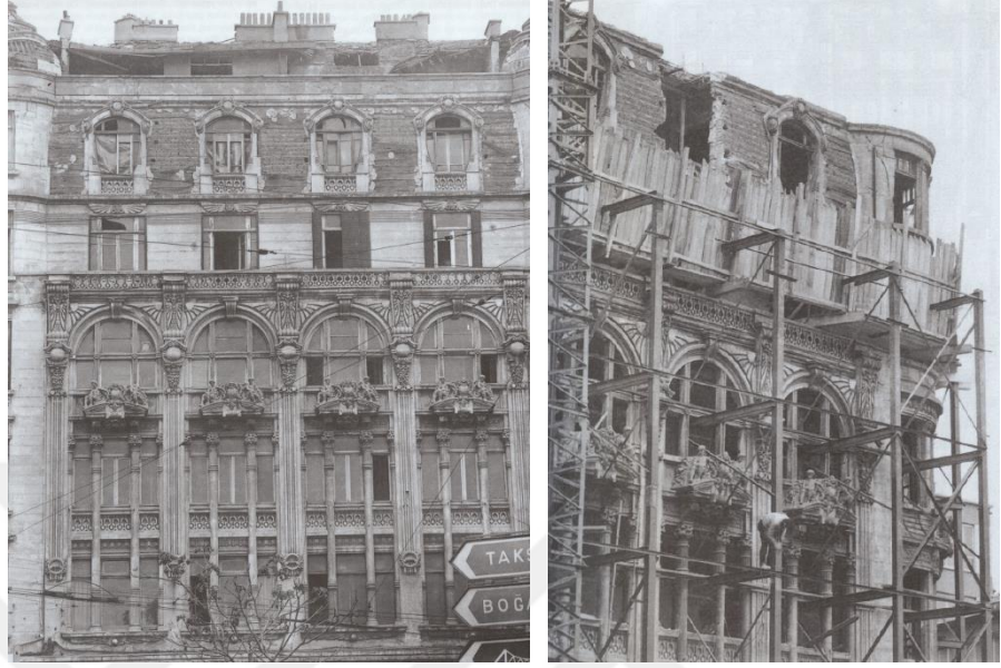
Şekil 4.16: Restorasyon öncesinde ve esnasında ana cephe (Frej Apartmanı Öyküsü, Ege Mimarlık, 1996).
