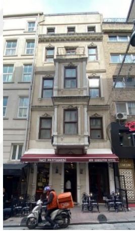
Şekil 4.45: Beyoğlu Mis Sokak 18A'daki apartman (Kişisel çekim, 2023).
