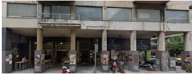
Şekil 4.73: I. Zeliotis Apartmanı zemin katı (URL-28).
