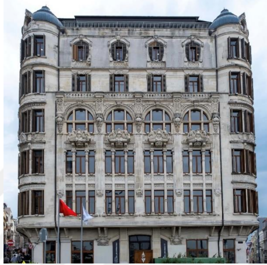
Şekil 4.15: Frej Apartmanı'nın ana cephesi (Kişisel çekim, 2023).
