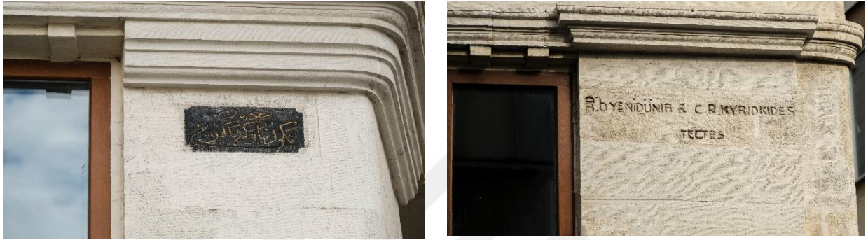
Şekil 4.10: Bina üzerindeki Osmanlıca ve Fransızca imza (Kişisel çekim, 2023).
