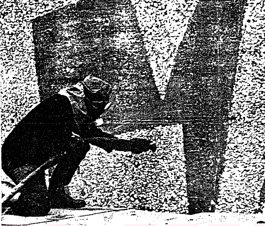
Kum püskürtme yoluyla yüzey oluşturulması.
