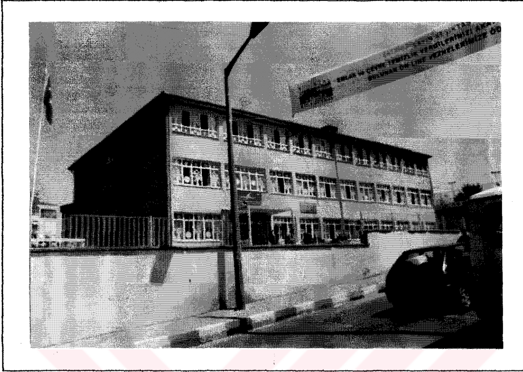
Fotoğraf 1. Etiler Anafartalar İlköğretim Okulu, Zeytinoğlu Caddesi'nden görünüş
