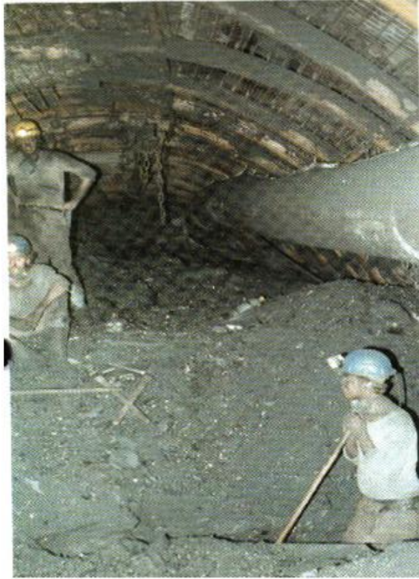
Şekil 6.5 : Olay sonrası atılan kömür postasını kaldırma işlemleri.
