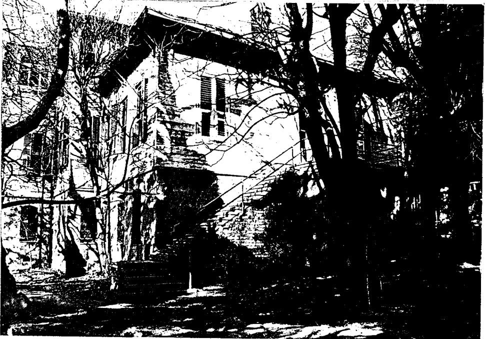
Foto. 2.7.1.4.2. Güneydoğu Cephesi/Tuğla Duvar Yüzeyi
