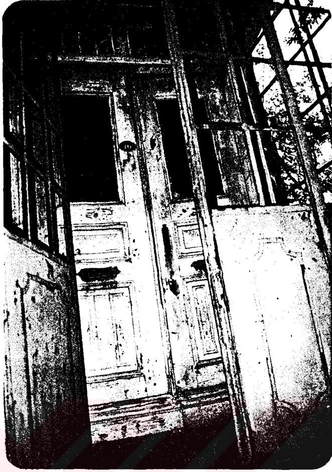
Foto. 2.4.13.1. Zemin Kat-Mekan 31/Zemin Kat Ana Giriş
