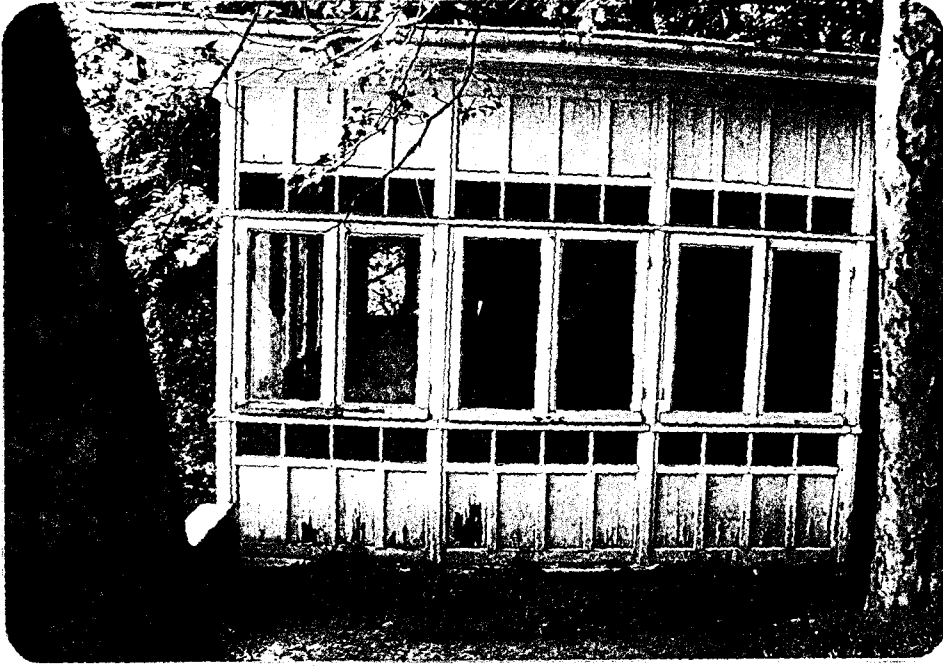
Foto. 2.7.2.4.1. Limonluk - Güneydoğu Cephesi / Cephe Düzeni
