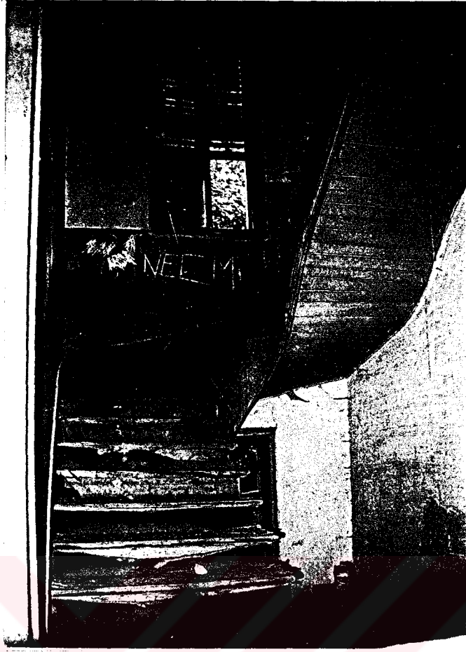
Foto. 2.4.20.2. Zemin Kat-Mekan 38/Merdiven
