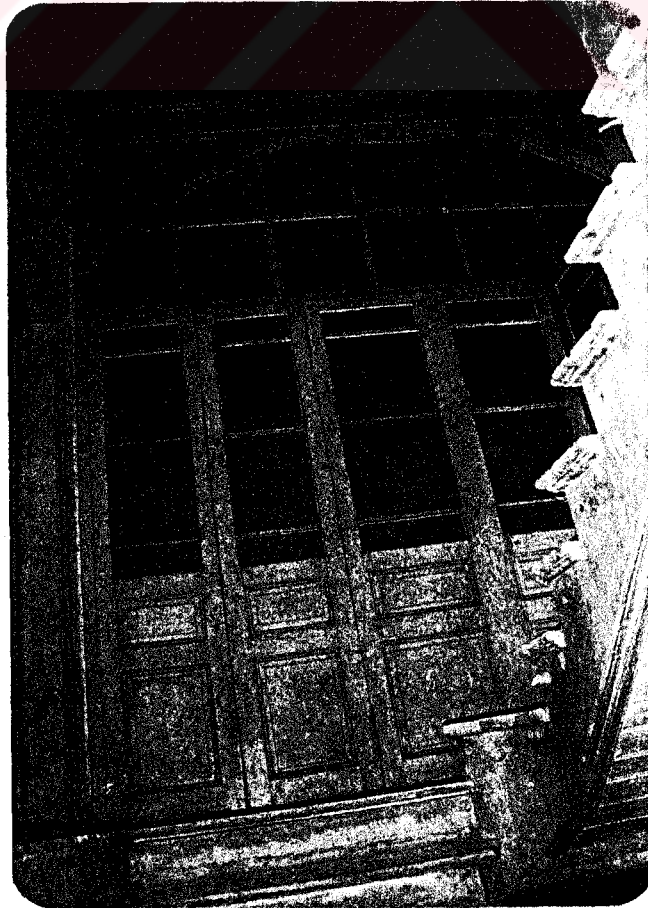
Foto. 2.4.20 1. Zemin Kat-Mekan 37/Bölme Duvarı
