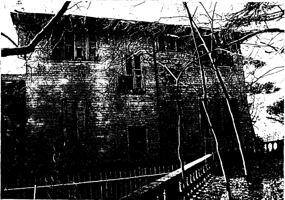
Foto. 2.7.1.1.6. Kuzeydoğu Cephesi/Genel Görünüş
