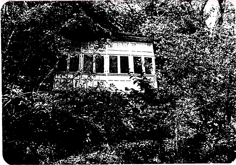
Foto. 2.7.2.3.2. Limonluk - Güneybatı Cephesi / Genel Görünüş
