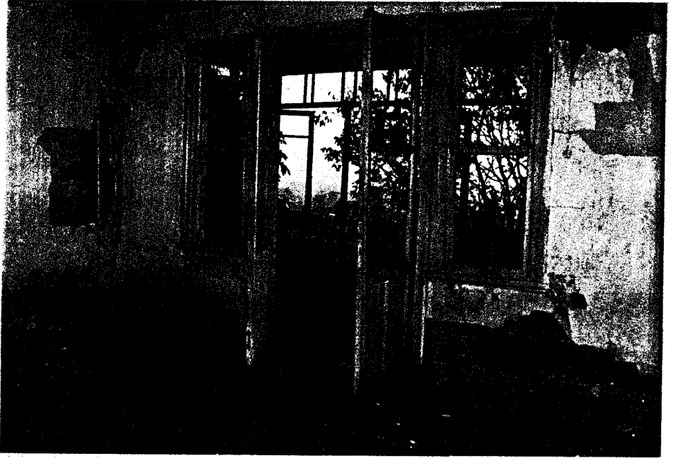
Foto. 2.5.6.2. I. Kat-Mekan 44/Güneybatı Duvarı
