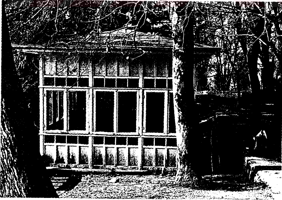
Foto. 2.7.2.4.2. Limonluk - Güneydoğu Cephesi / Genel Görünüş
