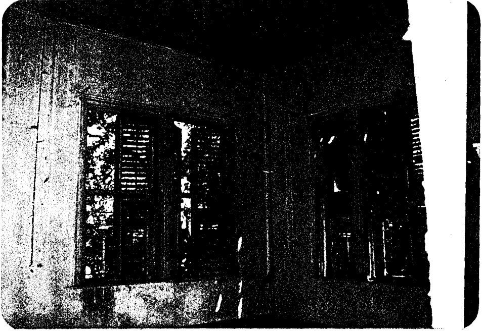
Foto. 2.4.18.1. Zemin Kat-Mekan 36/Kuzeybatıya Açılan Pencere
