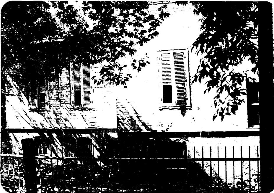
Foto. 2.7.1.1.4. Kuzeydoğu Cephesi/Genel Görünüş
