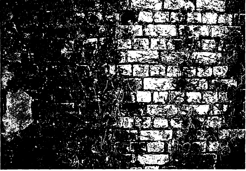
Foto. 3.3.1.1.1. Bodrum Kat-Mekan 2/Tuğla Duvar Detayı
