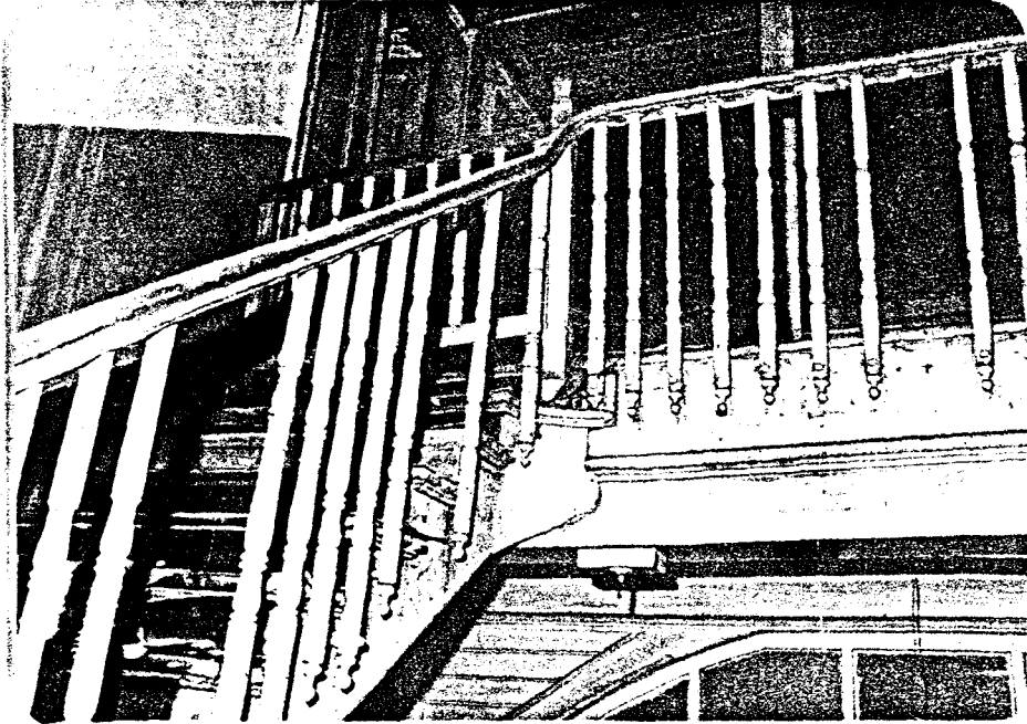
Foto. 6.1.4. I. Kat - Mek n 39 / Ah ap Merdiven Korkuluk Detayı
