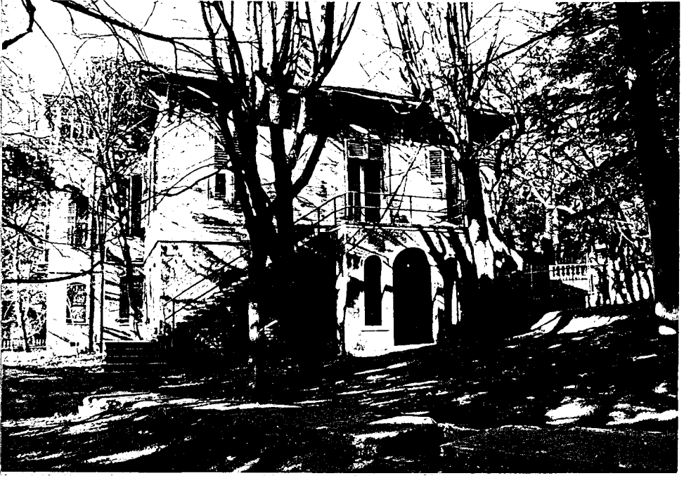
Foto. 2.7.1.4.1. Güneydoğu Cephesi/Genel Görünüş
