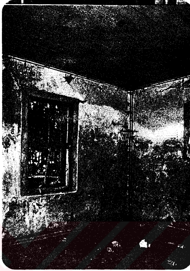
Foto. 2.3.1.15.1. Bodrum Kat-Mekan 15 /Pencere
