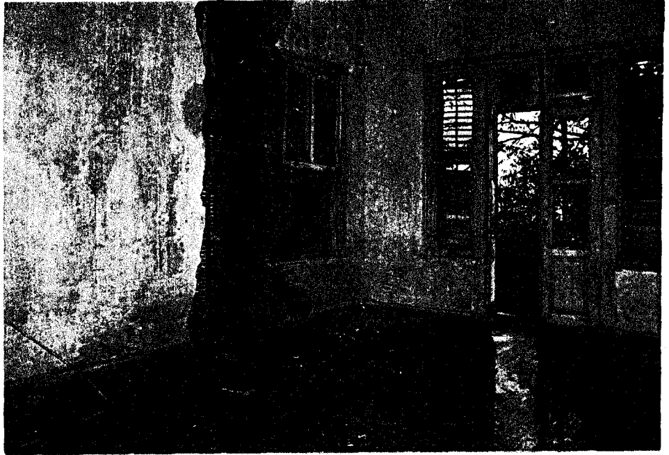
Foto. 2.4.14.2. Zemin Kat-Mekan 32/Balkon Kapısı
