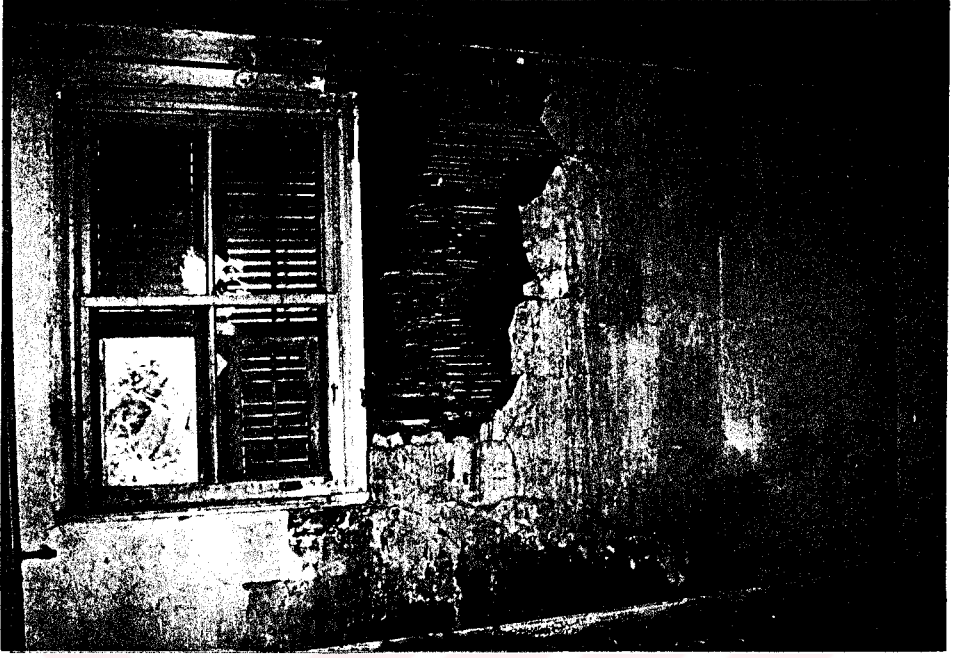
Foto. 2.5.9.2. I. Kat-Mekan 47/Kuzeydoğu Duvarı
