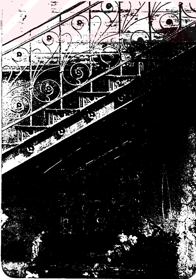
Foto. 3.5.1.6. Zemin Kat/Demir Merdiven Detayı
