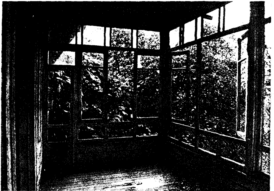
Foto. 2.5.7.1. I. Kat-Mekan 45/Yangın Çıkış Kapısı
