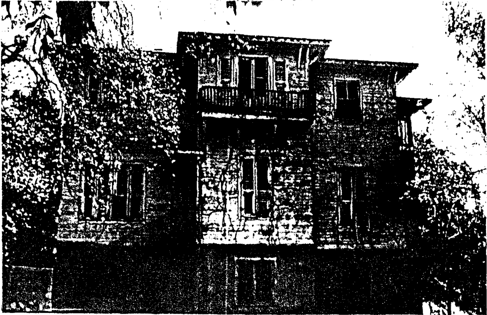
Foto. 6.1.6. I. Kat-Mekân 48 / Balkon Korkuluğu
