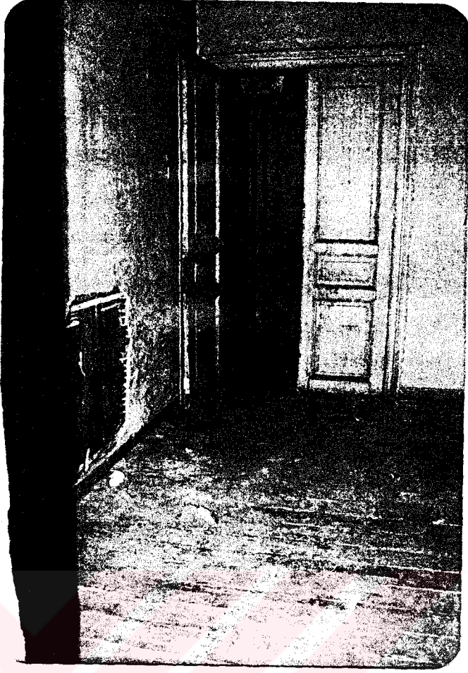
Foto. 2.4.10.1. Zemin Kat-Mekan 28/Kuzeydoğu Duvarı
