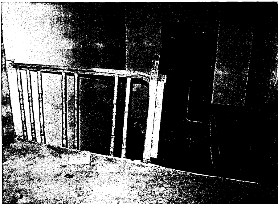
Foto. 2.5.1.1. I. Kat-Mekan 39/Ahşap Korkuluk
