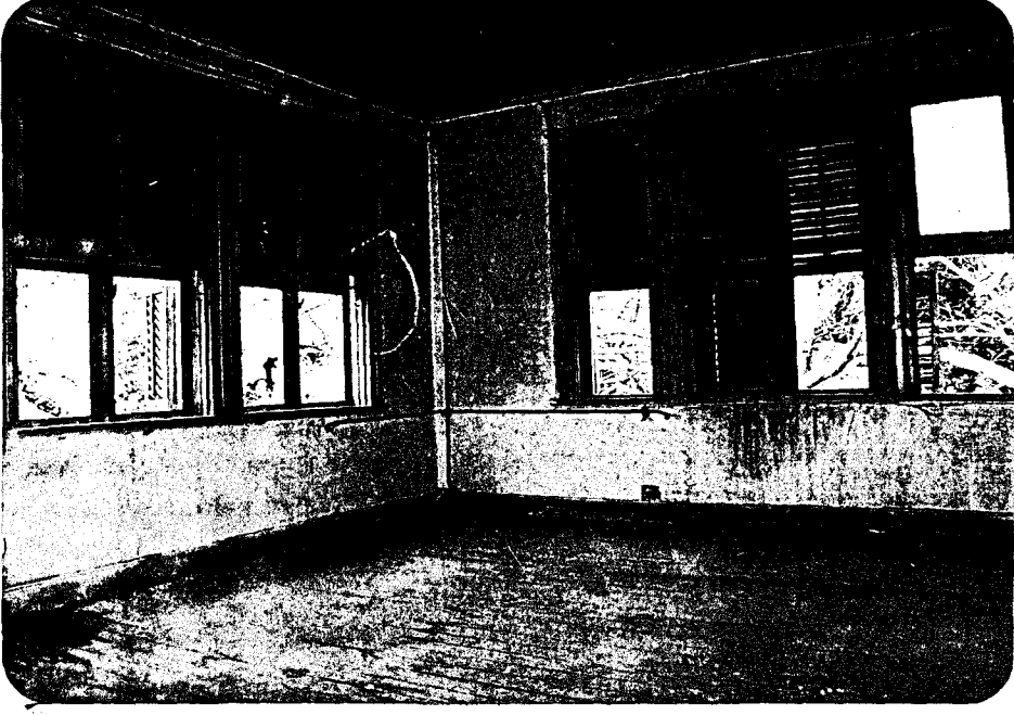
Foto. 2.5.11.1. I. Kat-Mekan 49/Kuzeydoğu ve Kuzeybatıya Açılan Pencereleler
