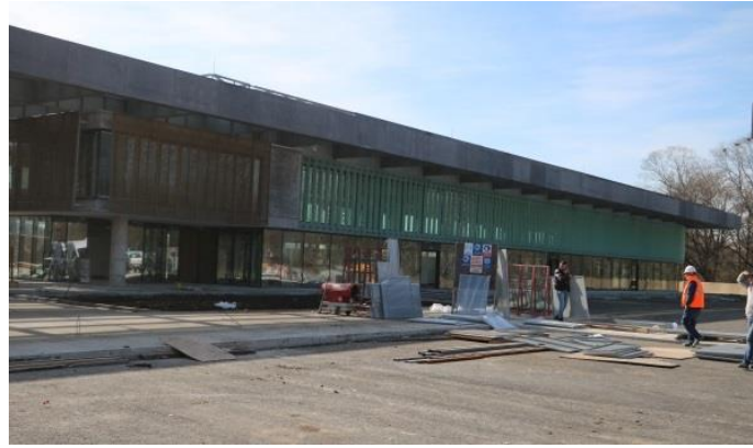
Şekil 4.5 : Lüleburgaz Terminali Şantiye Fotoğrafları (Sıddık Güvendi Arşivi)
