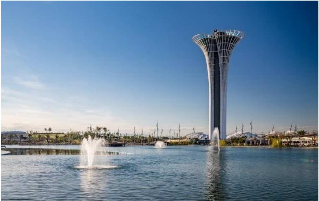
Şekil 4.7 : Expo Kulesi güncel fotoğrafı (Nita Mimarlık Arşivi, çeken Yerçekim).
