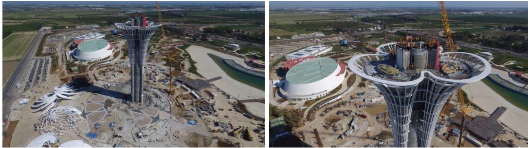
Şekil 4.10 : Expo Kulesi Şantiye Fotoğrafları (Nita Mimarlık Arşivi)
