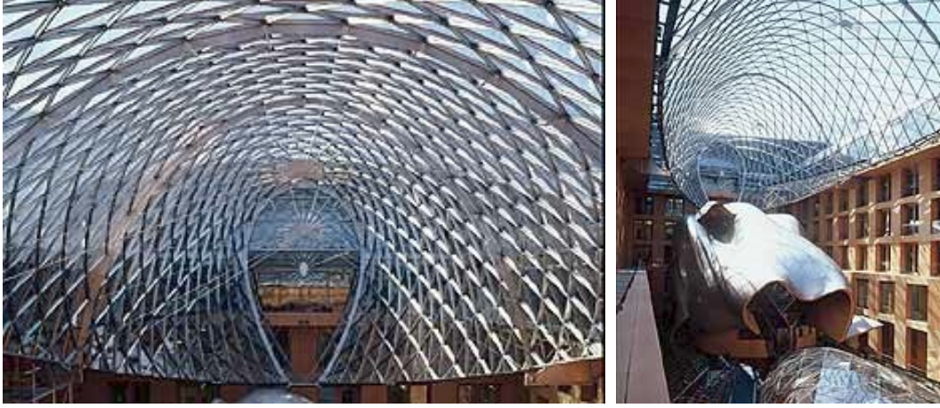
Şekil 2.25 : DG Bankası projesinin serbest formlu çatı strüktürü
