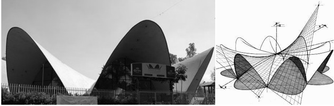
Şekil 2.24 : Los Manatiales Restoranı’nın hiperbolik paraboloid çatı kabuğu
