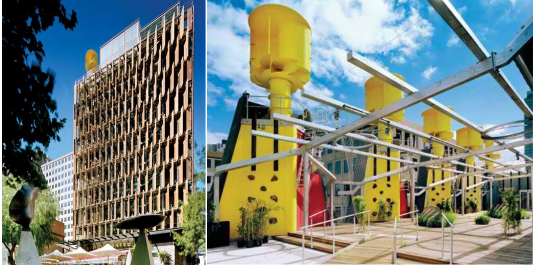
Şekil 2.10 : Melbourne’de bulunan CH2 Belediye binası
