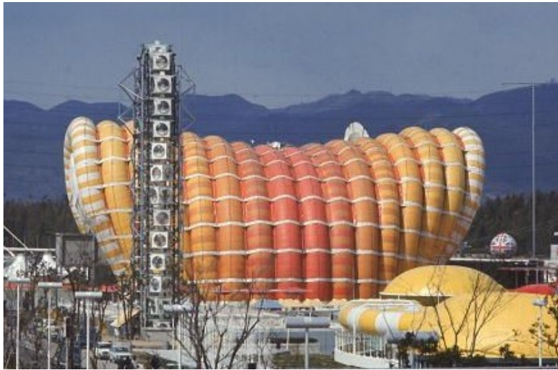
Şekil 2.22 : Pnömatrik sistem ile tasarlanan Fuji Pavilion
