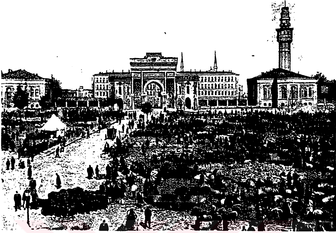
Şekil 4.2.4-2. Seraskerlik Binası girişi. Eken (1992, s.93).
