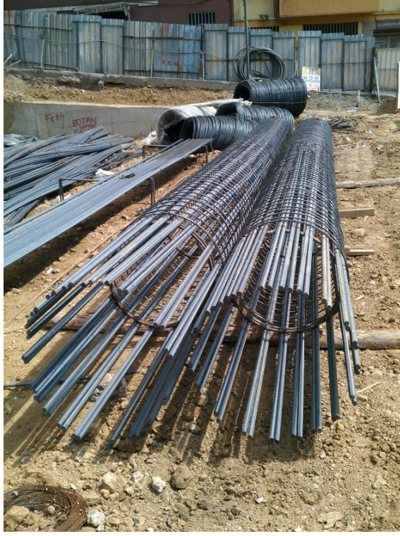
Şekil 3.2 : Önceden hazırlanmış, projesine uygun donatı kafesleri.
