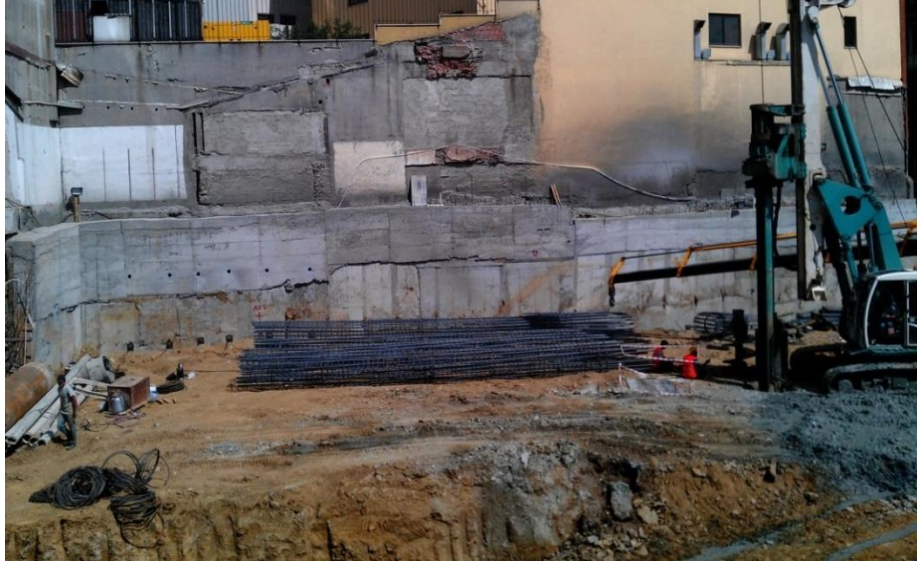
Şekil 6.5 : “Yarı-top-down” inşaat yöntemi kullanılacak bölgede kazıkların imal edilmesi (M. T. Otel, 2012/13).
