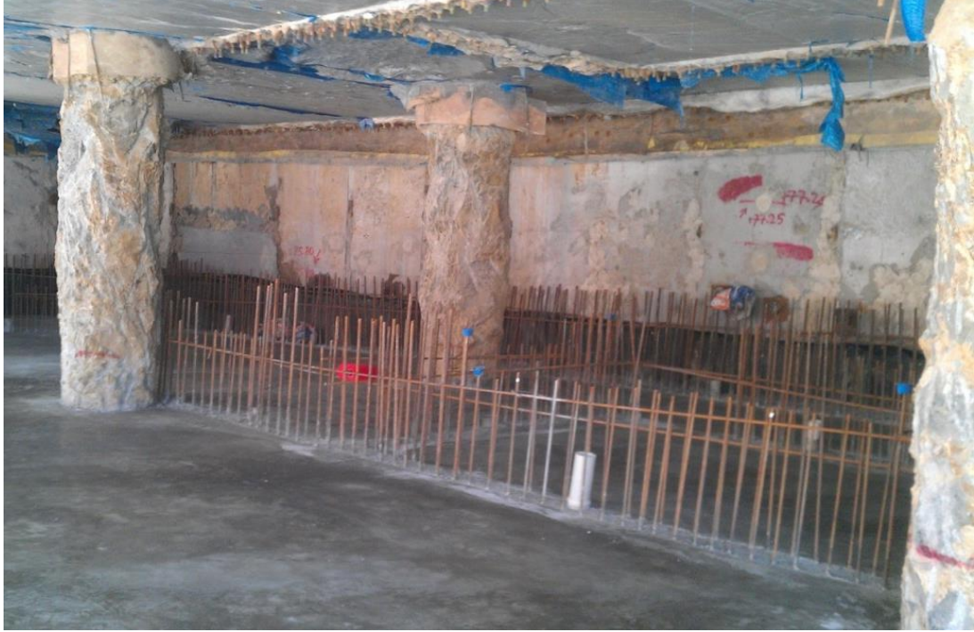
Şekil 6.28 : “Yarı-top-down” 1.Bodrum kat döşeme imalatının tamamlanması (M. T. Otel, 2012/13).
