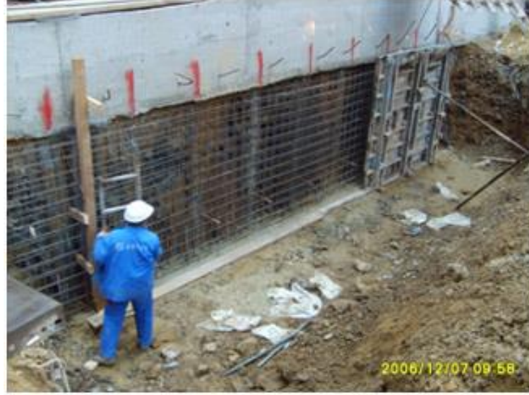
Şekil 3.33 : Aç-kapa betonarme perde kalıbı [18].
