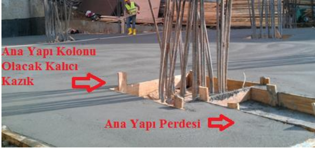
Şekil 6.9 : Sonradan imal edilecek anayapı kolon ve perdelerine ait manşonlu donatılar için kum havuzu (M. T. Otel, 2012/13).
