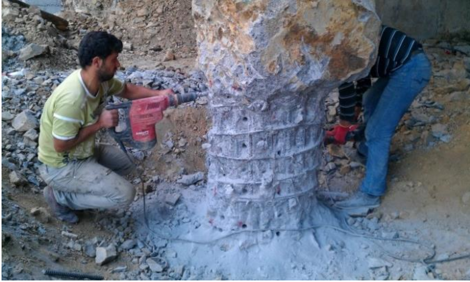
Şekil 6.20 : “Yarı-top-down kazıkları” ile “döşeme” bağlantısını sağlayacak donatılar için kazıkta delgi (M. T. Otel, 2012/13).
