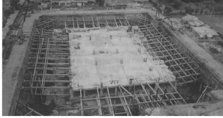
Şekil 5.12 : Ada kazı yöntemi ile yapılan temel çukuru kazısına bir örnek [10].
