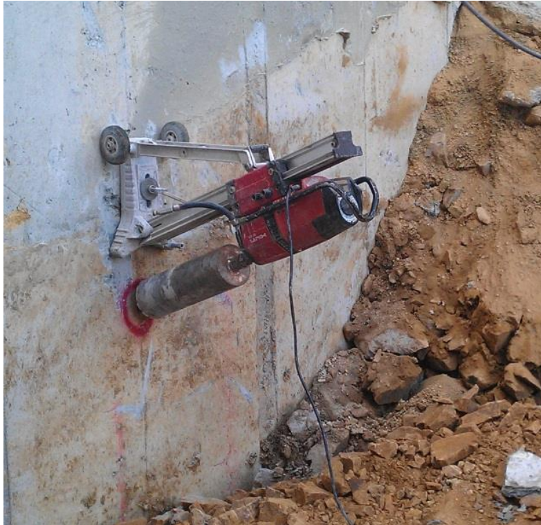
Şekil 3.42 : Betonarme perdelerde ankraj öncesi karot delgisi (M. T. Otel, 2012).
