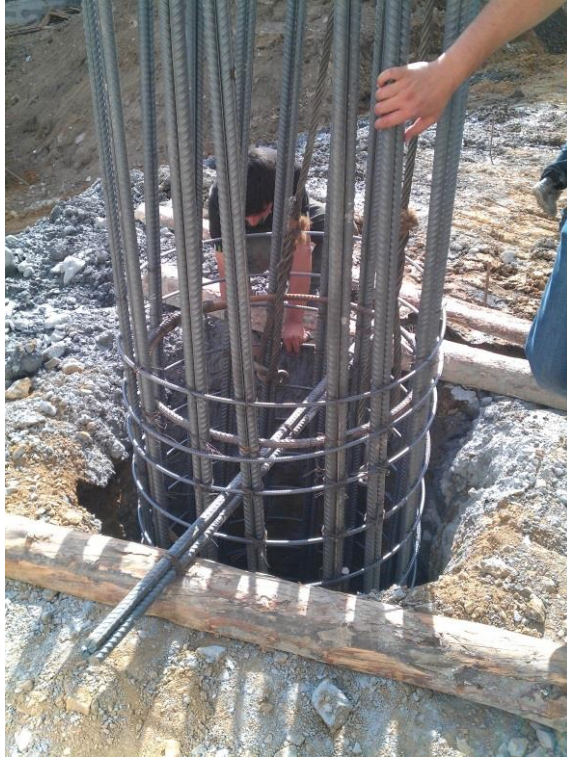
Şekil 3.3 : Betonlama öncesi askıda bekletilen donatı kafesi.
