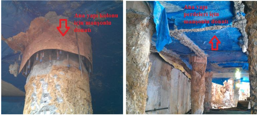
Şekil 6.10 : Kum havuzlarında korunmuş manşonlu donatının alt kademe kazı sonrası görünümü (M. T. Otel, 2012/13).
