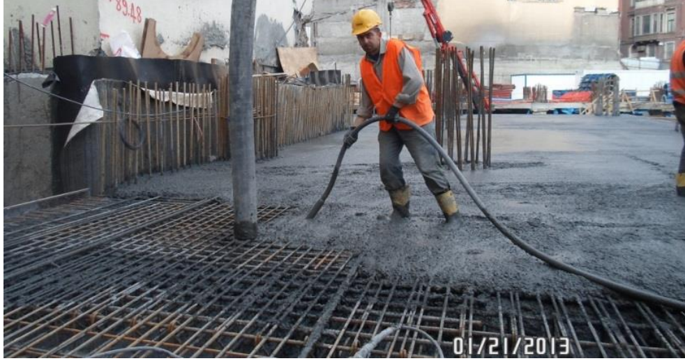
Şekil 6.15 : “Yarı-top-down” zemin kat döşemesinin betonlanması (M. T. Otel, 2012/13).
