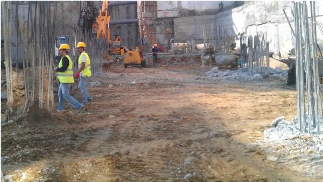
Şekil 6.7 : “Yarı-top-down” döşeme imalatı öncesi kazı yüzeyi tesviyesi (M. T. Otel, 2012/13).
