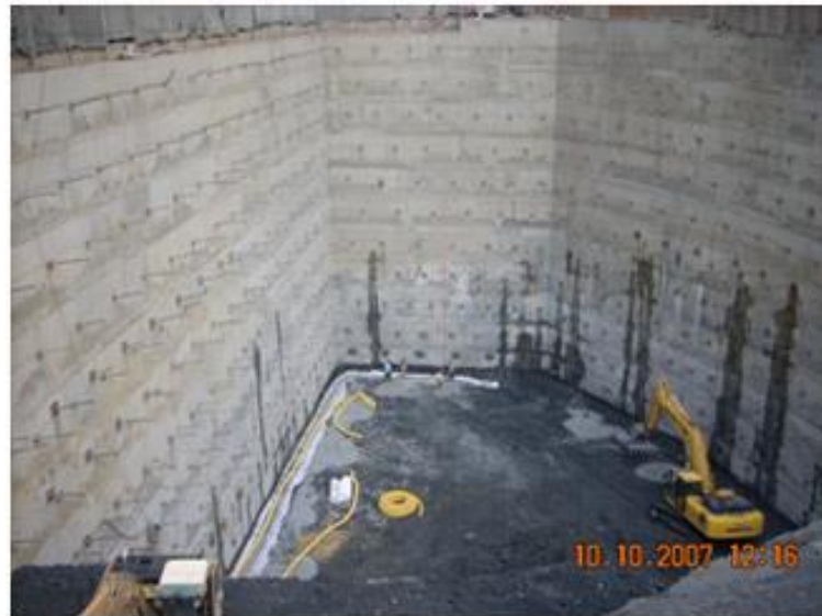
Şekil 3.34 : Ankrajlı aç-kapa betonarme perde [18].
