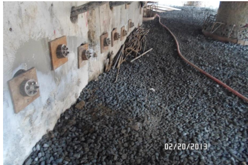
Şekil 6.19 : Kat içerisinde ikinci kademe ankrajlarının yapılması (M. T. Otel, 2012/13).
