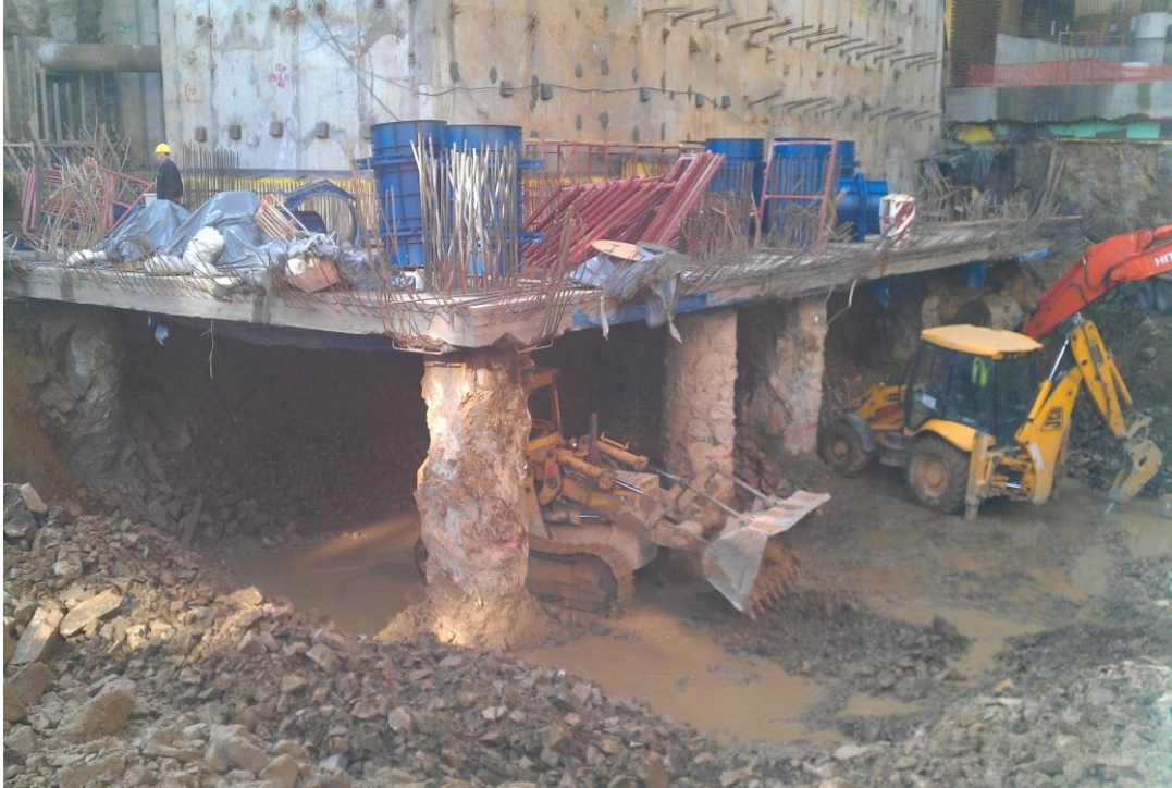
Şekil 6.17 : Yarı-top-down 1.bodrum kat kazısı (M. T. Otel, 2012/13).
