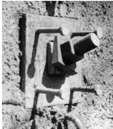
Şekil 3.62 : Geçici kaplama sonrası tek bir zemin çivisine ait görünüm [19].
