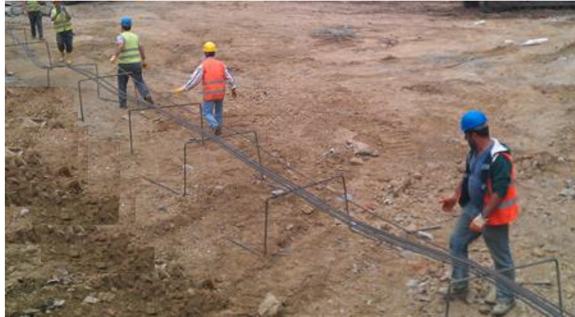
Şekil 3.43 : Öngermeli sarmal halat kesimi.
