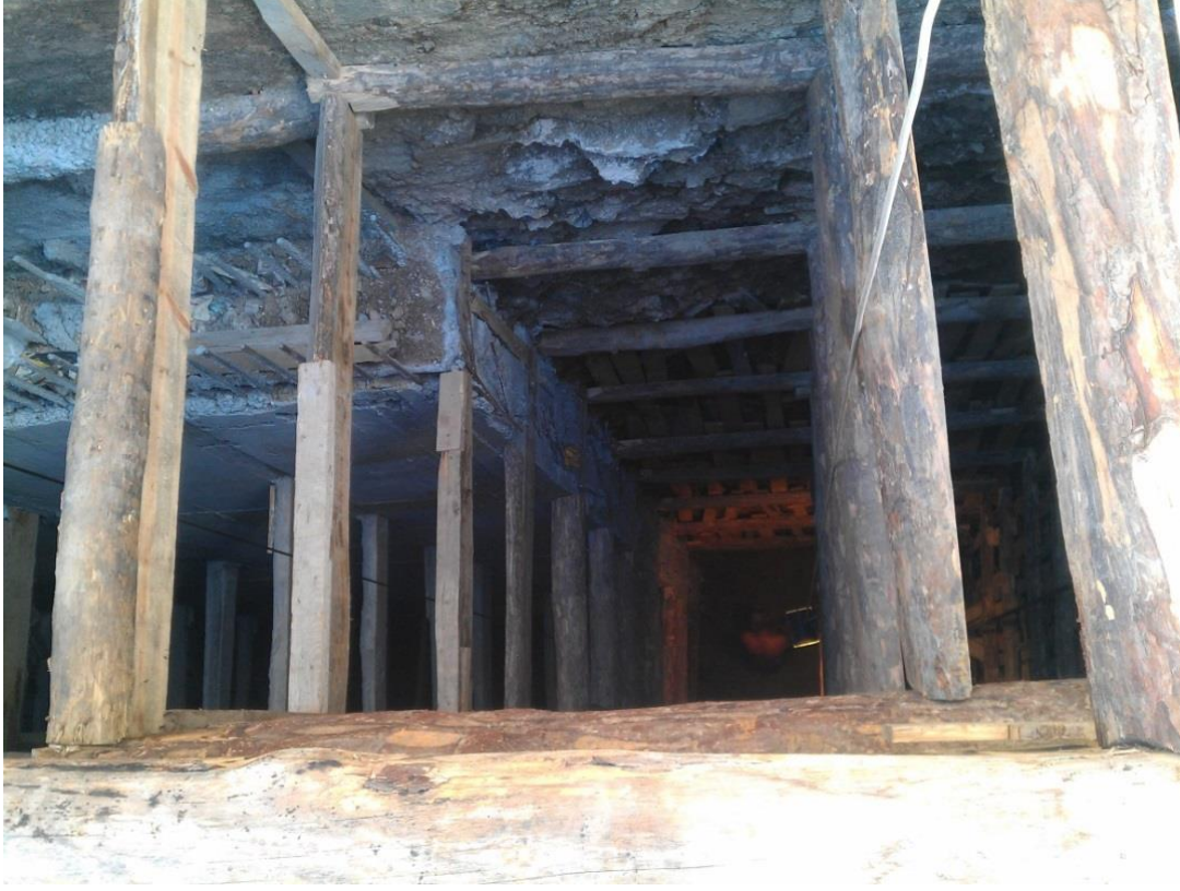
Şekil 3.30 : Betonlaması bitmiş kuyu perde ve kazısı bitmiş komşu kuyu.
