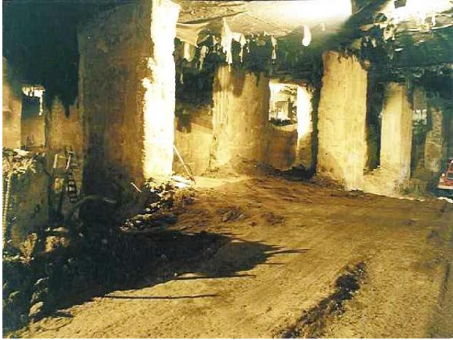
Şekil 5.14 : Top-down inşaat yöntemi ile kat kazısı [28].
