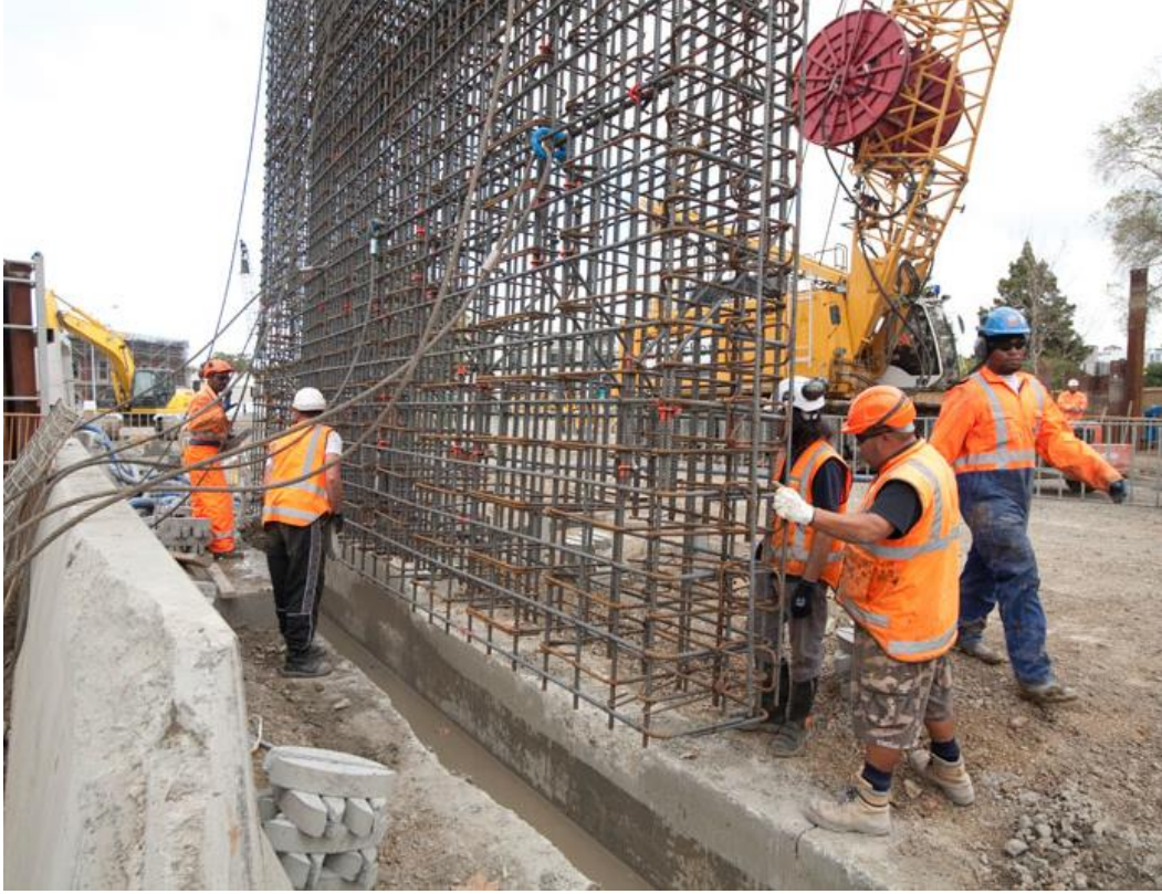
Şekil 3.20 : Diyafram perde paneline ait donatı kafesi montajı [14].
