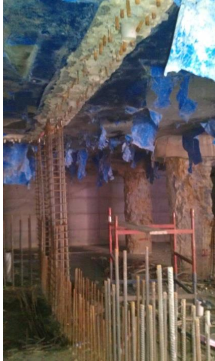
Şekil 6.31 : “Yarı-top-down döşemeleri”ndeki manşonlu donatı filizlerinin birleştirilerek anayapı perdesi haline getirilmesi.
