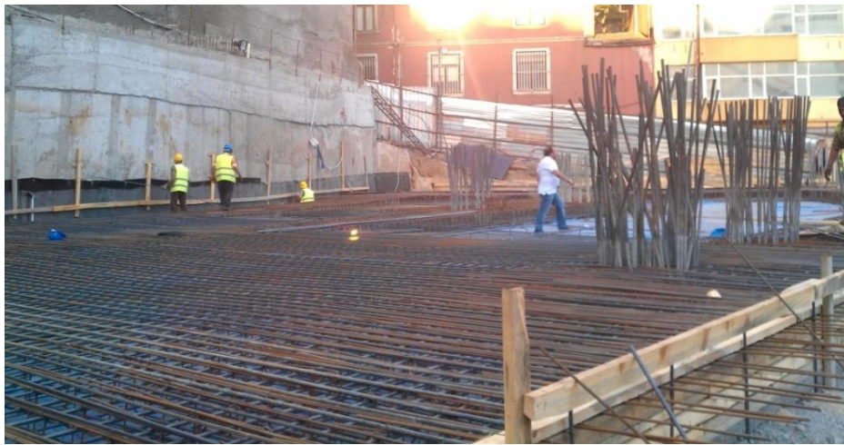
Şekil 6.14 : “Yarı-top-down zemin kat döşeme” donatılarının bağlanması (M. T. Otel, 2012/13).
