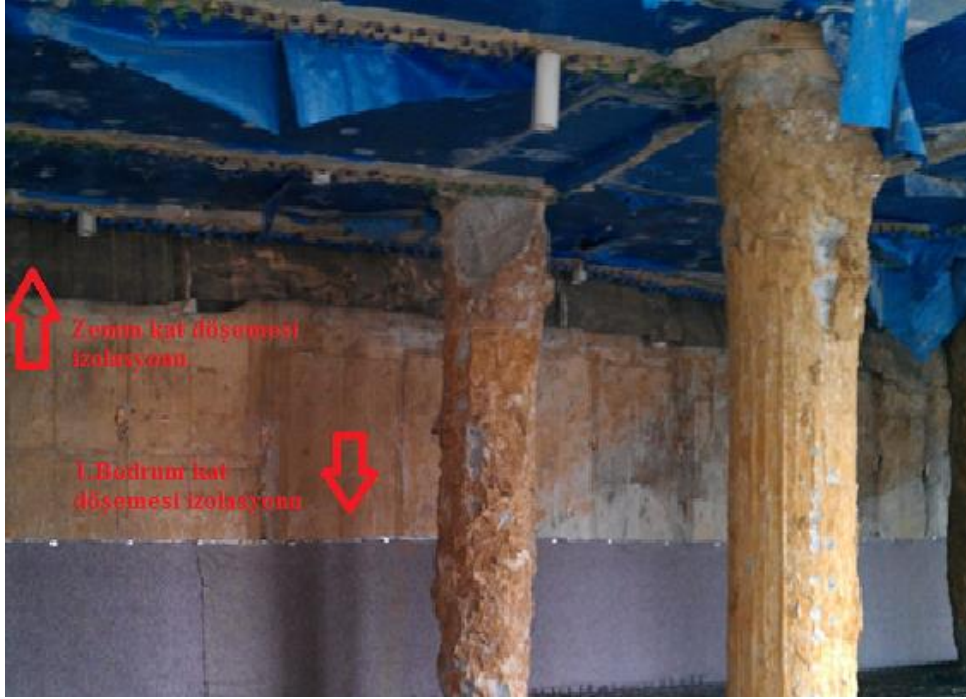
Şekil 6.24 : “Yarı-top-down 1.bodrum kat kazısı”nda iksa perdesi izolasyonunun sürdürülmesi (M. T. Otel, 2012/13).
