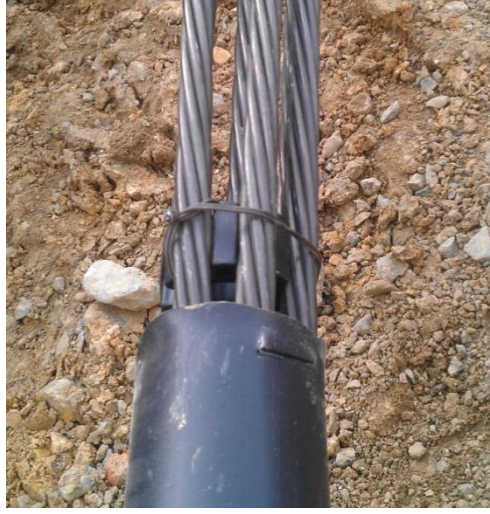
Şekil 3.45 : Serbest boyun kaplama borusu ile kaplanması.
