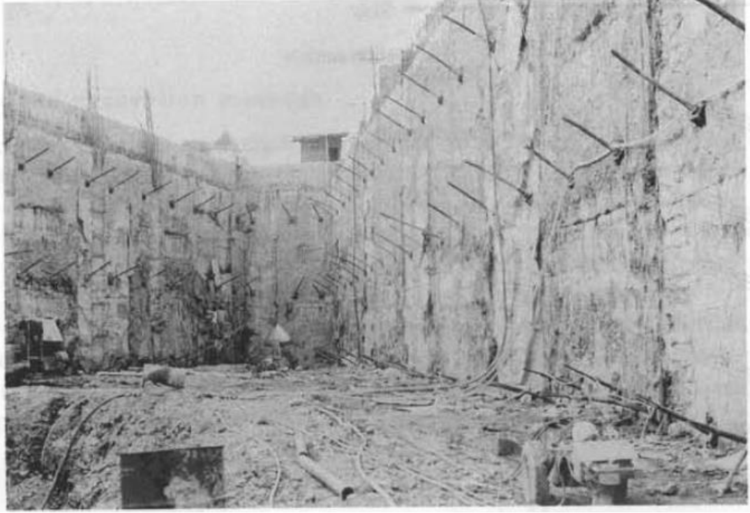
Şekil 5.5 : Öngermeli ankrajlı perde ile desteklenmiş kazı yöntemine bir örnek [10].
