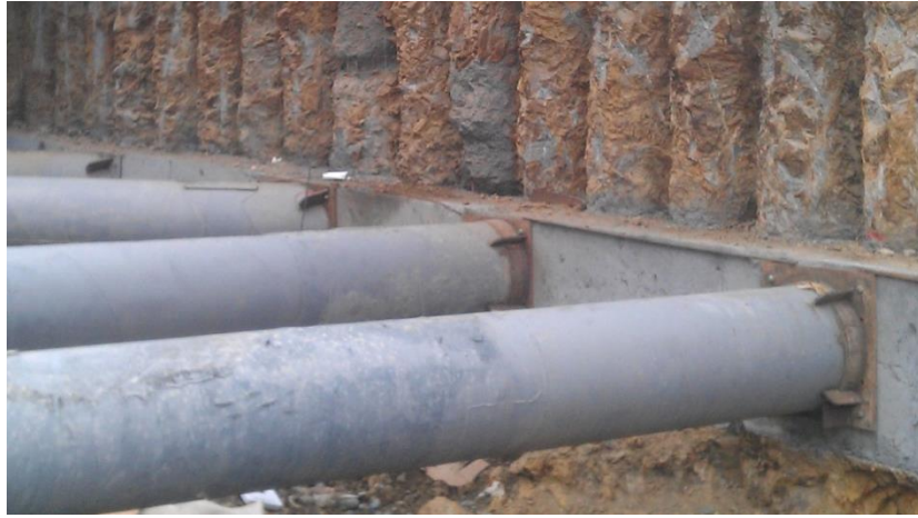
Şekil 3.64 : Boru desteklerin dayandığı kuşak kiriş.
