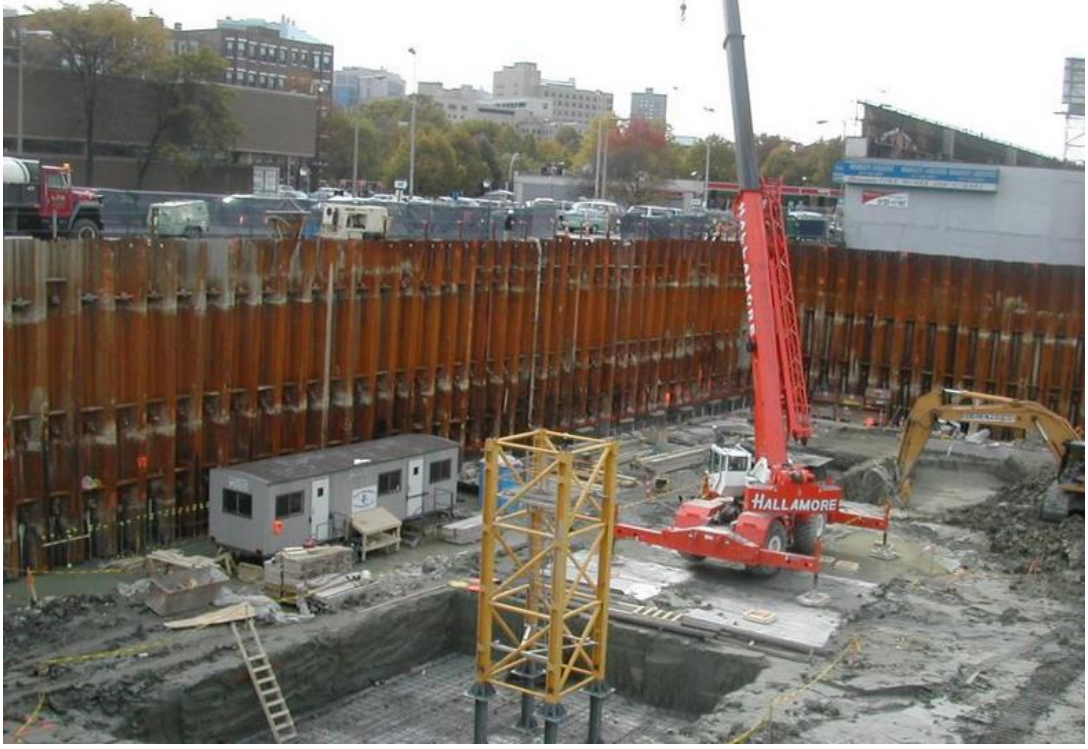
Şekil 3.27 : Ankrajlı palplanş perde (Boston, MA).
