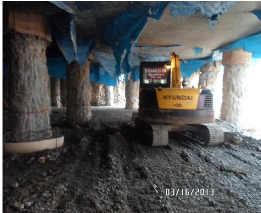
Şekil 6.23 : “Yarı-top-down 1.bodrum kat döşemesi” öncesi mıcır kullanarak zemin tesviyesi (M. T. Otel, 2012/13).
