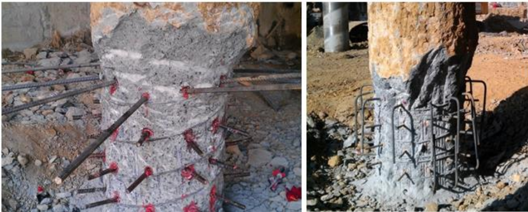
Şekil 6.21 : “Yarı-top-down kazıkları” ile döşeme bağlantısını sağlayacak donatıların epoksi ile kazığa yerleştirilmesi (M. T. Otel, 2012/13).
