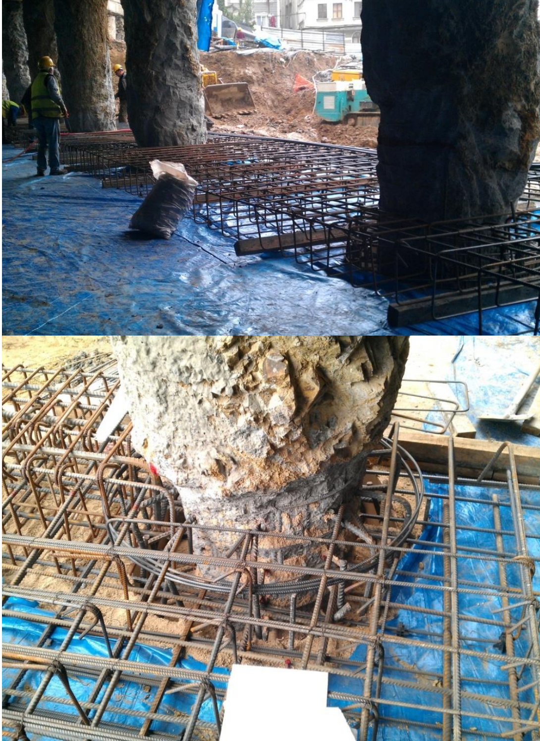
Şekil 6.27 : “Yarı-top-down 1.Bodrum kat döşemesine” ait donatıların bağlanması, döşeme ile kazıkların birleştirilmesi (M. T. Otel, 2012/13).
