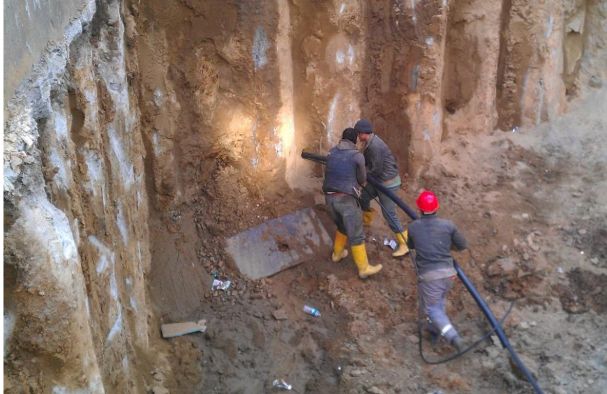
Şekil 3.48 : Ankraj tendonun delgi içerisine yerleştirilmesi (M. T. Otel, 2012).
