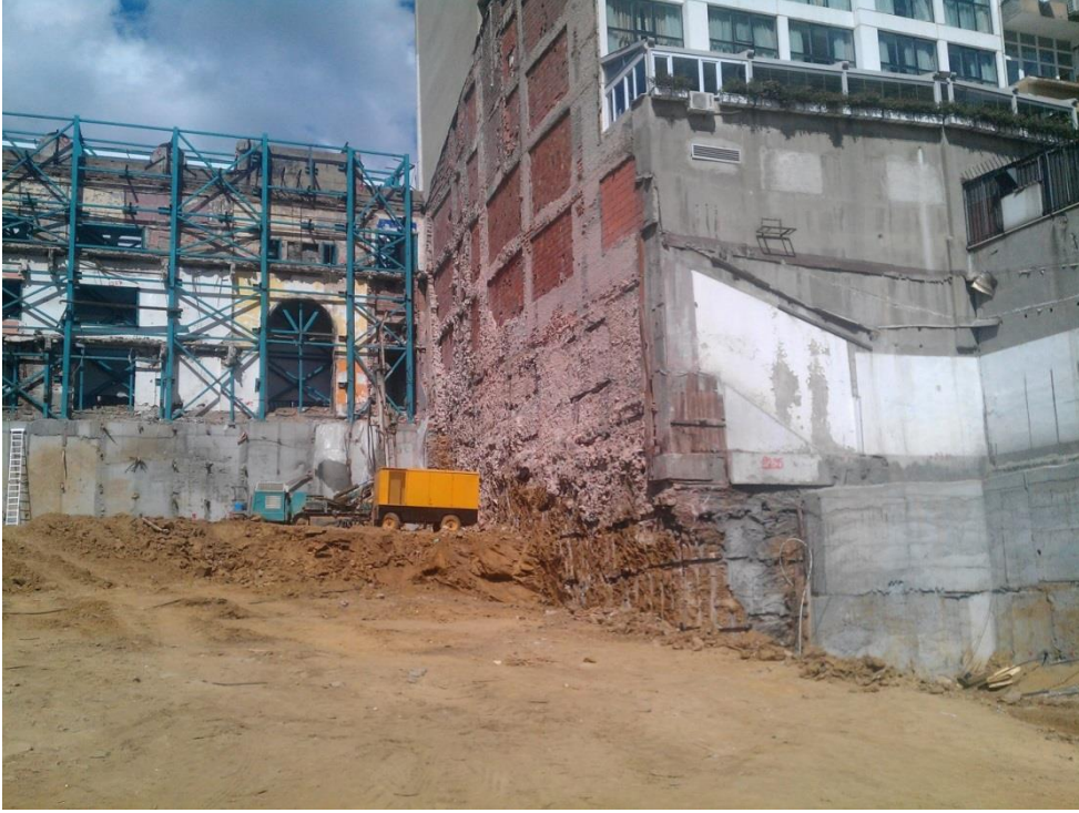
Şekil 3.28 : Kazı sahası sınırında komşu yapı varlığı (Maksim Tuna Otel, 2012).
