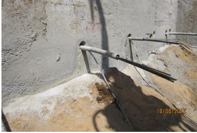
Şekil 3.49 : Enjeksiyonu tamamlanmış ankrajlar.
