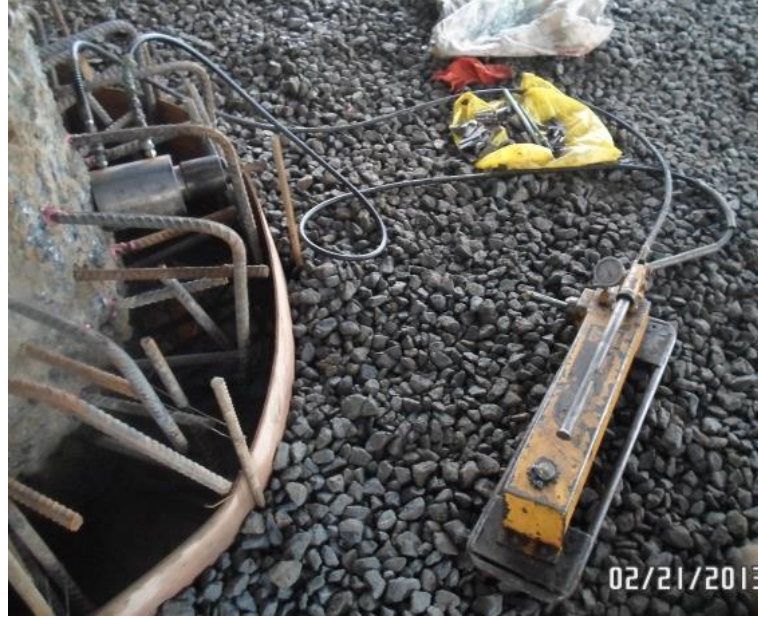
Şekil 6.22 : “Yarı-top-down kazıkları” ile “döşeme” bağlantısını sağlayacak donatıların test edilmesi (M. T. Otel, 2012/13).
