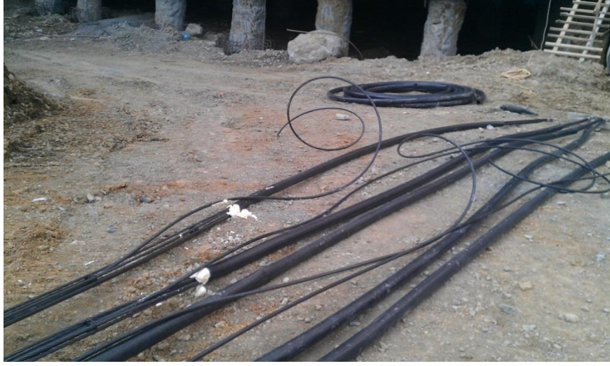
Şekil 3.47 : Ankraj demetine enjeksiyon hortumu montajı (M. T. Otel, 2012).
