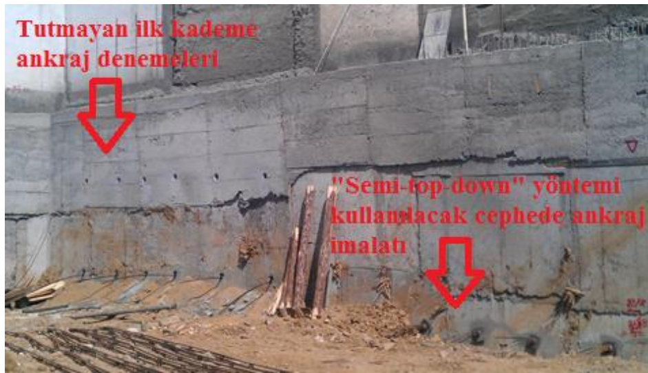
Şekil 6.3 : İlk kademe ankrajları yapılamamış ve “Yarı-top-down” yöntemine geçilmiş cephe (M. T. Otel, 2012/13).
