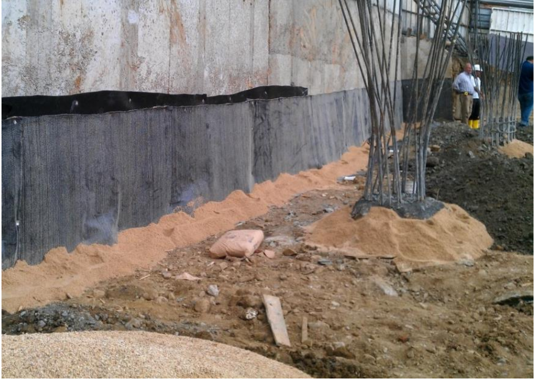
Şekil 6.8 : “Yarı-top-down” zemin kat döşeme imalatı öncesi perdenin izolasyon malzemesi ile kaplanması (M. T. Otel, 2012/13).
