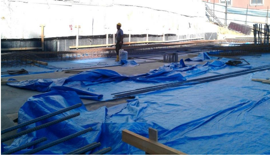
Şekil 6.13 : “Yarı-top-down döşemesi” ile “grobeton altlığı” ayıran izolasyon malzemesi (M. T. Otel, 2012/13).
