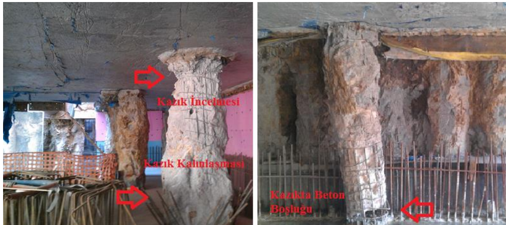
Şekil 6.6 : “Yarı-top-down” kazıklarında karşılaşılabilecek imalat problemleri (M. T. Otel, 2012/13).
