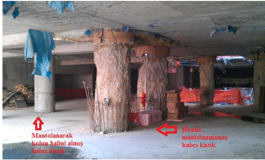
Şekil 6.30 : Yarı-top-down kalıcı kazıklarının mantolama ile anayapı kolonu oluşu.
