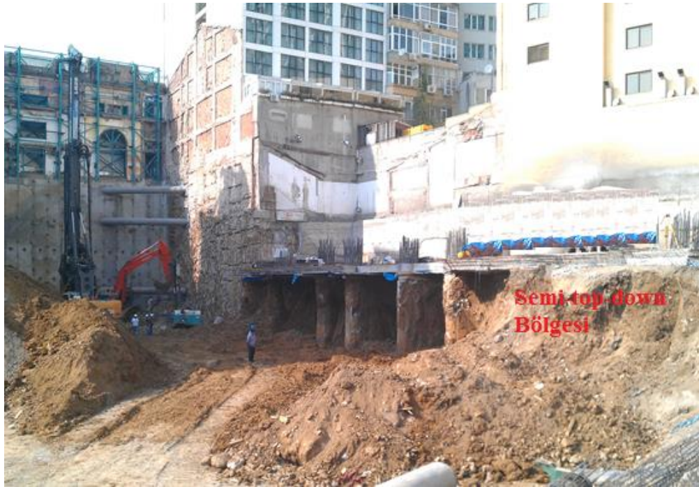
Şekil 5.15 : Yarı-top-down inşaat yöntemi ile kat kazısı (M. T. Otel, 2012/13).
