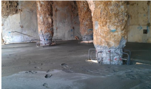
Şekil 6.12 : Yarı-top-down döşemeleri öncesi grobeton altlık (M. T. Otel, 2012/13).
