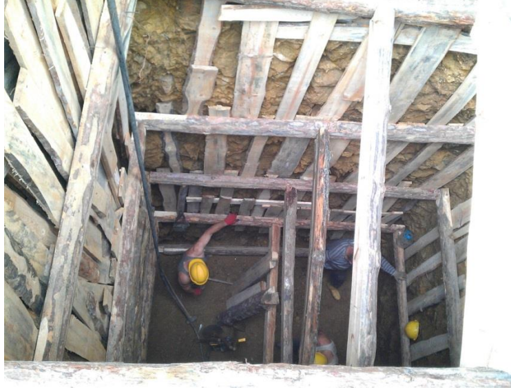
Şekil 3.29 : Kazı sırasında kuyu stabilitesi için kullanılan ahşap destekler.
