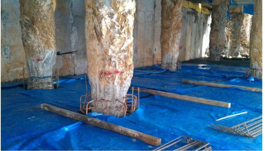
Şekil 6.26 : “Yarı-top-down” 1.Bodrum kat döşemesi imalatı öncesinde grobeton döşeme altlığı ve izolasyon kaplama (M. T. Otel, 2012/13).
