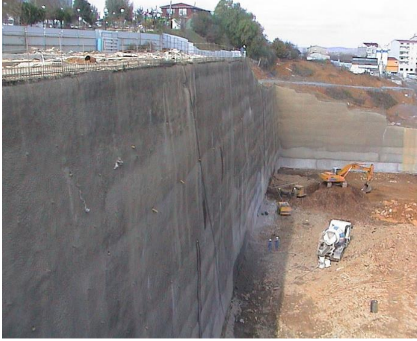
Şekil 3.36 : Zemin çivili püskürtme betonlu kaplama [18].
