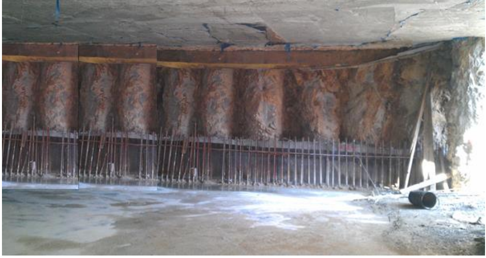
Şekil 6.2 : Yarı-top-down inşaatında kullanılan aralıklı dizilime sahip kazıklı perdenin kat içinden görünümü (Maksim Tuna Otel, 2012/13).
