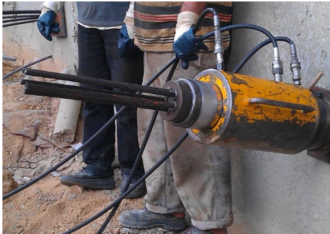
Şekil 3.50 : Ankraj tendonlarının germe makinesine yerleştirilmesi.
