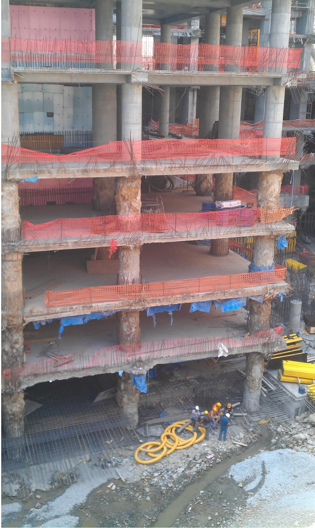
Şekil 6.29 : “Yarı-top-down” yöntemi ile temel seviyesine inilmiş bir inşaat çukuru (M. T. Otel, 2012/13).
