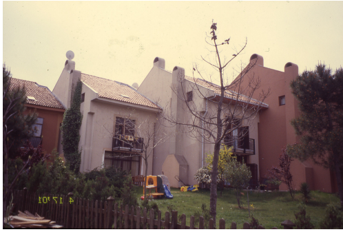
Resim 6.1.3-3: K tipi konut arka cephe görünüşü
