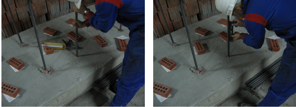
Şekil 2.20 Ankraj Donatısının Yeleştirilmesi ve Dikliğinin Ayarlanması
