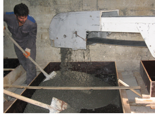
Şekil 2.10 Beton Mikserin Hazırlanması ve Beton Dökümü
