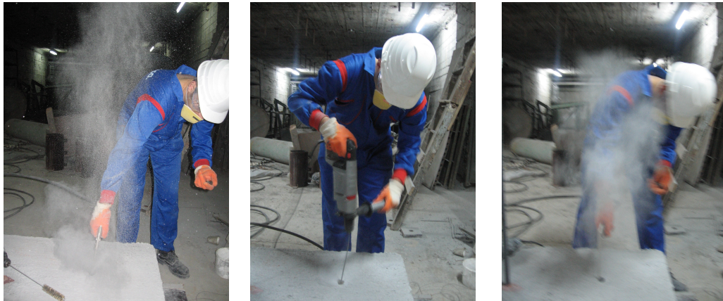
Şekil 2.17 Yüzey Hazırlık Aşamaları
