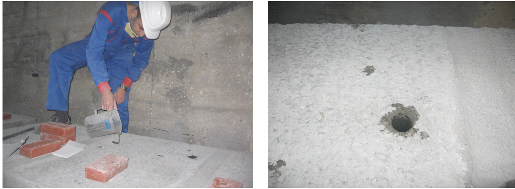
Şekil 2.18 Suya Doymun-Nemli Deliklerin Yüzey Hazırlık Aşamaları
