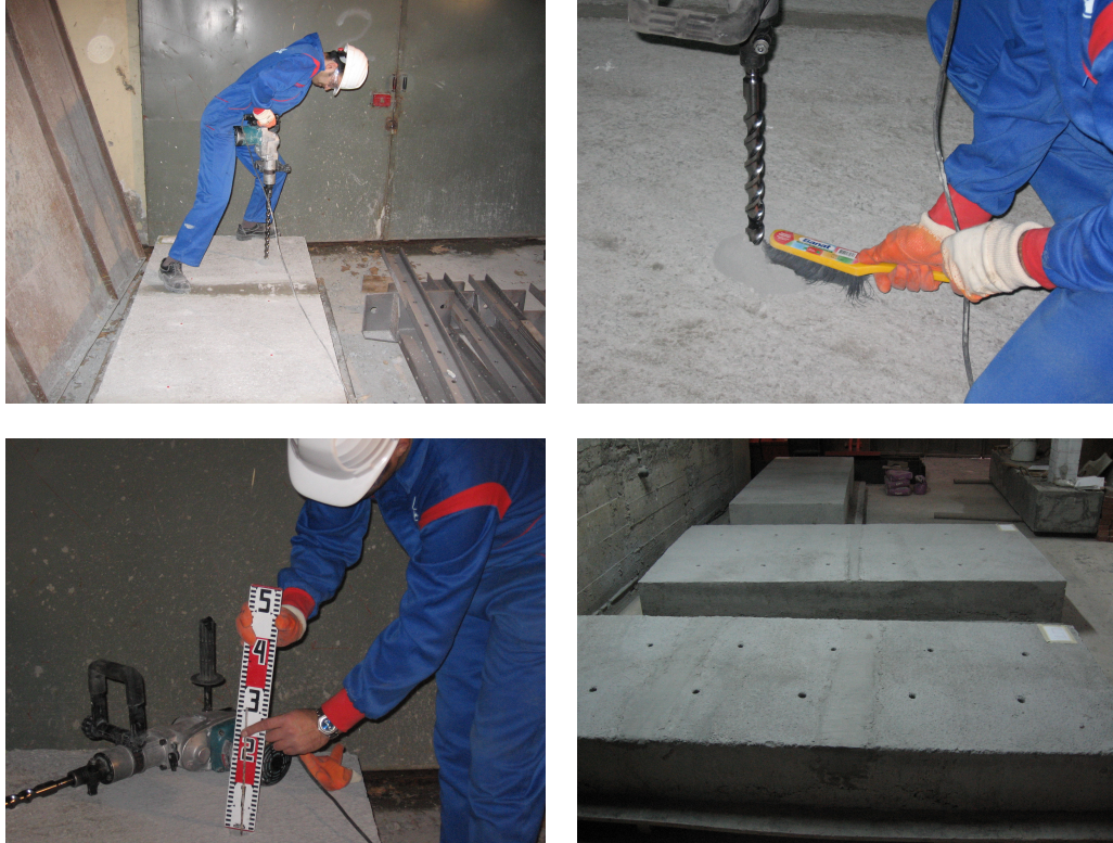
řekil 2.16 Ankraj Deliklerinin Aılması
