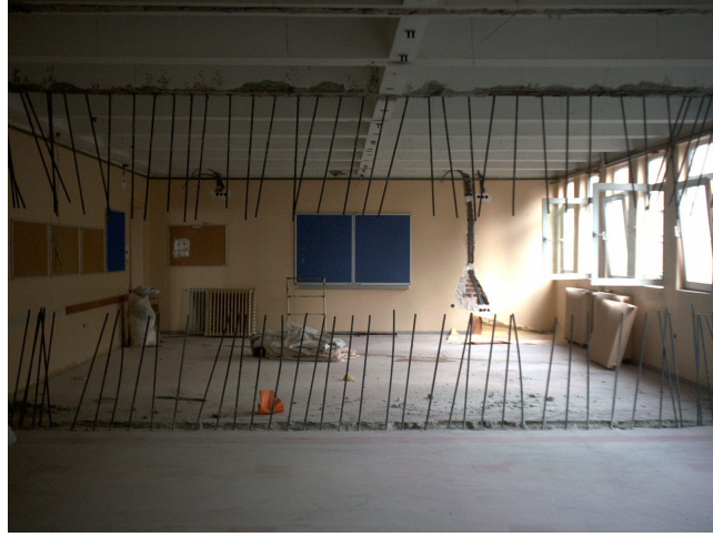
Şekil 1.2 Taşıyıcı Çerçeve Sisteme Perde İlavesi Yapılabilmesi İçin Yerde Uygulanmış Ankrajlar
