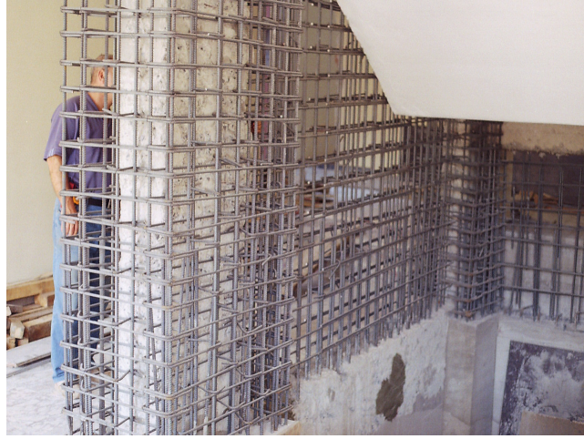
Şekil 1.1 Betonarme Sargı Uygulaması
