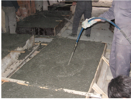
Şekil 2.11 Betonun Sıkıştırılması
