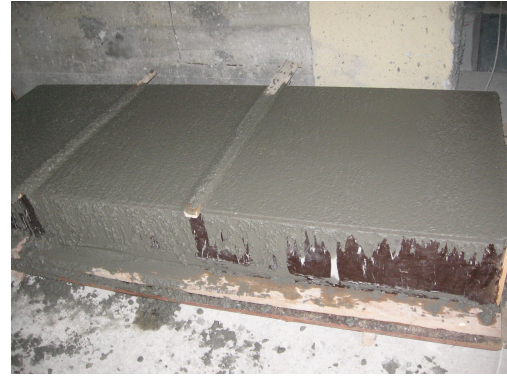
Şekil 2.11 Betonun Sıkıştırılması
