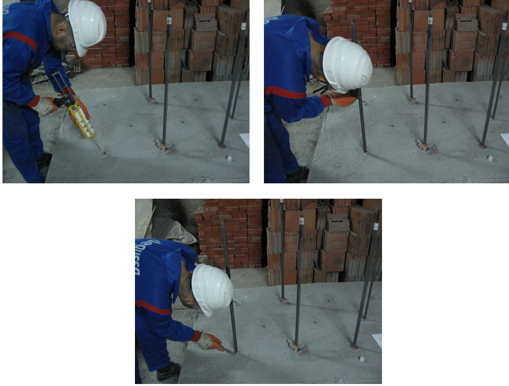
Şekil 2.21 M2 Malzemesinin Uygulanması
