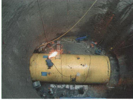
Şekil 8.4 Kesici kafa ve kalkan montajı bitmiş hali
