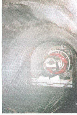
Şekil 8.7 Taban donatıları ve çelik bağın ayakları
