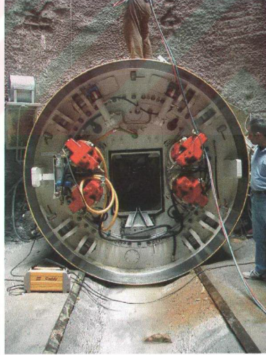
Şekil 8.3 Shaft tabanında kesici kafa
