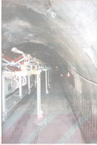
Şekil 8.11 Portal içinde back-up üniteleri
