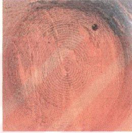
Şekil 7.3 TBM ile kazıda aynada oluşan tipik keski izleri
