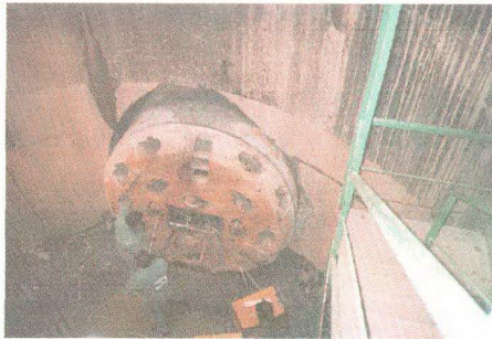
Şekil 12.8 S11 şaftında kesici kafada yapılan revizyon
