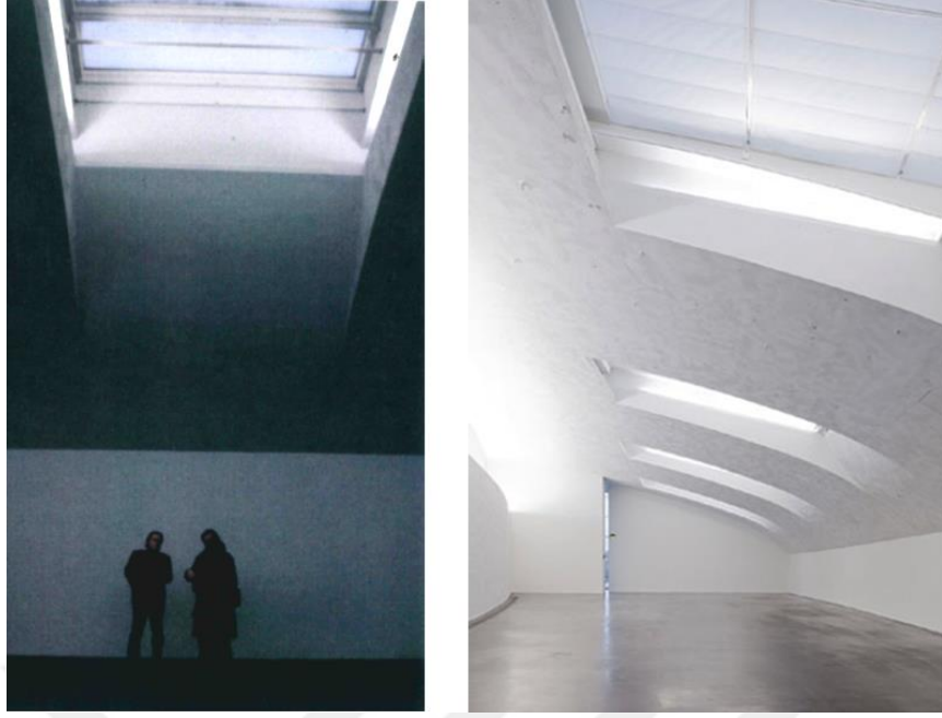
Şekil 4.4 : Beşinci galeri boşluğu flüoresan tüp montajı sırasında ve tamamlandıktan sonra (Descottes, Ramos, 2011, s. 113).
