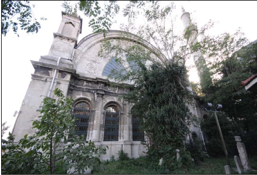
Şekil 5.71: Cihangir Camisi'nin Doğu cephesi ve süslemelerin görünümü,2014.
