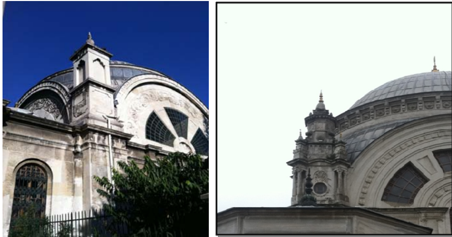
řekil 5.38 Solda Cihangir ve saęda Dolmabahe Camileri kře kulesi ,2015.
