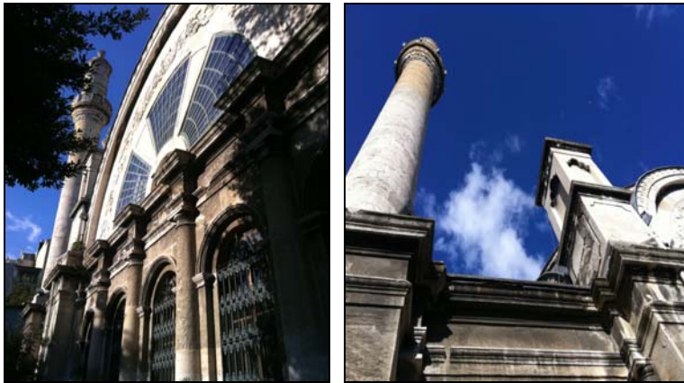
Şekil 5.69: Caminin cephelerini bölümlere ayıran gömme sütun ve plastırlar,2014.
