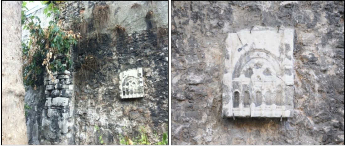
Şekil 5.31: Cihangir Camisi son cemaat yeri avlusunda istinad duvarı üzerindeki taş tablet.,2014.
