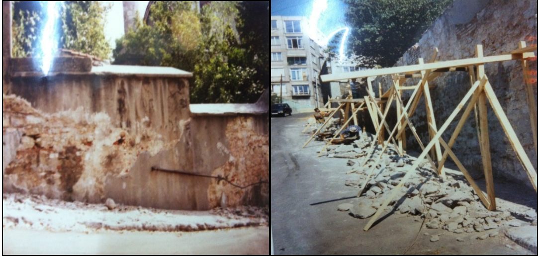
Şekil 5.19: Solda ve sağda Anıtlar Kurulu dosyasında 1993 yılındaki emanet onarımına ait fotoğrafta görülen orijinal taş-tuğla duvar örgüsü, Vakıflar Bölge Müdürlüğü.
