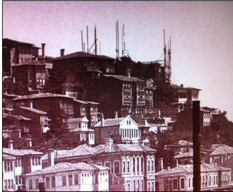
Şekil5.13: Üstte Guillaume Gustave Berggren'e ait Nusretiye Camisi fotoğrafında tepede Cihangir Camisi yapımı için kurulan iskele ve altta detayı,1885.
