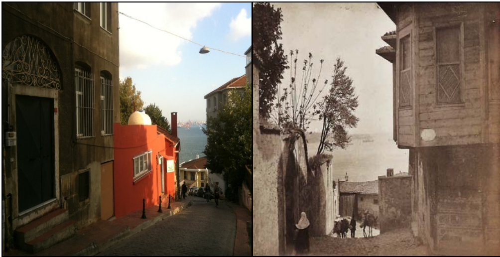
Şekil 5.28: Solda Cihangir Camisi batı girişi Samanyolu sokağı 21.yy, sağda 19..yy.daki hali.
