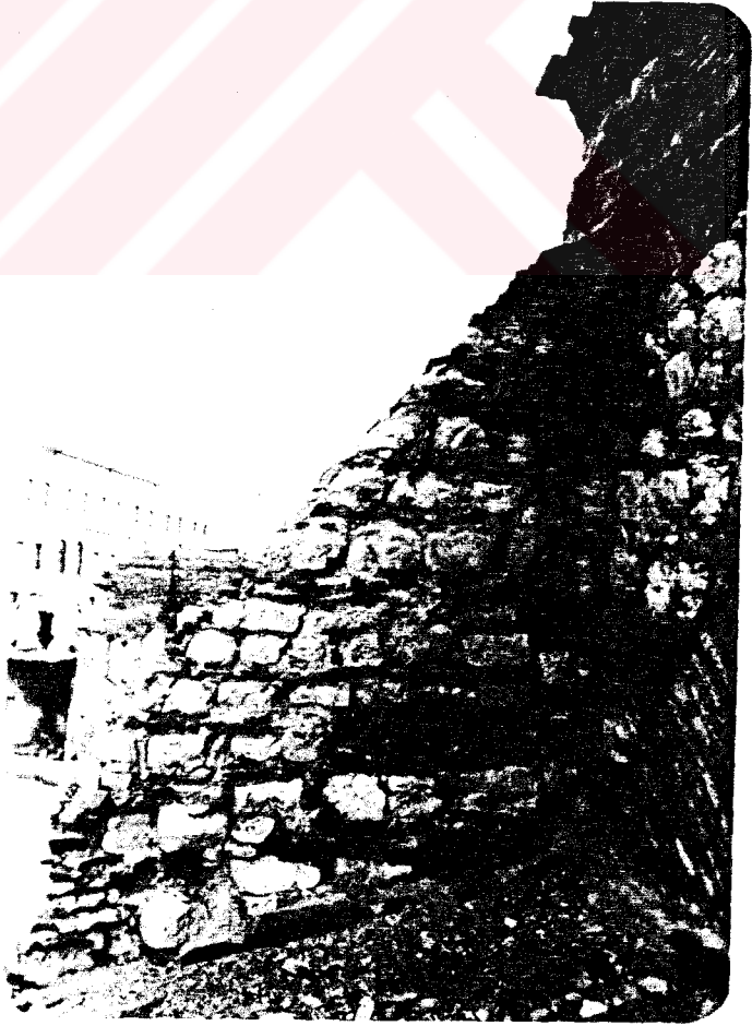
165. Batı cephesinin güney ucuna eklenen payanda.
