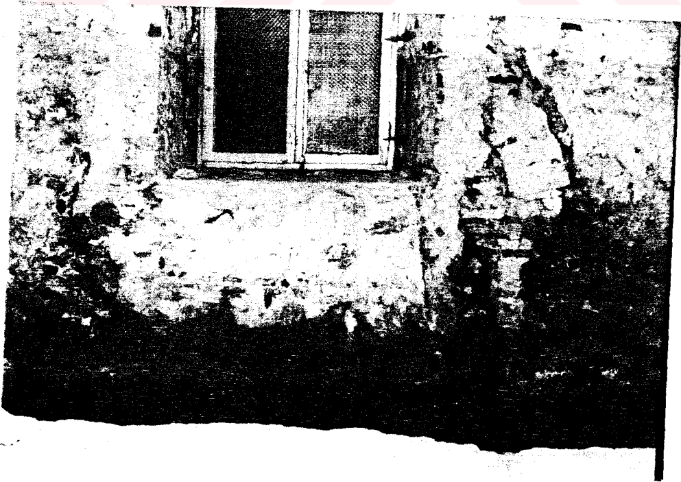
118. (F. 117'den ayrıntı) Pencerenin kuzeyindeki (4.5/30 cm) tuğla kemer izi.
