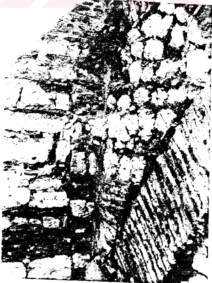
167. (F. 165'ten ayrıntı) Beden duvarlarının bitimi ve sonradan eklenen payanda arasındaki derz.
