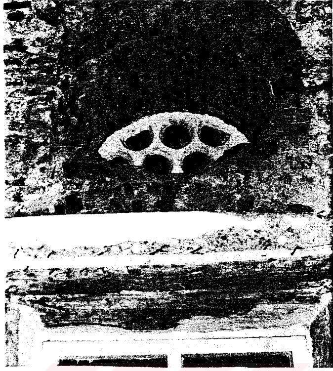
57. Oval pencere üstündeki 6/9/24 cm blok tuğla kemer.
