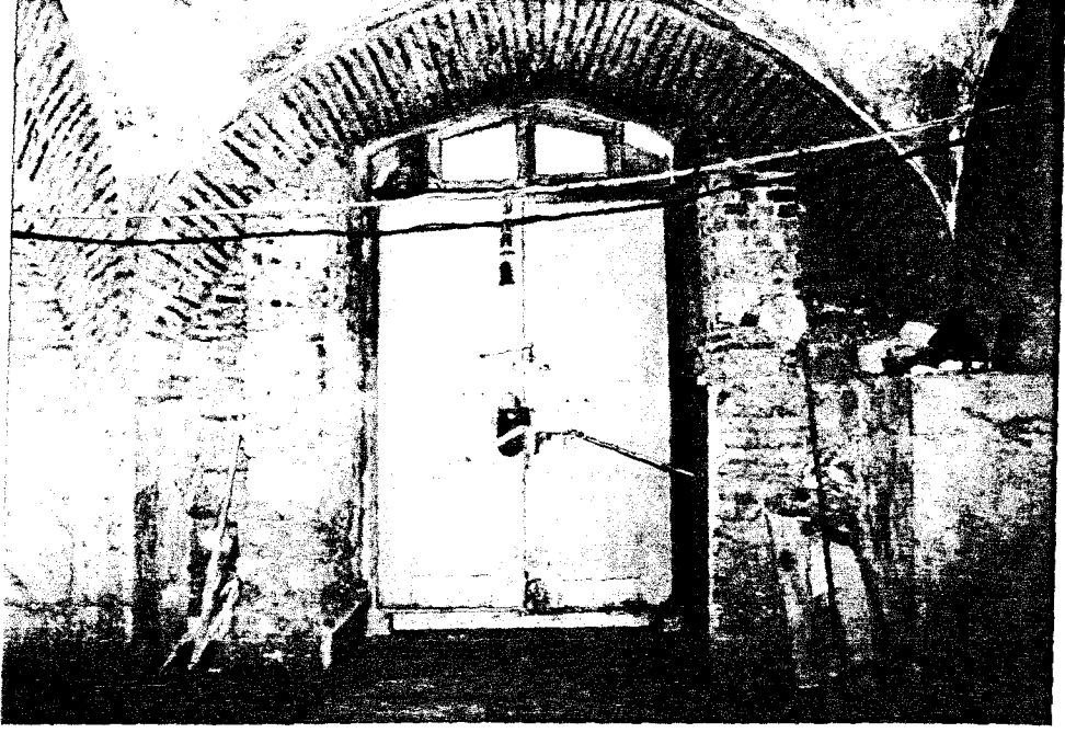
106. Giriş kapısının kanatlarının yaslandığı kanat genişlik ve yüksekliğindeki (d= 45 cm) duvar nişleri.
