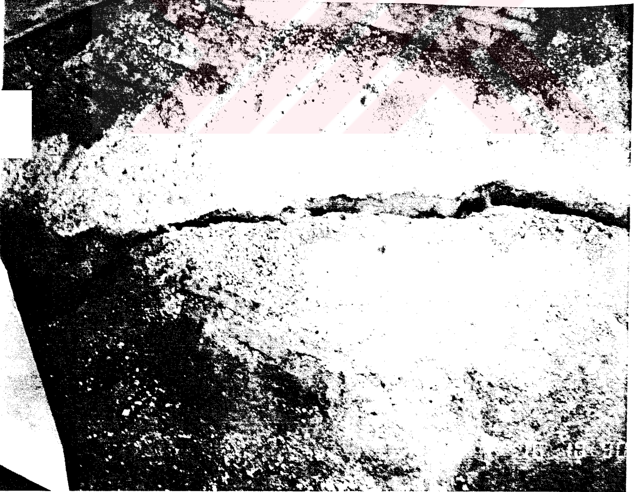
131. (F. 130'dan ayrıntı) Son cemaat yerinin I. ünitesinin 6 no.lu kubbesindeki çatlak.
