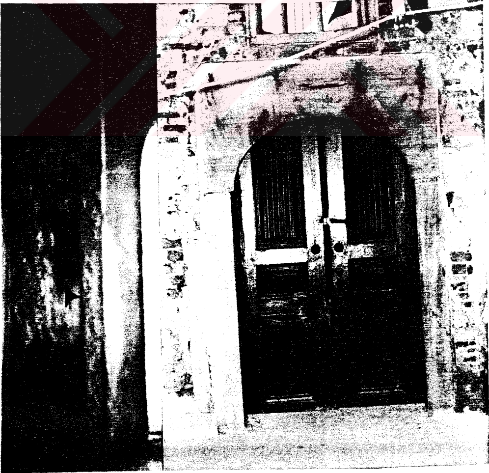
112. Basık kemer şeklinde biçimlenmiş ( d=8 cm) Marmara merverinden sövesi olan ( d=4.5 cm) ahşap kapı.
