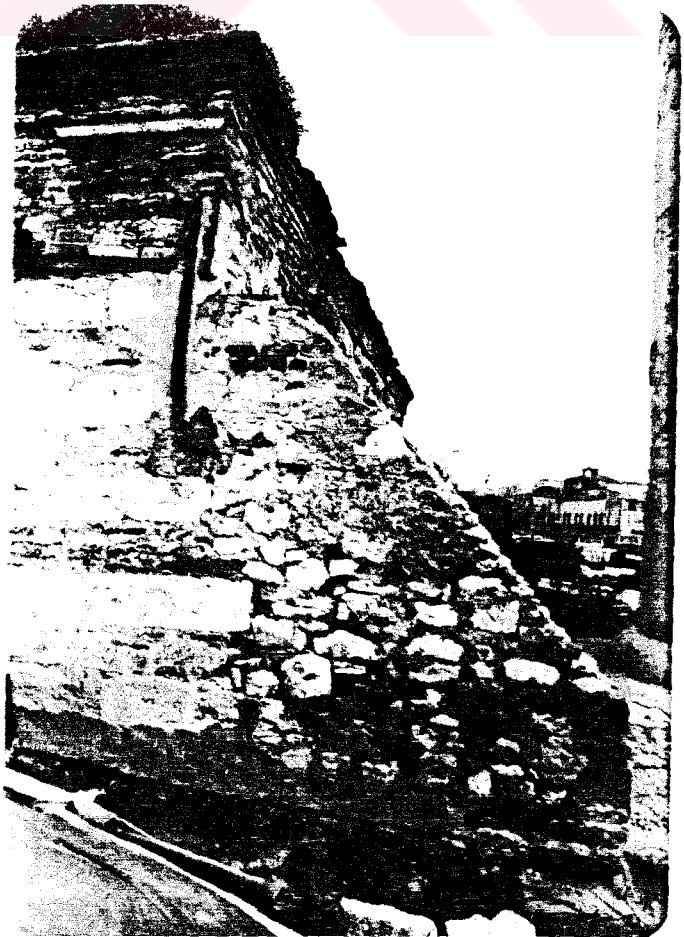
151. Kuzey cephesinin batısına eklenen moloz duvar payanda.
