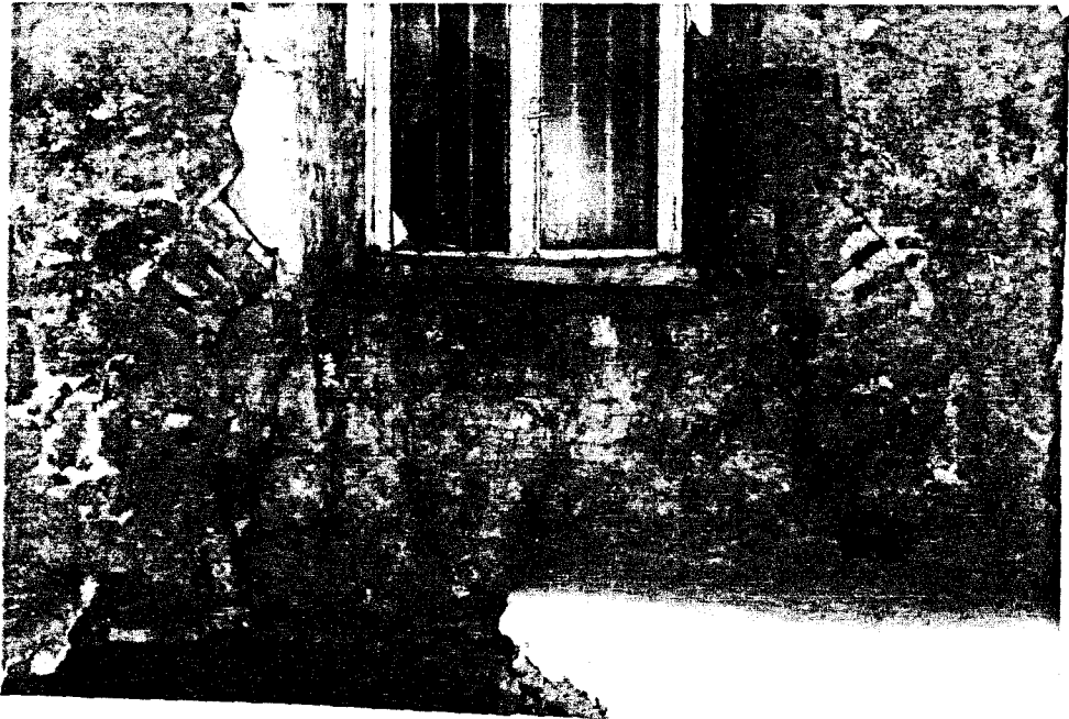
115. (F. 114'ten ayrıntı) Pencerenin altındaki (4.5/30 cm) tuğla kemer izi.
