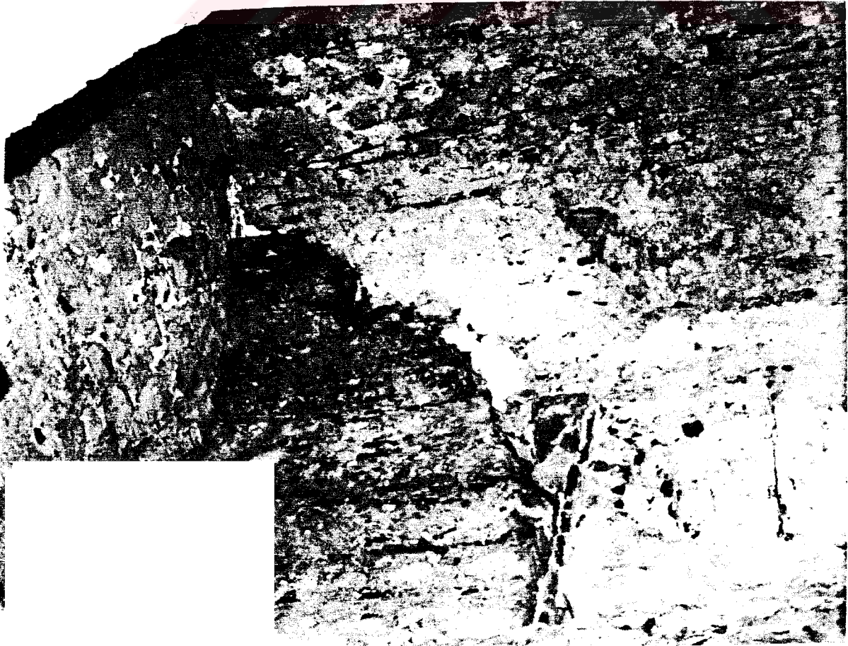
77. (F. 76'dan ayrıntı) Batı tonuzu ile güney payanda ilişkisi, tonozdaki ayrılma.
