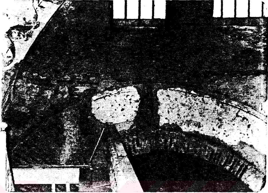
51. Sahın doęu duvarı boşaltmakemerlerinin kilit üstü noktasında duvara saplanan gergi.
