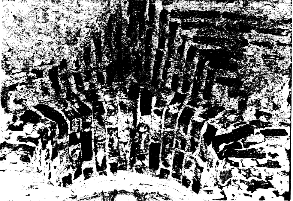
60. (F. 59'dan ayrıntı) Yan sahin oval pencere kemeri ile tonoz ilişkisi.
