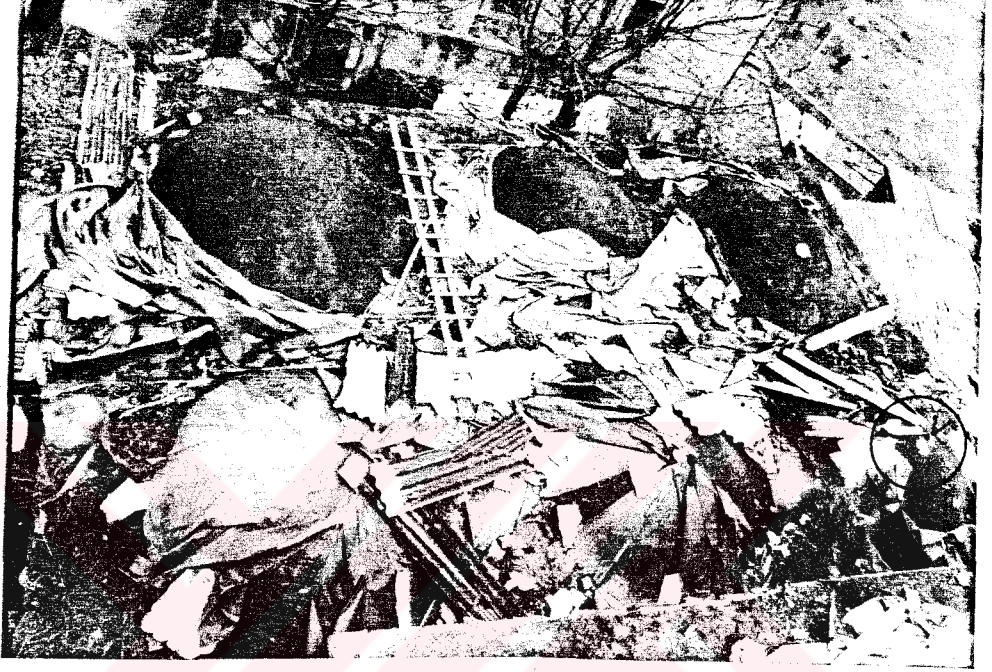
128. İki üniteli son cemaat yeri. II. ünite kubbelerinde kilit taşı yoktur.
