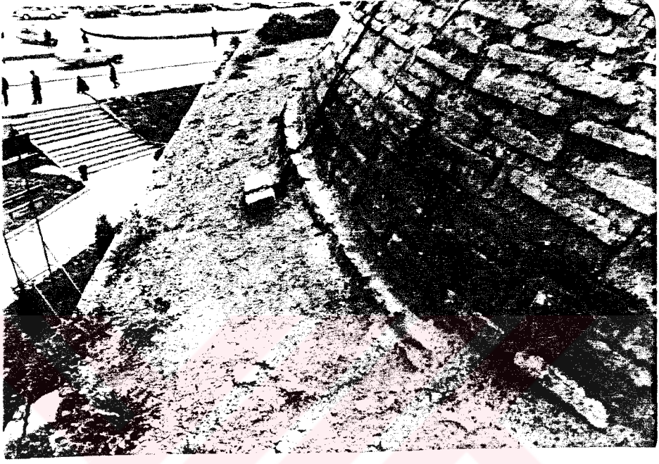
92. Ana kubbe eteğinin güneyinde 12-15 cm genişliğinde ve saçaktan 24 cm yüksekliğinde olan 4.5/35 cm'lik tuğladan yapılan kademe.
