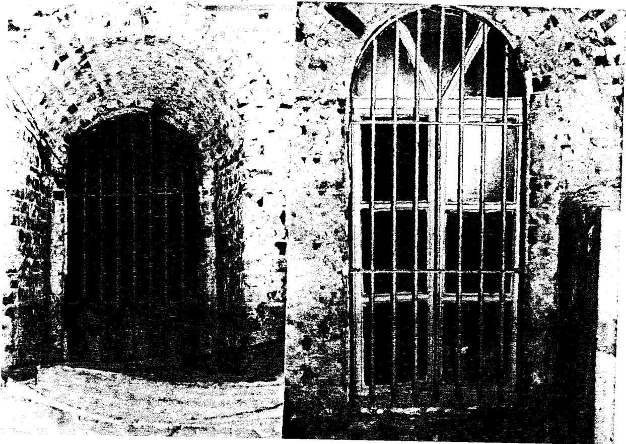
110. Sahın giriş kapısının iki tarafındaki pencereler.
