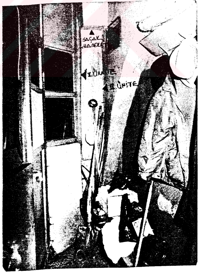
195. Son cemaat yerinin II. ünitesinin doğu cephesindeki dolgu duvarı 50 cm. geri çekilerek askı kemerinin içi boşaltılmıştır.
