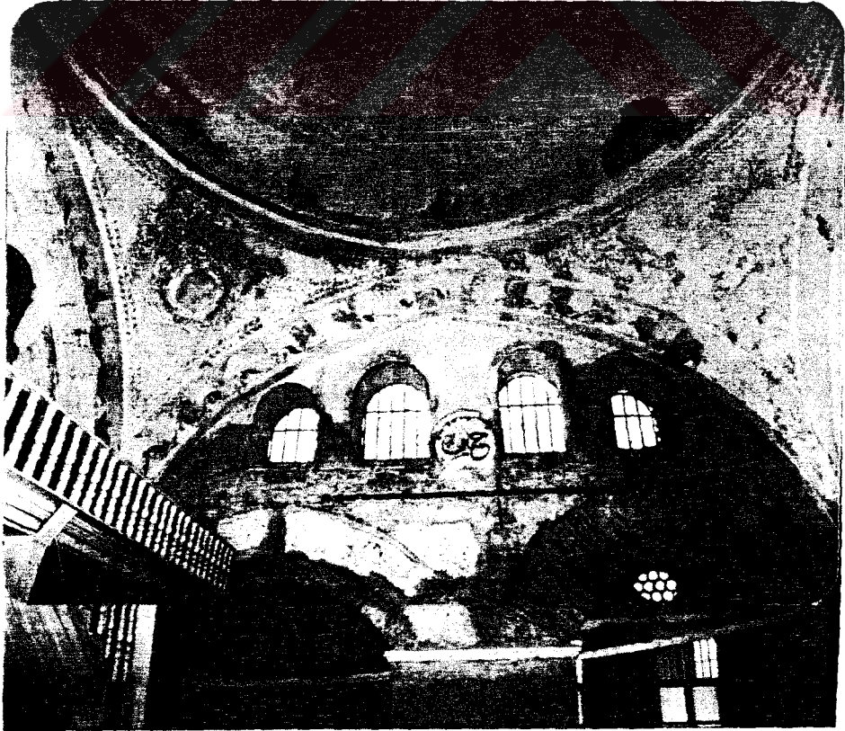
48. Sahın doğu duvarının 1990 yılı raspasından sonraki durumu. Tuğla kemerlerin altındaki ek kemerler
