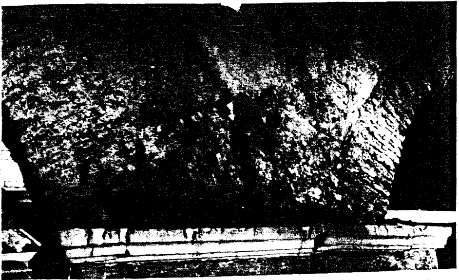
80. (F. 79'dan ayrıntı) Odtâşından yapılan atı atkı kemerleri ve altlarındaki 3/30/30 cm'lik tuğladan yapılan ek kemerler.
