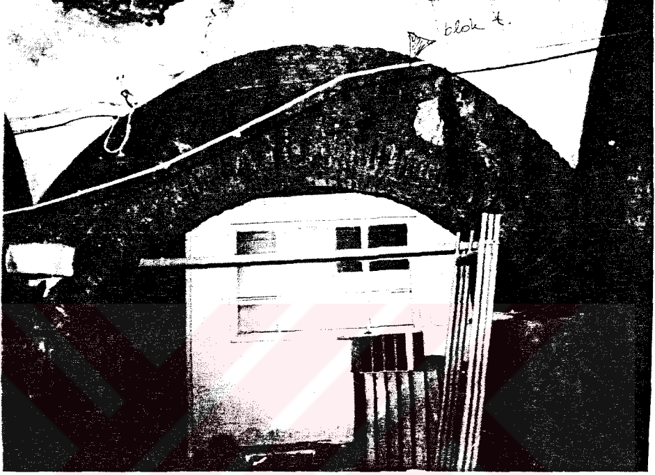
121. Doğu-batı doğrultusunda yeralan son cemaat yer askı kemerlerinin güney yüzeylerine konmuş klasik ve blok tuğla dolgu.
