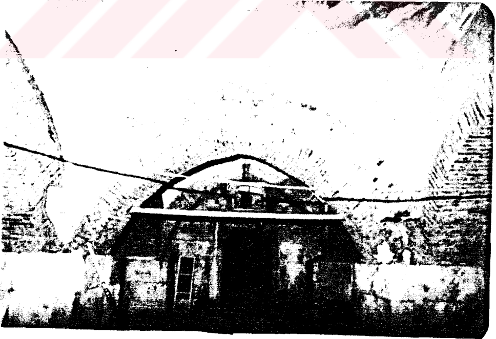
124. Son cemaat yerinin askı kemerleri ile ek kemerlerinin tuğla boyutları (3/30/30 cm) tutmakla birlikte kullanılan horasan harçları renk ve doku olarak birbirinden farklıdır. Ek kemerlerdeki horasan harcı daha kırmızıdır ve içinde lifli katkı maddeleri ile iri beyaz kireç topakları gözlenmektedir.
