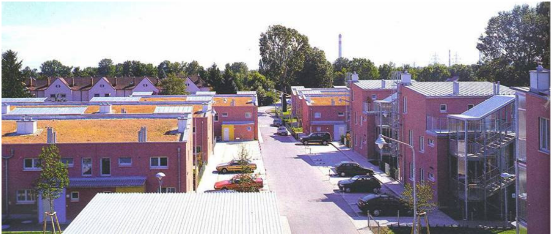
Şekil 2.5: Aspern an der Sonne Konut Kompleksi, Kuzeyden görünüş (Cephe, 2001/01)
