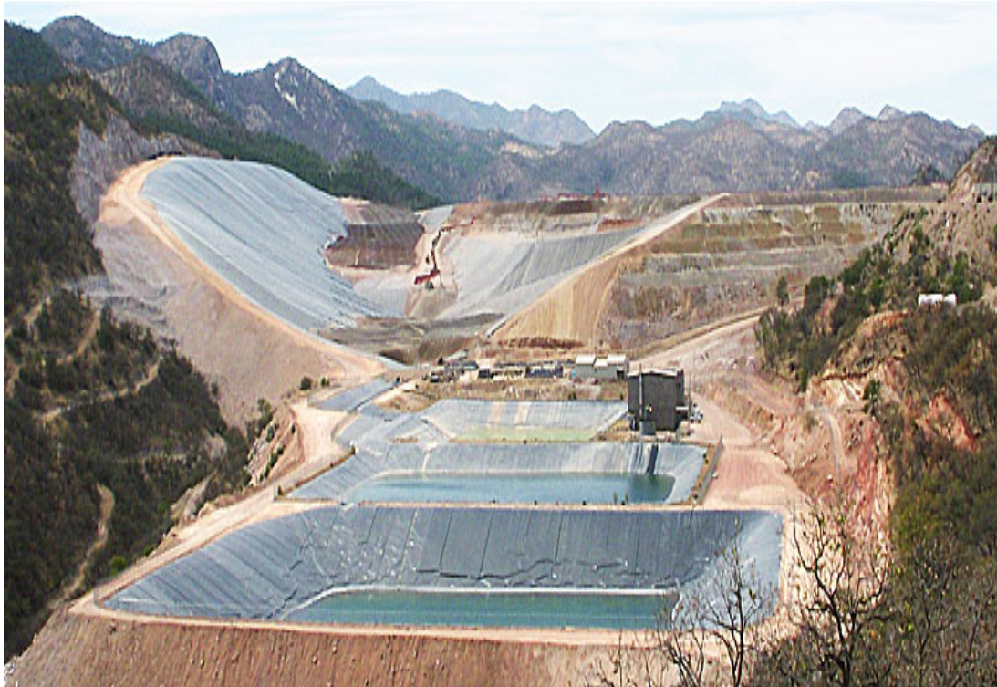
Şekil 2.9 : Endüstriyel boyutta yığm liçi yapan bir tesis [24].
