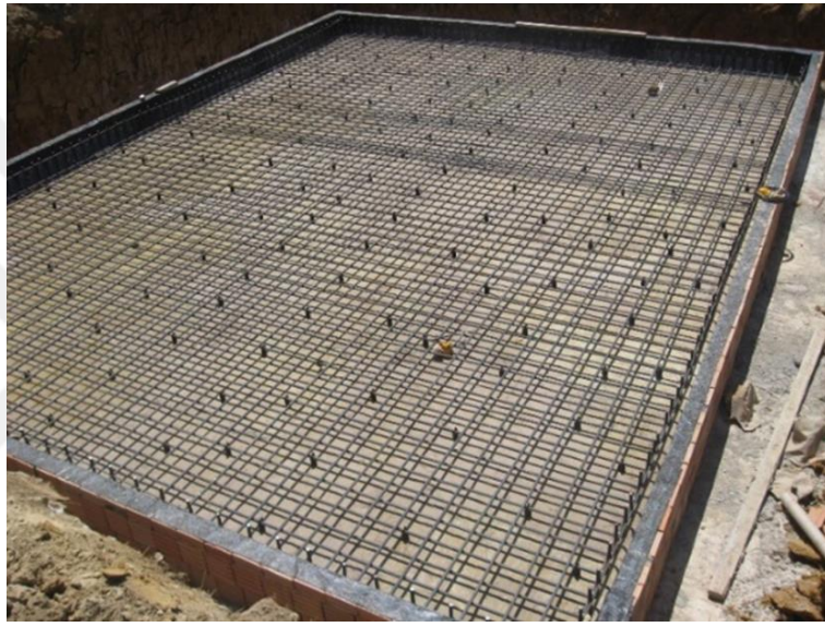
Şekil C.1 : Tedarik-Hızlandırılmış İnşaat/ Elektriksel İşler-Trafo görselleri-1.
