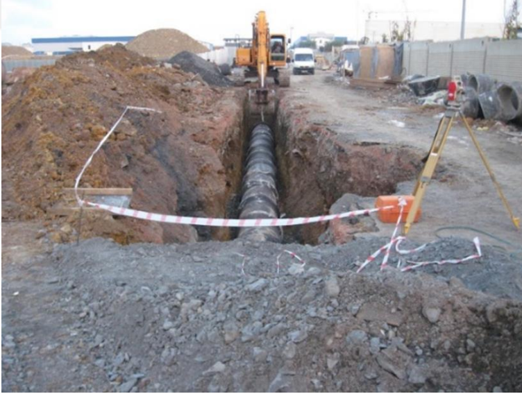
Şekil B.4 : Tedarik-Hızlandırılmış İnşaat/Yağmur Suyu Boru Hattı görselleri-4.
