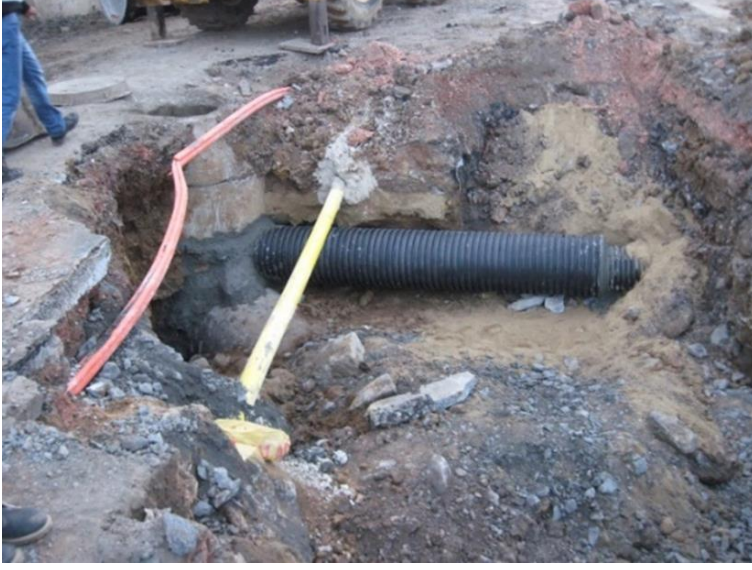
Şekil B.3 : Tedarik-Hızlandırılmış İnşaat/Yağmur Suyu Boru Hattı görselleri-3.
