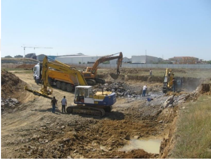
Şekil A.1 : Tedarik-Hızlandırılmış İnşaat/Hafriyat görselleri-1.
