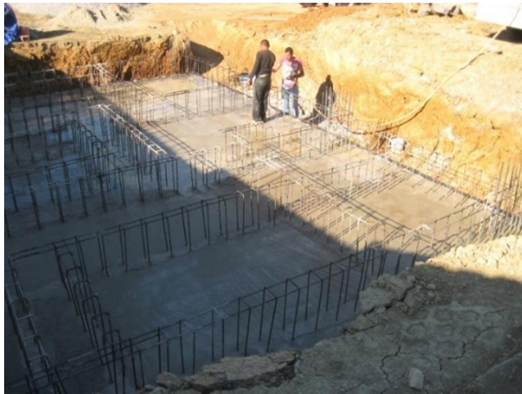
Şekil C.2 : Tedarik-Hızlandırılmış İnşaat/ Elektriksel İşler-Trafo görselleri-2.
