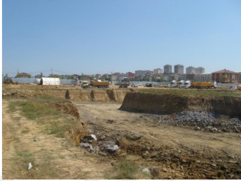
Şekil A.3 : Tedarik-Hızlandırılmış İnşaat/Hafriyat görselleri-3.
