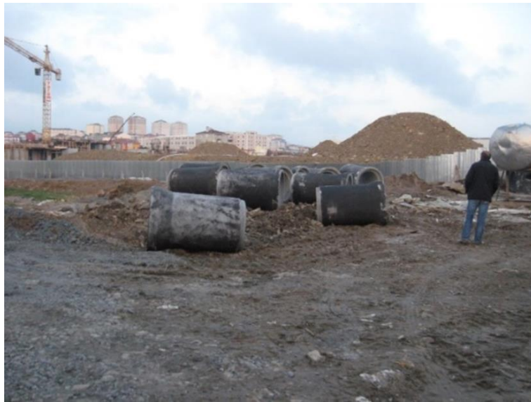
Şekil B.2 : Tedarik-Hızlandırılmış İnşaat/Yağmur Suyu Boru Hattı görselleri-2.
