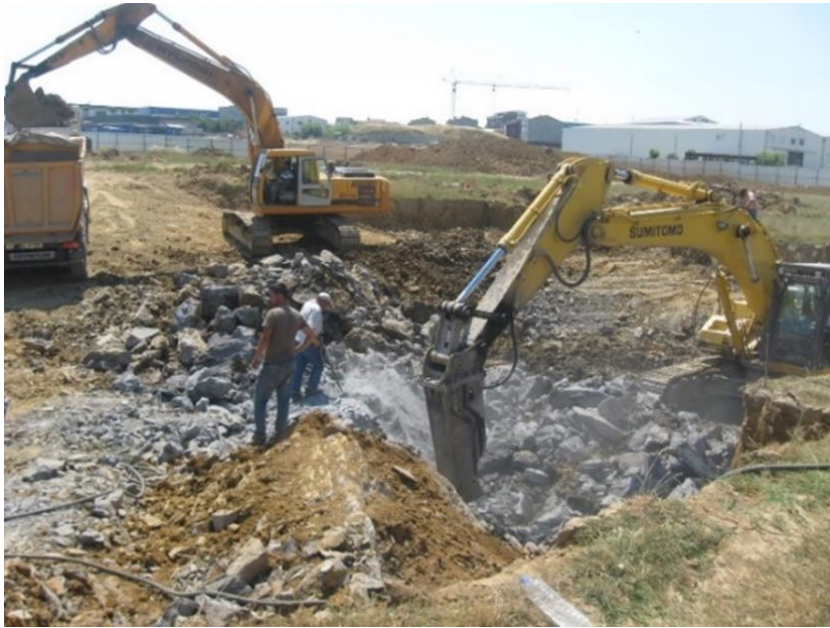
Şekil A.2 : Tedarik-Hızlandırılmış İnşaat/Hafriyat görselleri-2.
