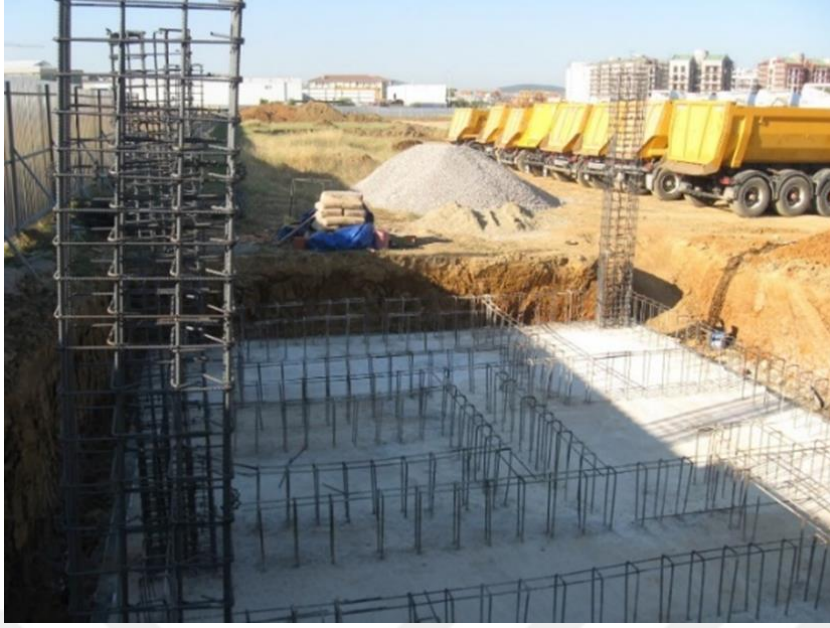
Şekil C.3 : Tedarik-Hızlandırılmış İnşaat/ Elektriksel İşler-Trafo görselleri-3.
