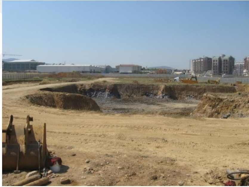
Şekil A.4 : Tedarik-Hızlandırılmış İnşaat/Hafriyat görselleri-4.
