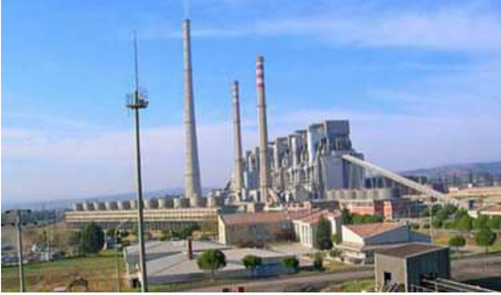
Şekil 1.45 : Soma Termik Santrali[69].
