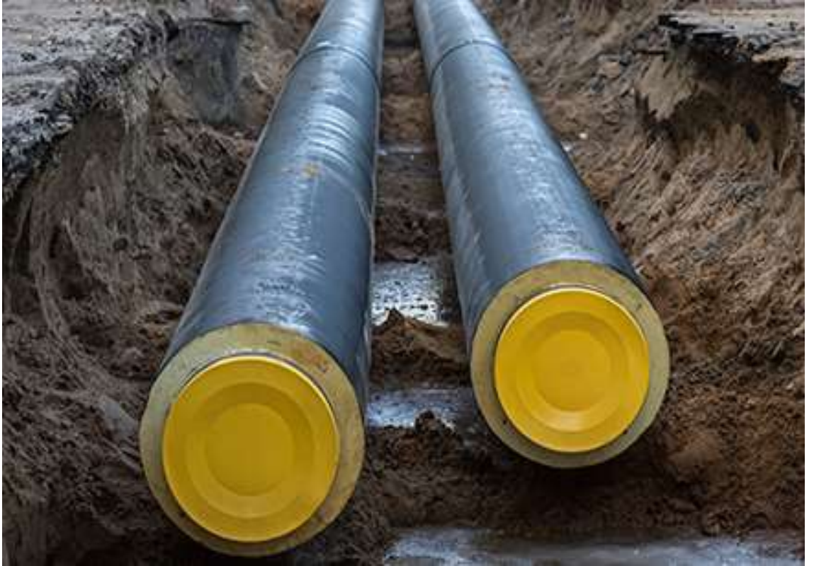
řekil 1.42 : Blgesel Isıtma Sisteminin Yalıtımlı Daęıtım Boruları[44].
