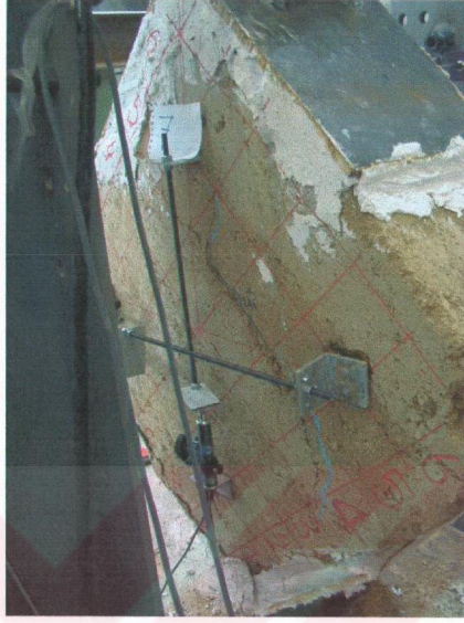
Şekil A.27. Numune 2'nin arka yüzünde 7 tonda oluşan çatlaklar
