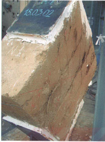
Şekil A.19. Numune 1'in arka yüzünde 10 tonda oluşan çatlaklar
