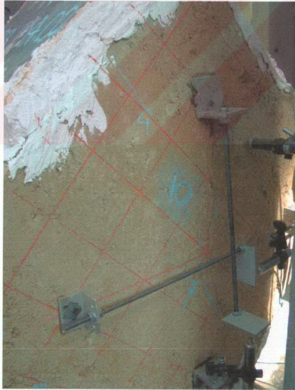
Şekil A.38. Numune 3'ün arka yüzünde 10 tonda oluşan çatlaklar
