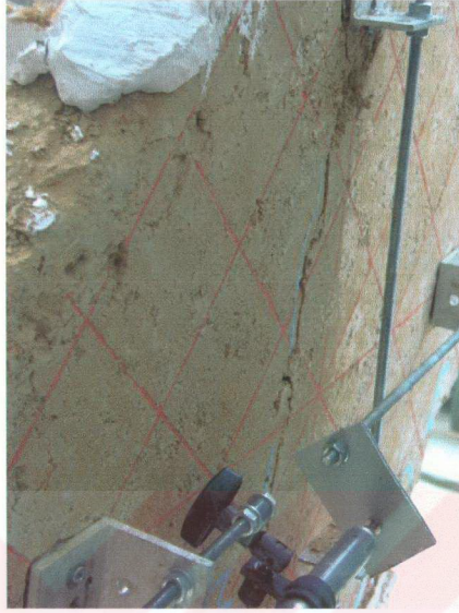
Şekil A.39. Numune 3'ün ön yüzünde 11 tonda oluşan çatlaklar
