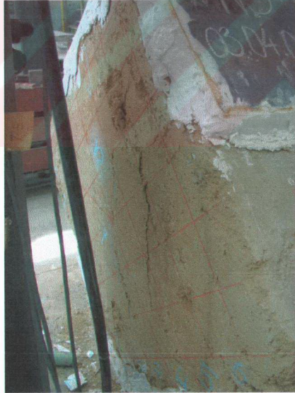
Şekil A.42. Numune 3'ün arka yüzünde 11,5 tonda oluşan çatlaklar
