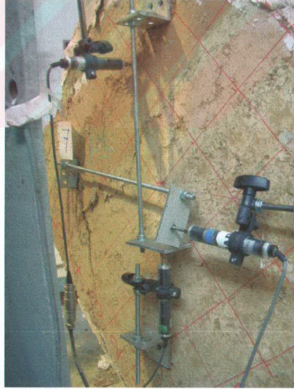
Şekil A.26. Numune 2'nin ön yüzünde 7 tonda oluşan çatlaklar
