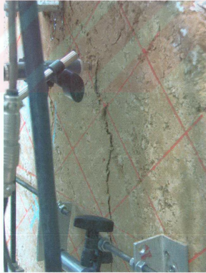
Şekil A.40. Numune 3'ün arka yüzünde 11 tonda oluşan çatlaklar
