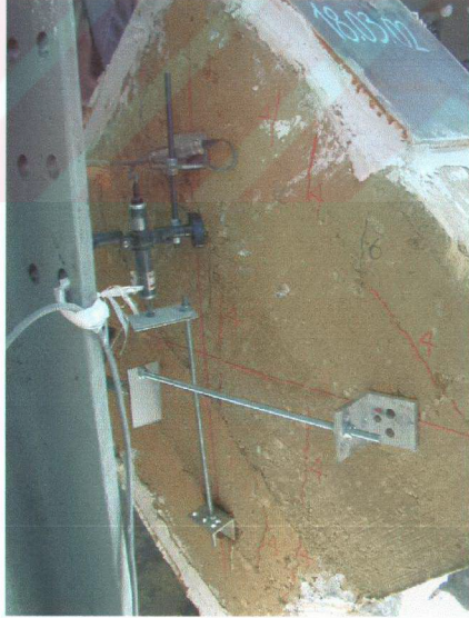
Şekil A.14. Numune 1'in ön yüzünde 6 tonda oluşan çatlaklar
