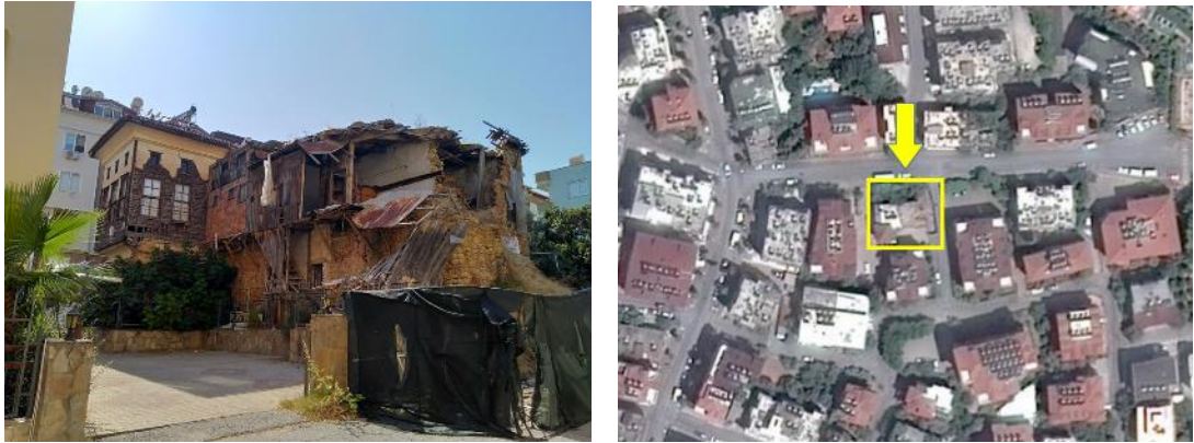
Şekil 2.7 : 244/59 parselindeki tarihi yapı.
