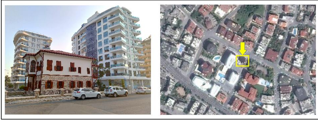
Şekil 2.1 : 671 Ada 2 Parsel No.lu taşınmaz üzerindeki tarihi yapı.
