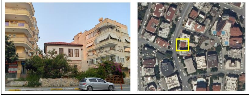
Şekil 2.3 : 19/30 No.lu parsel üzerindeki tarihi yapı.
