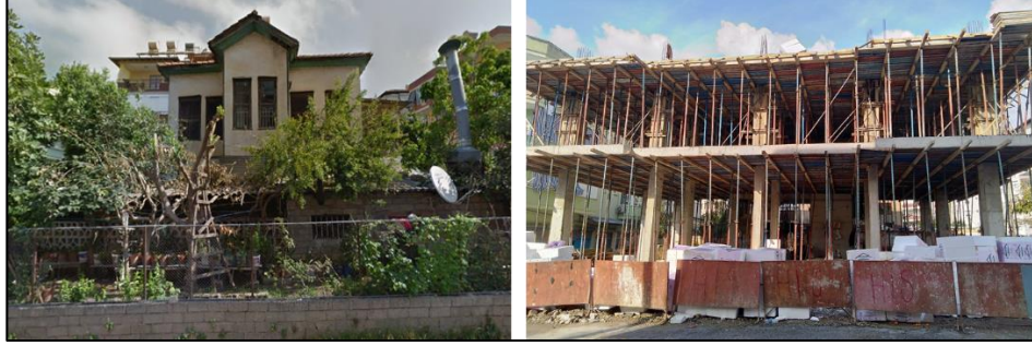
Şekil 1.4 : Soldaki tarihi yapı 2019 Aralık ayında yıkılarak yerine çok katlı modern bir betonarme bina yapılmıştır.
