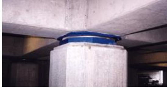
Şekil 4.5 Sürtünmeli Sönümleyici- Friction Pendulum Bearings
