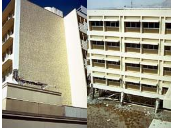
Şekil 3.22 Zayıf Kat Düzensizliği Sonucu Yapıda Meydana Gelen Hasarlar[43, 44]
