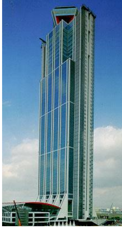
Şekil 4.21 World Trade Center Binası, Japonya
