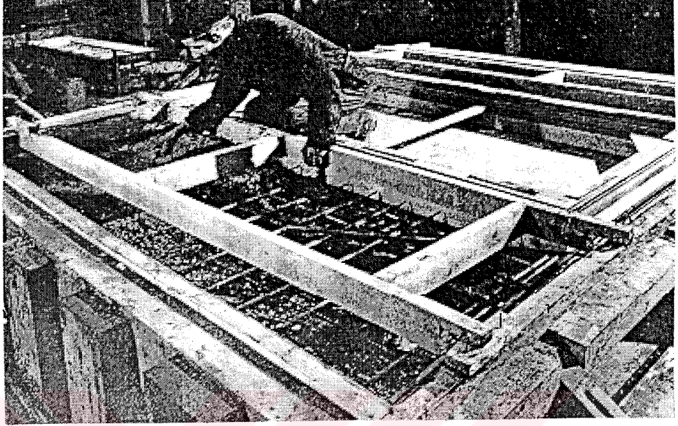
Şekil 3.26 Şekilde plywood kalıbı içine donatı yerleştirilme işlemi görülmektedir.
