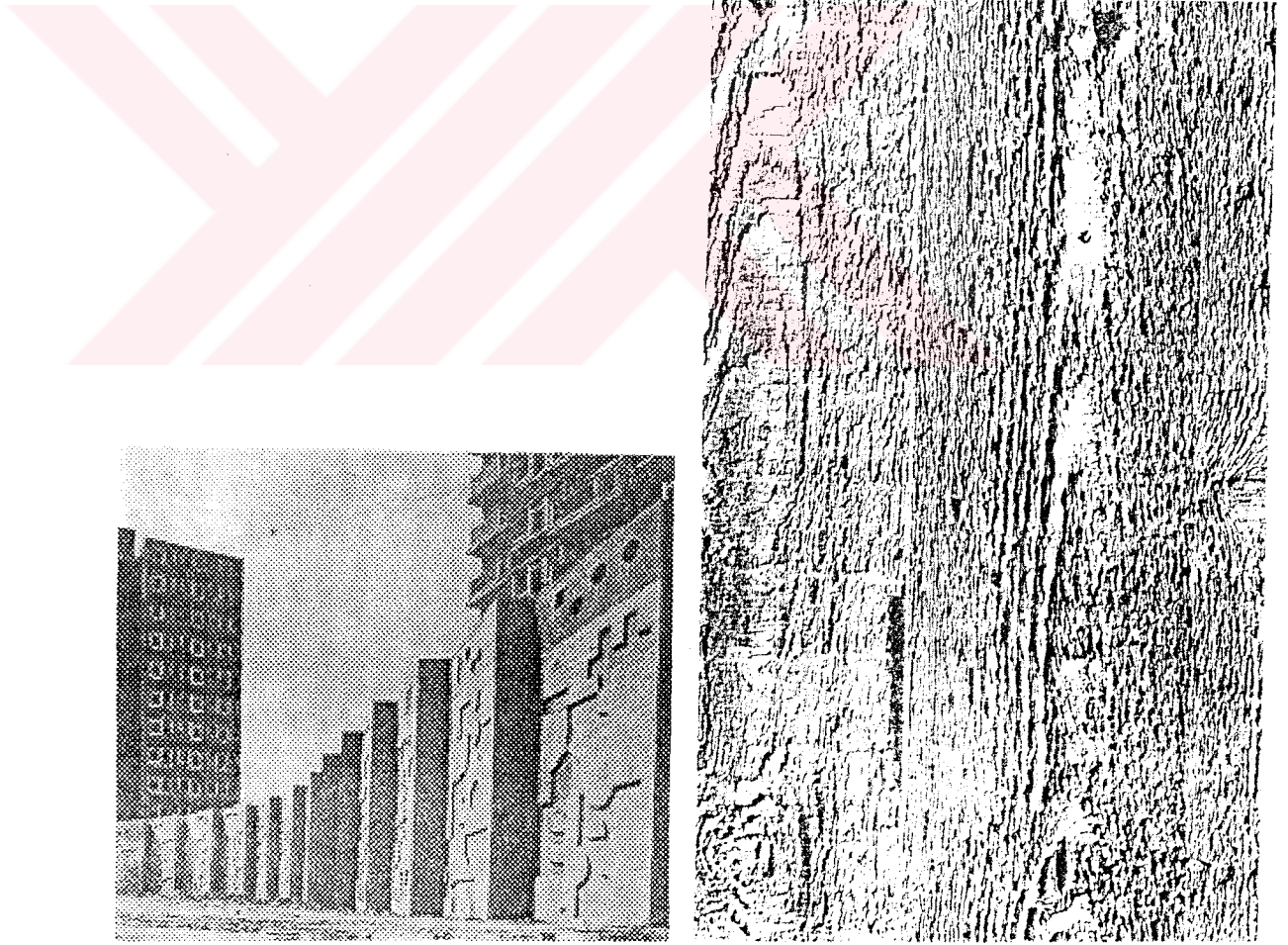
Şekil 5.6 Solda Termoplastik kalıpla elde edilen baskı yüzey. Sağda ise yapay ahşaptan elde edilen baskı yüzey görülmektedir.
