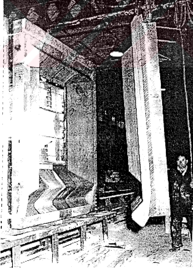
Şekil 3.16 Şekilde cephe paneli üretiminde vinç kullanımı görülmektedir.
