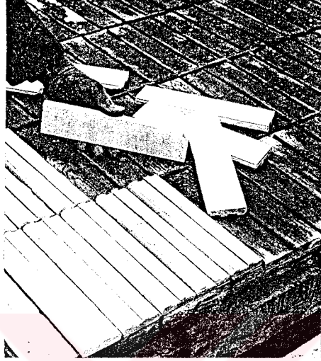
Şekil 5.22 Anahtar taşların yivlere yerleştirilmesi.
