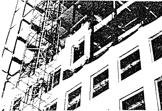
Şekil 5.9 Şekilde cephe panelinin kalıcı kalıp olarak da kullanılabilmesi görülmektedir.
