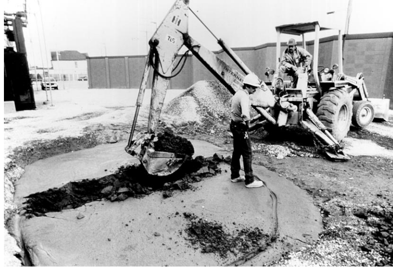
Şekil 2.1 : KDDM'nin kepçe ile kazılması (ACI 229R).
