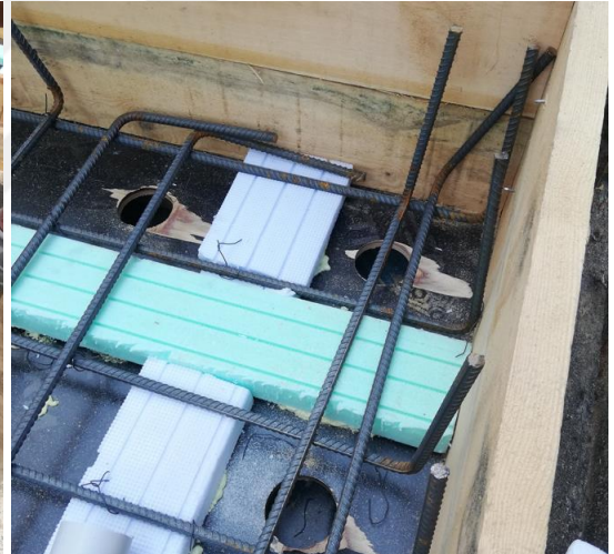
Şekil 3.24 : Temel donatıların üretim ve yerleşimi.
