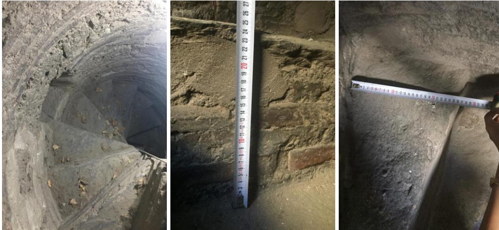
Şekil 2.7 : Hocaalizade Cami minaresi merdiven görünüşü.
