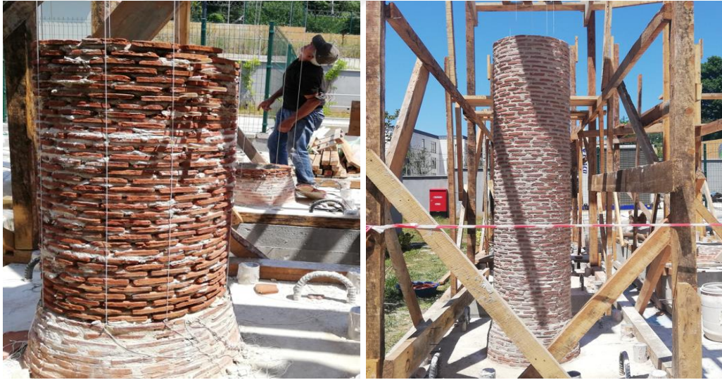
Şekil 3.28 : Minare gövde bölümünün üretimi.
