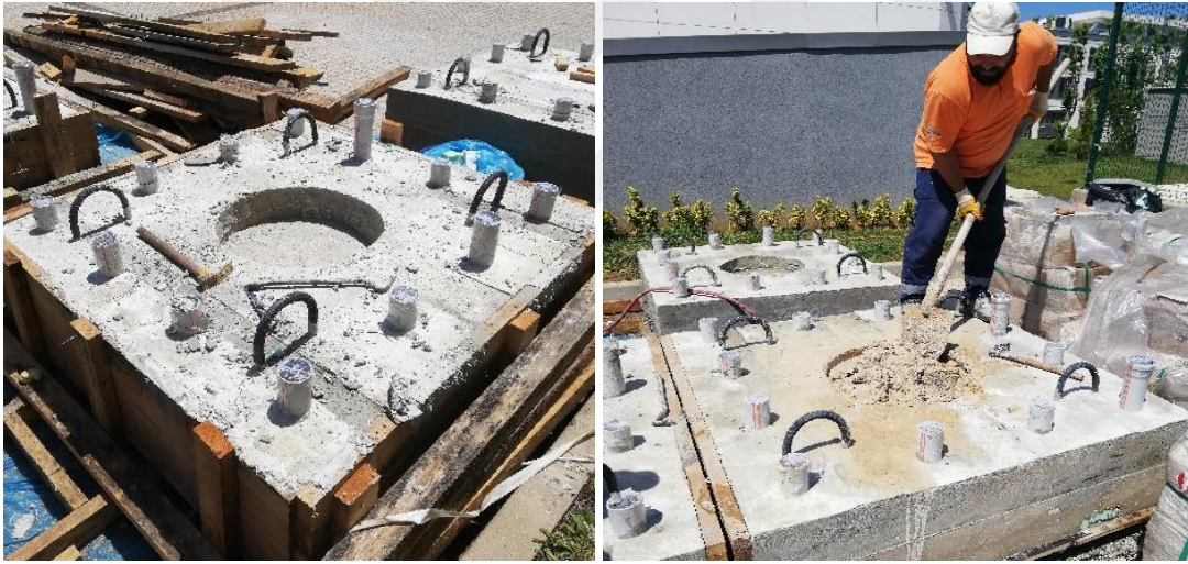
Şekil 3.26 : Minare üretimi için temelde bırakılan yuva.
