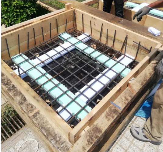
Şekil 3.24 : Temel donatıların üretim ve yerleşimi.
