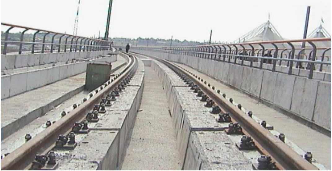
Şekil 3.1: Yenibosna-Havaalanı arası balastsız üstyapı.
