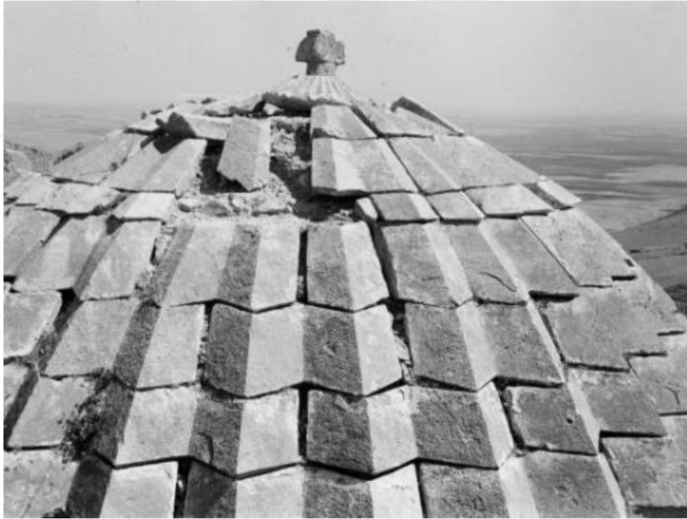
Şekil 4.17 : 1967 Onarımı öncesi Kasımiye Medresesi dilimli kubbelerinde biri (BVGMA).
