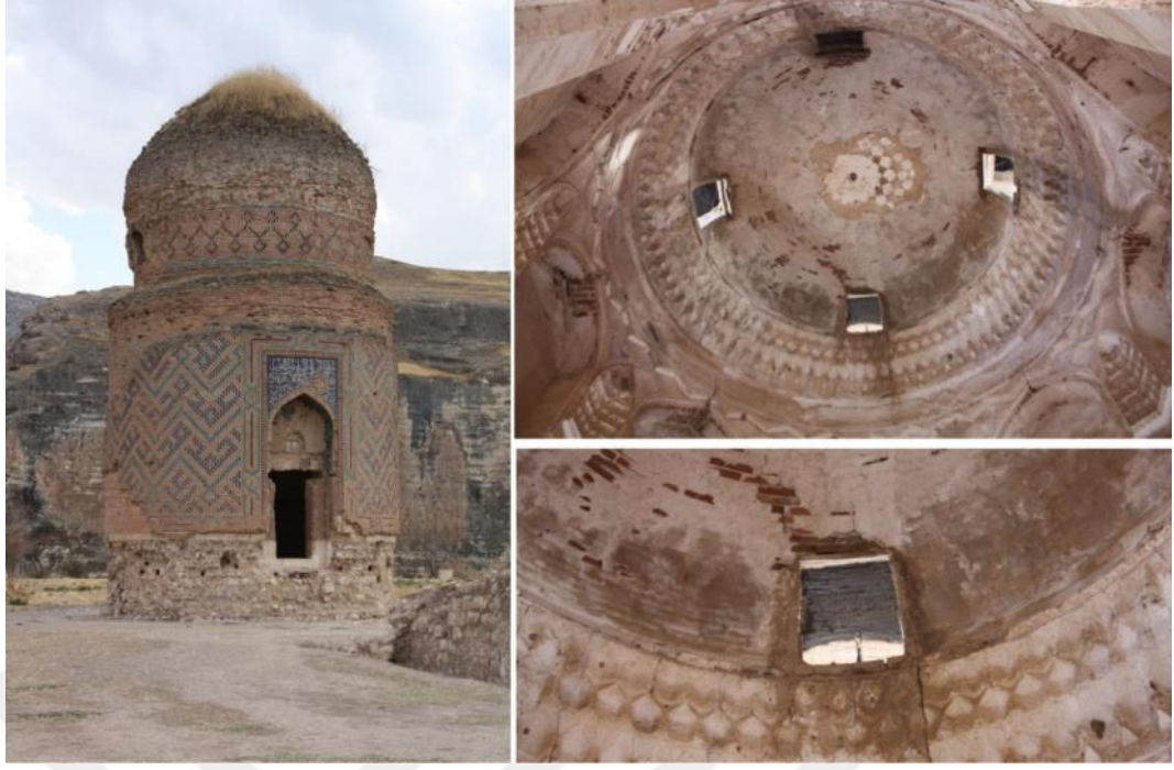
Şekil 4.15 : Hasankeyf Zeynel Bey Türbesi ve iç mekândan çift cidarlı kubbenin görünümleri (MÇA).
