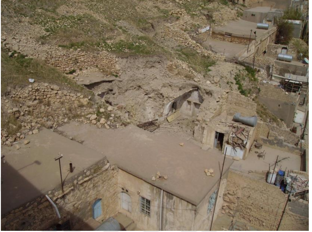
Şekil 2.110 : 2007’de Zincirliye Medresesi’nin komşu parselindeki eve düşen kaya sonrası evin medrese damından görünümü (MÇA).
