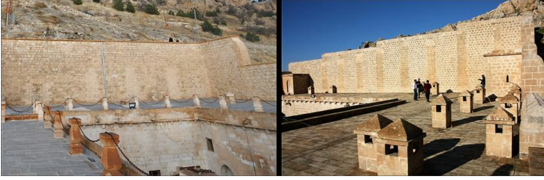
Şekil 3.10 : Solda Zinciriye'nin, sağda ise Kasımiye Medresesi'nin düzgün kesme taştan dik hatıllı kaba yonu dolgulu istinat duvarları (MÇA).
