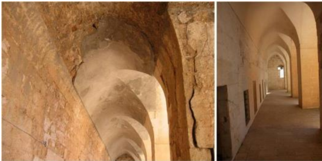
Şekil 2.139 : 2007 onarımı öncesi ve sonrası Kasımiye Medresesi üst kat doğu revağından bir görünüm (MÇA).
