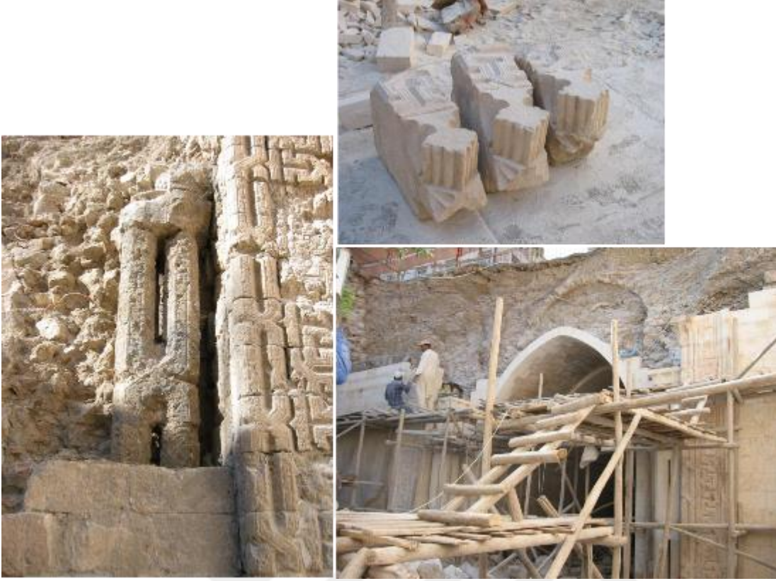
Şekil 2.53 : Şehidiye Medresesi 2004 onarımı sırasında duvar içinde bulunan özgün eyvana ait parçalar ve eyvan yeniden inşa edilirken (MAİA).
