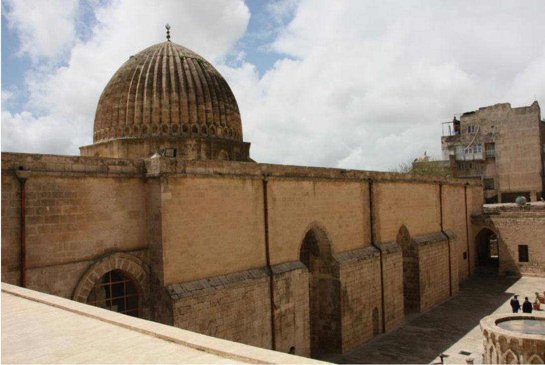
Şekil 2.30 : Mardin Ulu Cami avlusundan bir görünüm -solda sonradan eklenen destek duvarı görülmekte- (MÇA).
