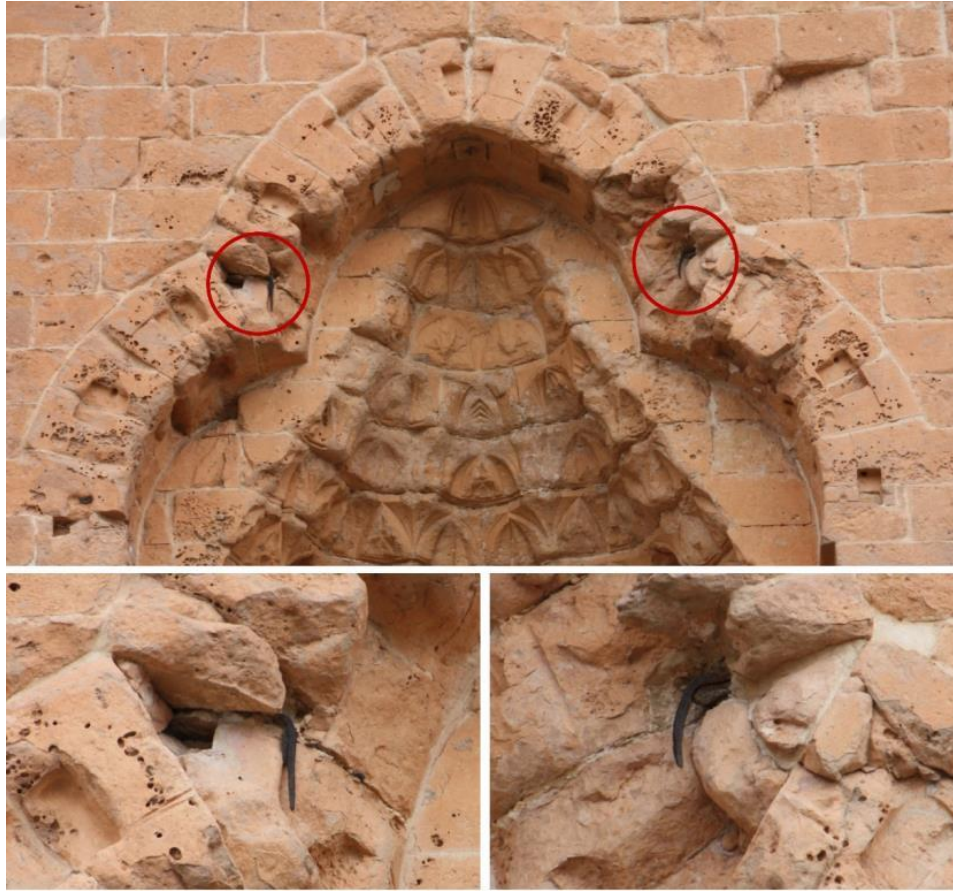
Şekil 3.16 : Kasımiye Medresesi portal mukarnasında görünen kenetler.
