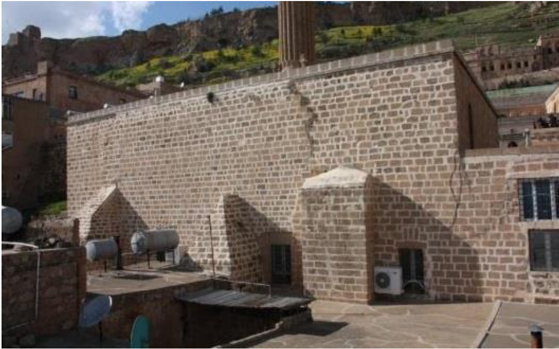
Şekil 3.23 : Şehidiye Medresesi Camisi güney cephesi (MÇA)
