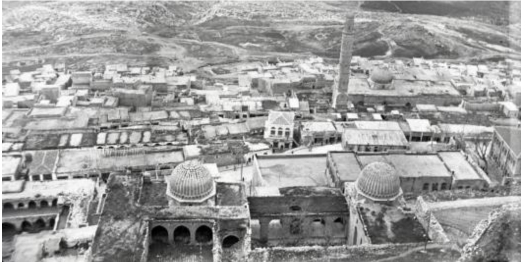
Şekil 2.93 : 1963 yılı onarım öncesi Zinciriye Medresesi'nin kaleden görünümü; güney revak tonozundaki delik ve üst kattaki mekânın çökmüş tonozu açıkça görünmektedir (BVGMA).
