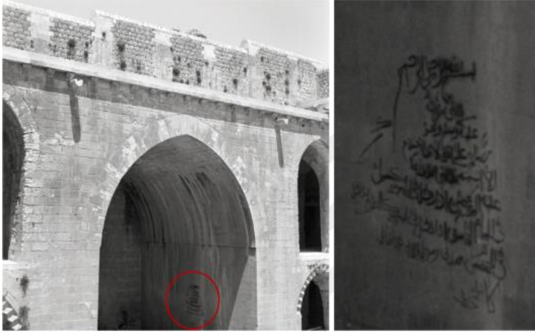
Şekil 2.120 : 1960 onarımlarında önce Kasımiye Medresesi eyvanının batıya bakan duvarı üzerinde bulunan, bugün var olmayan hat (BVGMA).
