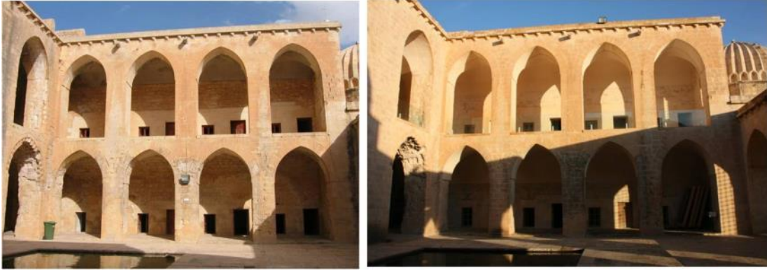
Şekil 2.137 : 2007 onarımı öncesi ve sonrasında Kasımiye Medresesi avlu doğu revakları cephesi (MÇA).
