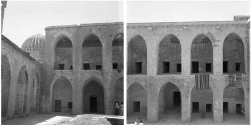
Şekil 2.130 : 1967 onarımı öncesi ve sonrası Kasımiye Medresesi'nin doğuya bakan avlu revaklarından bir görünüm (BVGMA)
