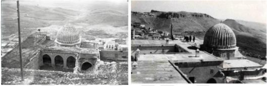
Şekil 2.94 : Zinciriye Medresesi'nin 1963-66 onarımları önceki ve sonraki durumu (BVGMA)
