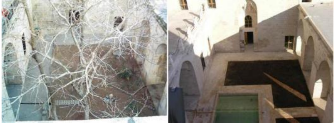
Şekil 2.105 : Zinciriye Medresesi'nin 2006 onarımı öncesi ve sonrası iç avlu (MÇA).
