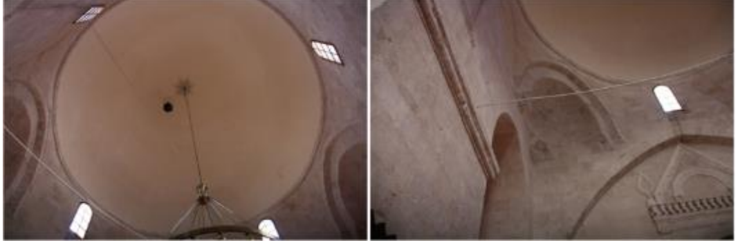
Şekil 3.57 : Ulu Cami kubbesi ve tromplu geçişi.
