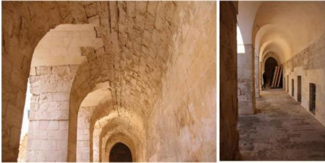
Şekil 2.138 : 2007 onarımı öncesi ve sonrası Kasımiye Medresesi zemin kat doğu revağından bir görünüm (MÇA).
