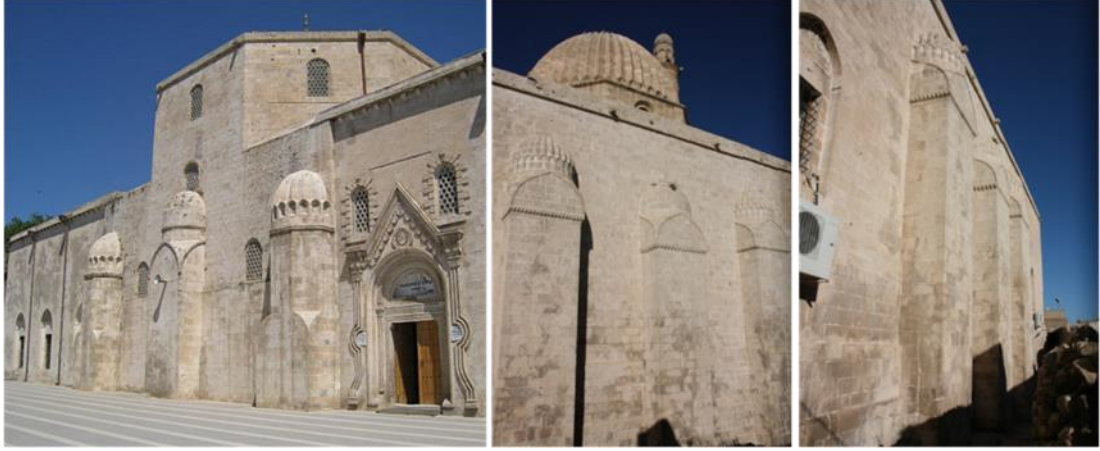
Şekil 2.5 : Diyarbakır Silvan Ulu Cami (solda) ile Mardin Ulu Cami (sağda) kible cephesi payandaları (MÇA, 2015).
