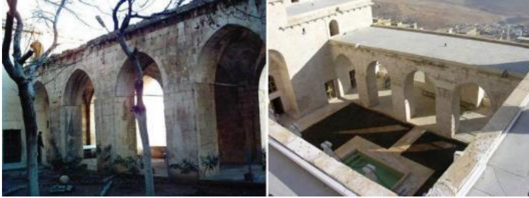
Şekil 2.102 : Zinciriye Medresesi'nin 2006 onarımı öncesi ve sonrası avlu revakları (MÇA).
