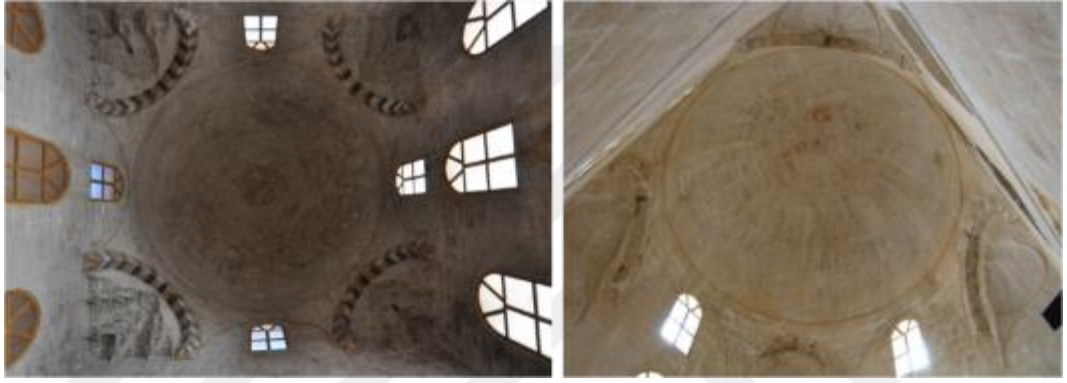
Şekil 3.58 : Zinciriye Medresesi; solda Hanefi Mescidi mukarnaslı kubbesi, sağda Şafii Mescidi tromplu kubbesi.
