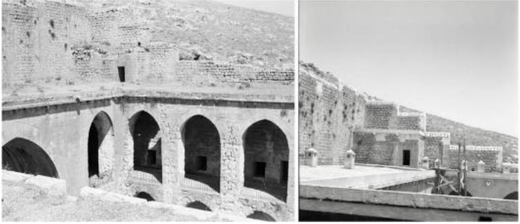
Şekil 2.128 : 1967 onarımı öncesi ve sonrası Kasımiye Medresesi damından bir görünüm (BVGMA).
