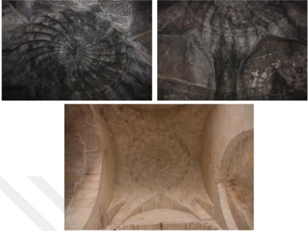
Şekil 2.118 : Üstte Fahriye Kasrı çarkifelek tonozu, altta Kasımiye Medresesi tonozu (MÇA).
