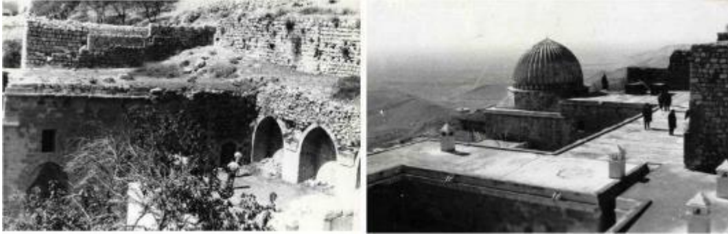
Şekil 2.96 : Zinciriye Medresesi'nin 1963-66 onarımları önceki ve sonraki durumu (BVGMA).
