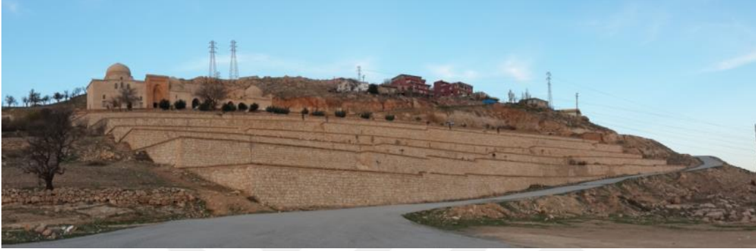
Şekil 2.142 : Çevre düzenlemesi çalışmalarından sonra Kasımiye Medresesi’nin güney cephesi peyzajı (MÇA).
