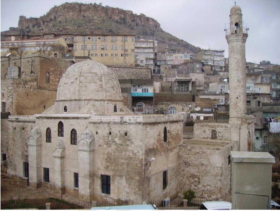
Şekil 2.4 : Mardin Melik Mahmut (Savurkapı) Camisi'nin üçlü payanda düzenli kible cephesi (MÇA, 2015).
