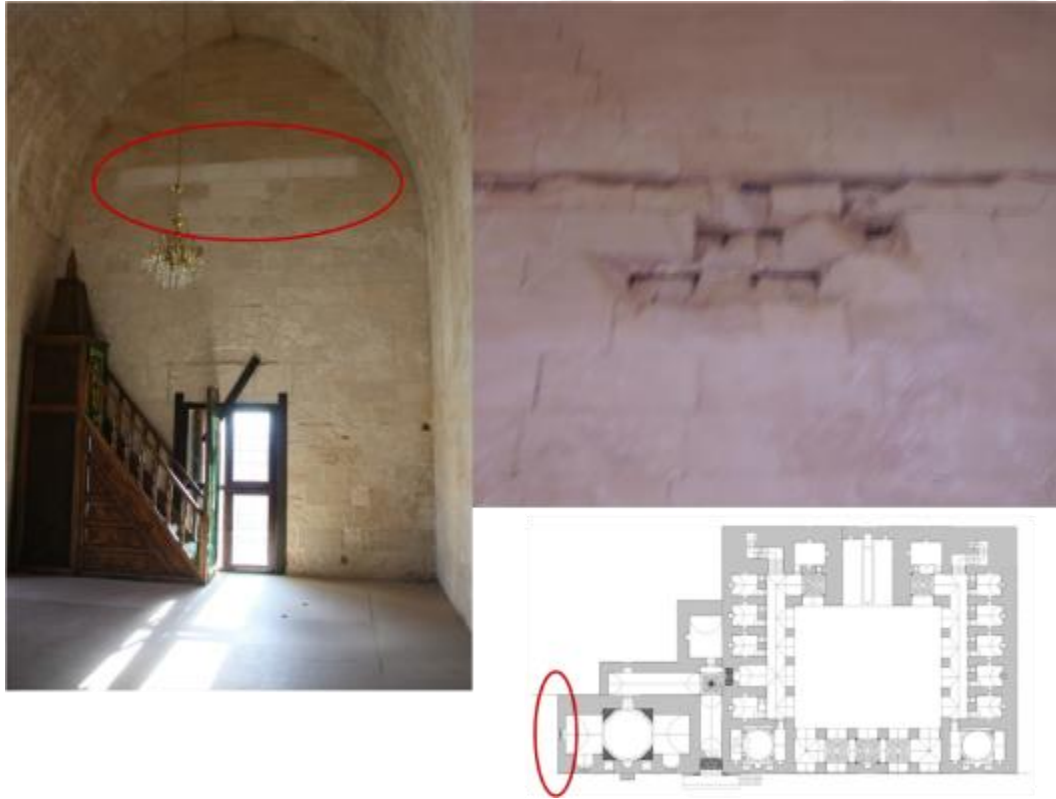
Şekil 3.14 : Kasımiye Medresesi Hanefi Mescidi Batı duvarındaki onarım öncesi ve sonrası kenetlerin yeri (MÇA).
