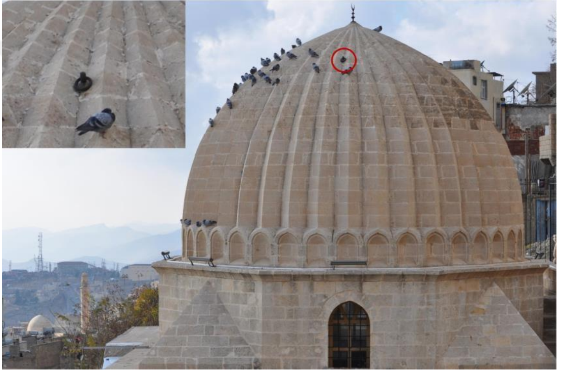
Şekil 2.67 : Zinciriye Medresesi kubbeleri üzerindeki demir halkalardan biri (MÇA).
