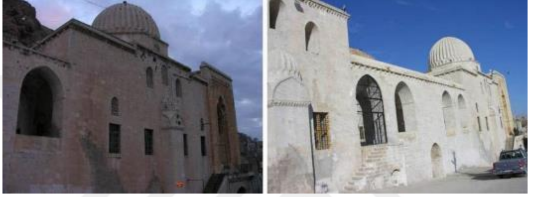
Şekil 2.98 : Zinciriye Medresesi'nin 2006 onarımı öncesi ve sonrası güney cephesi (BVGMA ve MÇA).
