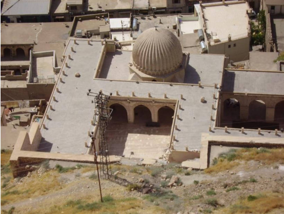
Şekil 2.109 : 2007 yılının Nisan ayında kaya düşmesi sonucu yıkılan Zinciriye Medresesi duvarı (MÇA).
