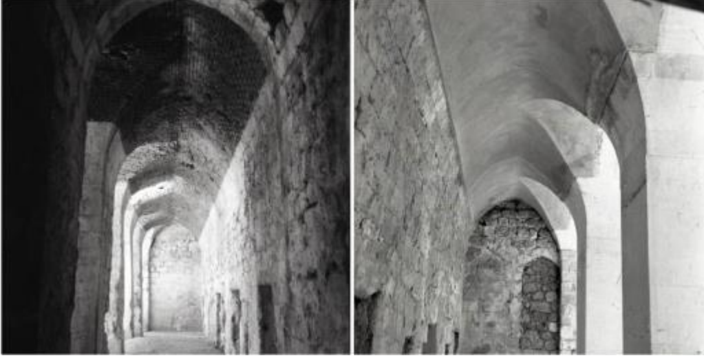
Şekil 2.131 : 1967 onarımı öncesi ve sonrası Kasımiye Medresesi revak tonozlarından bir görünüm (BVGMA).
