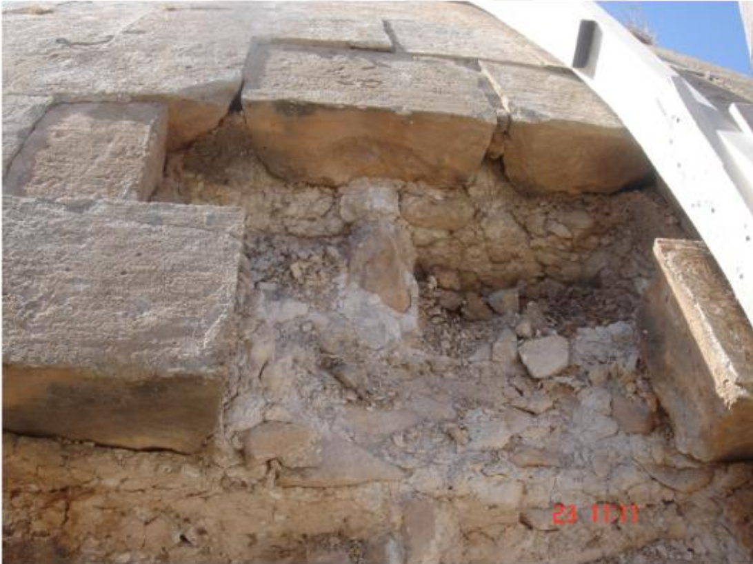
Şekil 4.18 : Kasımiye Medresesi 2007 onarımı sırasında dilimli ve perdahlı kubbenin taşları çürütülürken (Mehmet Alper Arşivi).
