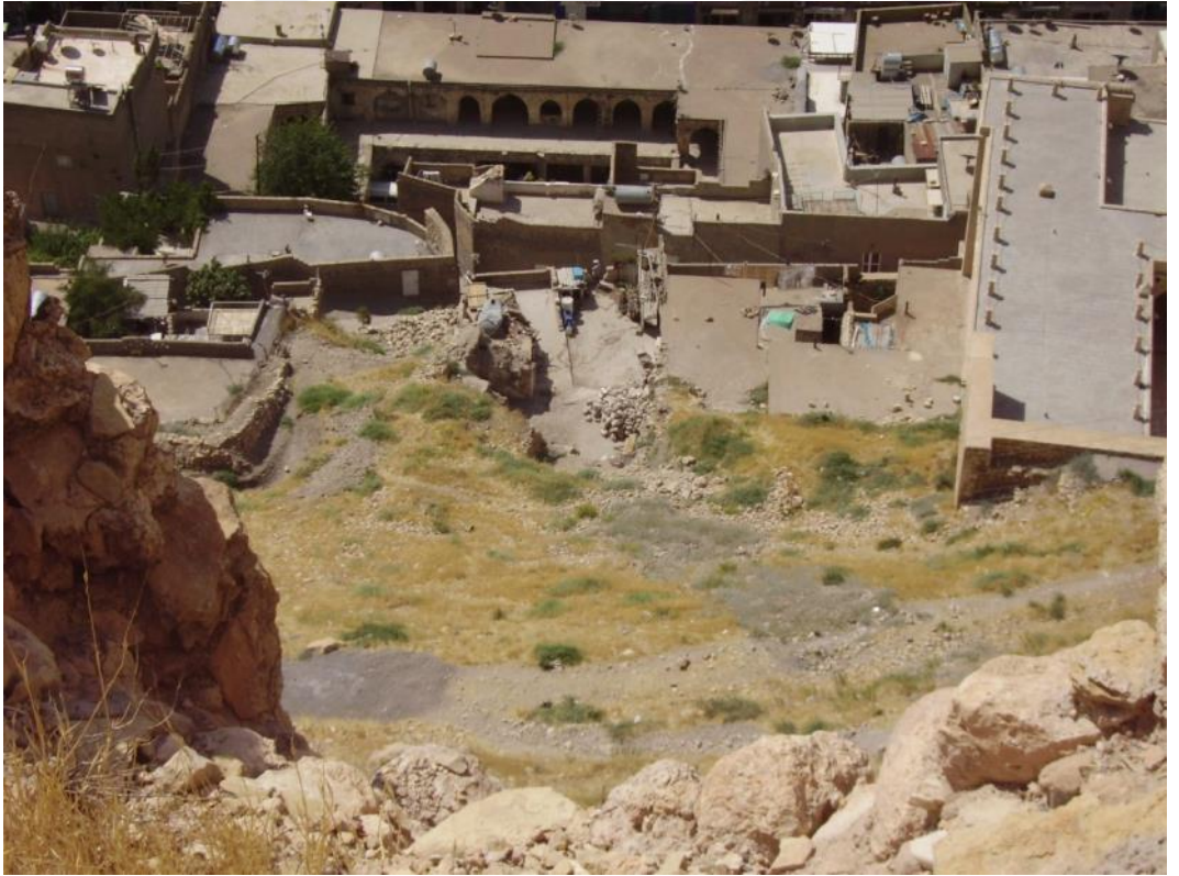
Şekil 2.111 : 2007 yılının Nisan ayında Zincirliye Medresesi’nin komşu parselindeki eve düşen kaya sonrası evin kaleden görünümü (MÇA).
