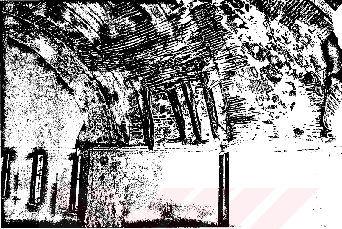
F . 69 . Apsis mekanının çökmeye başlayan örtüsü
