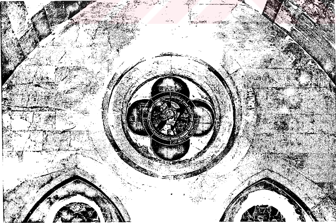
F . 100 . Kırım Kilisesi pencere detayı
