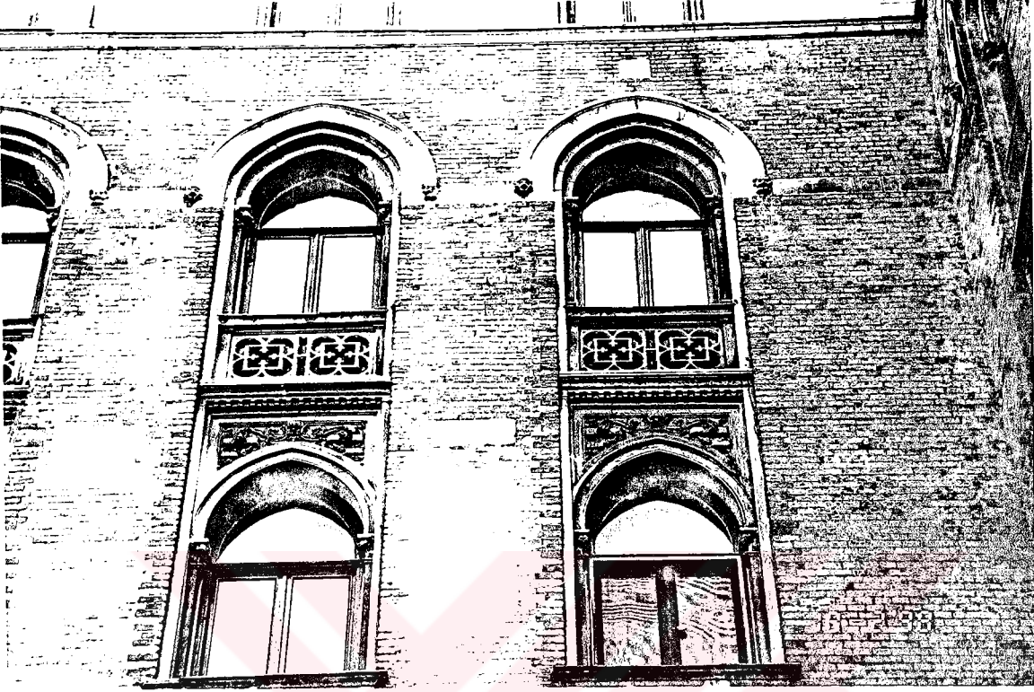
F . 97 . St. Antoine Kilisesi Apartmanları'ndan cephe detayı
