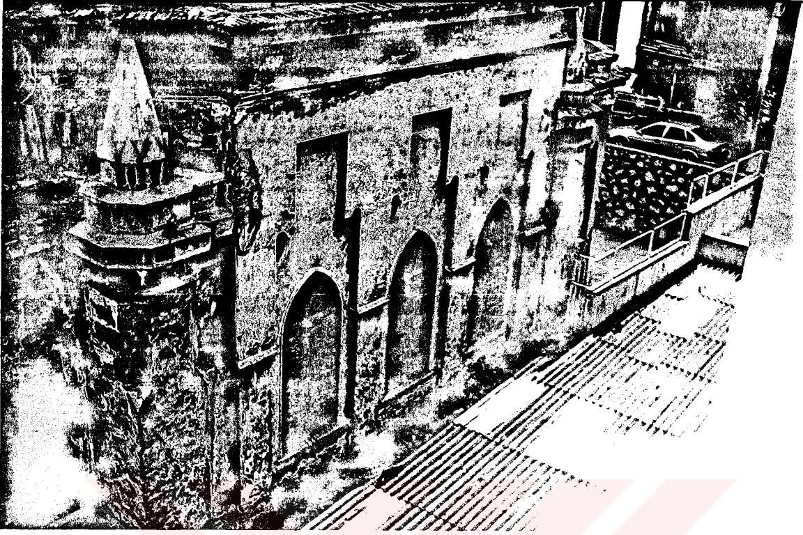
F . 47 . Ana kilise mekanının kuzeybatı yönünde bahçe duvarıyla ilişkisi
