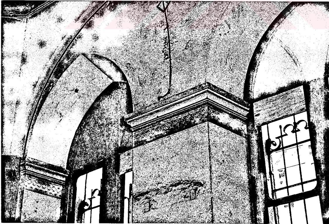
F . 17 . Ana kilise mekanını dolaşan silme detayı
