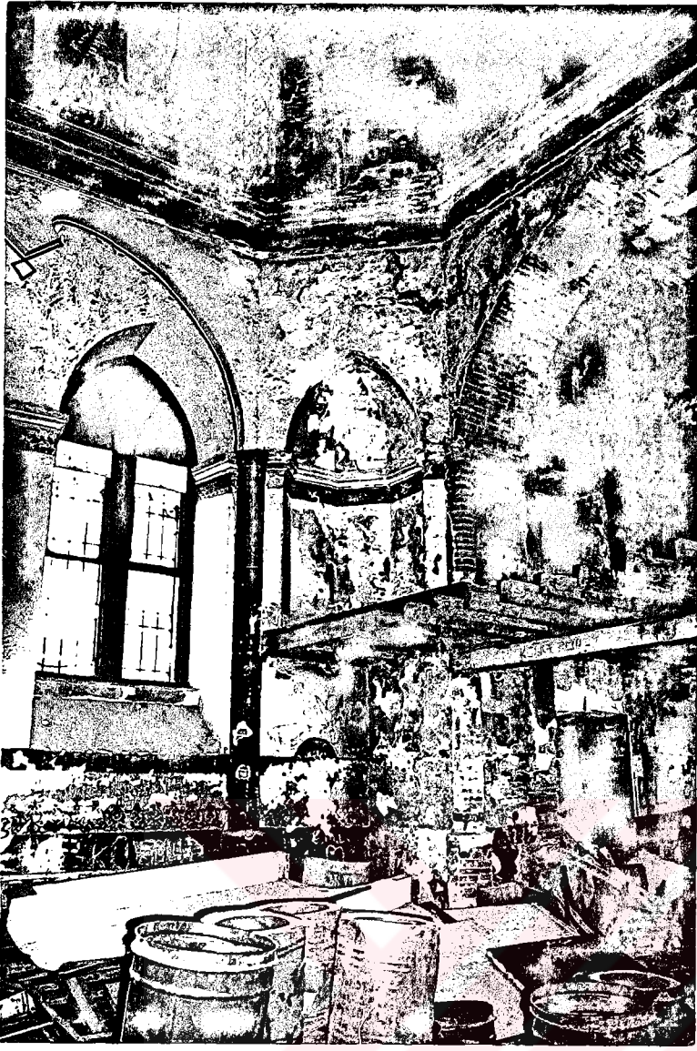
F . 65 . İç mekan duvarlarında görülen bozulmalar
