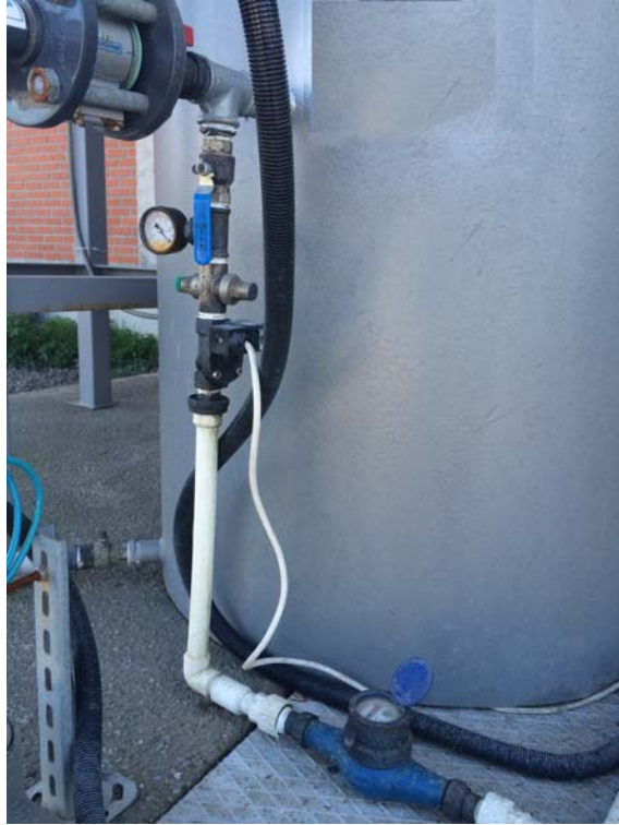
Şekil 3.16 : Seramik membran geri yıkama hattı görünümü.
