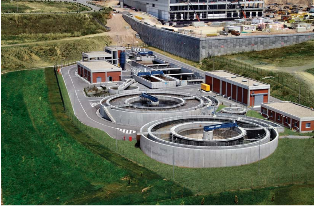
Şekil 3.1 : GOSB atıksu arıtma tesisi görünümü.
