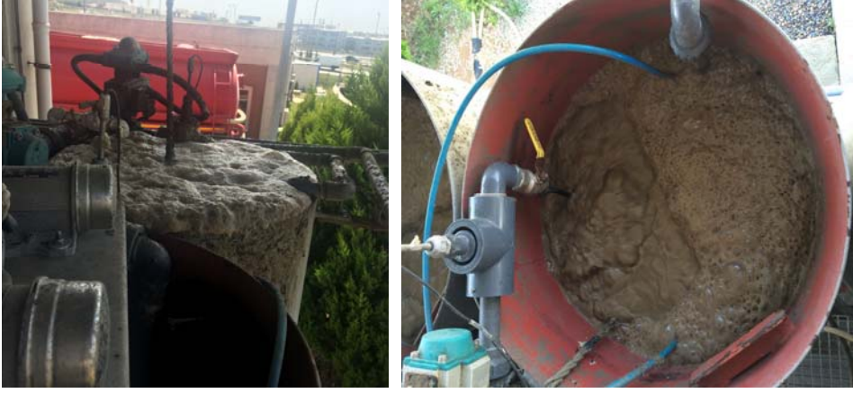
Şekil 3.4 : Pilot tesiste PAC kullanımı öncesi olumsuz köpürme koşulları ve PAC kullanımı sonucu.
