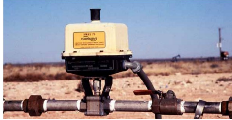
Şekil 3.6 : Pnömatik aktuatörlü küresel vana [20]
