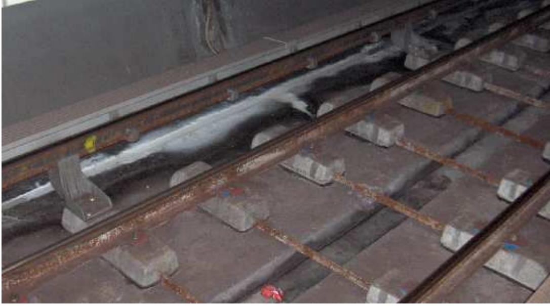
Şekil 2.20: İstanbul metrosunda korumalı üstten temaslı uygulamalı 3. ray sistemi.
