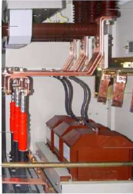
Şekil 2.5: Kablo bağlantısı bölümü.
