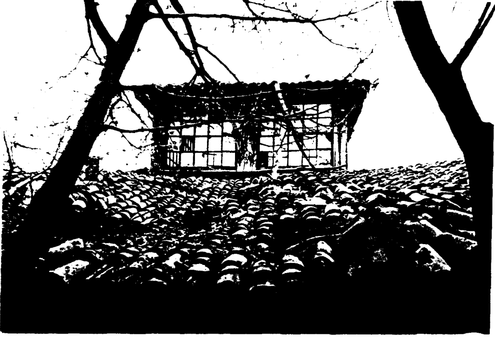
Foto 1. Vakıf Hamamı - Taş duvarlı soyunmalık mekanının alaturka (04/1995) kiremit kaplı, ortası fenerli ahşap çatısı
