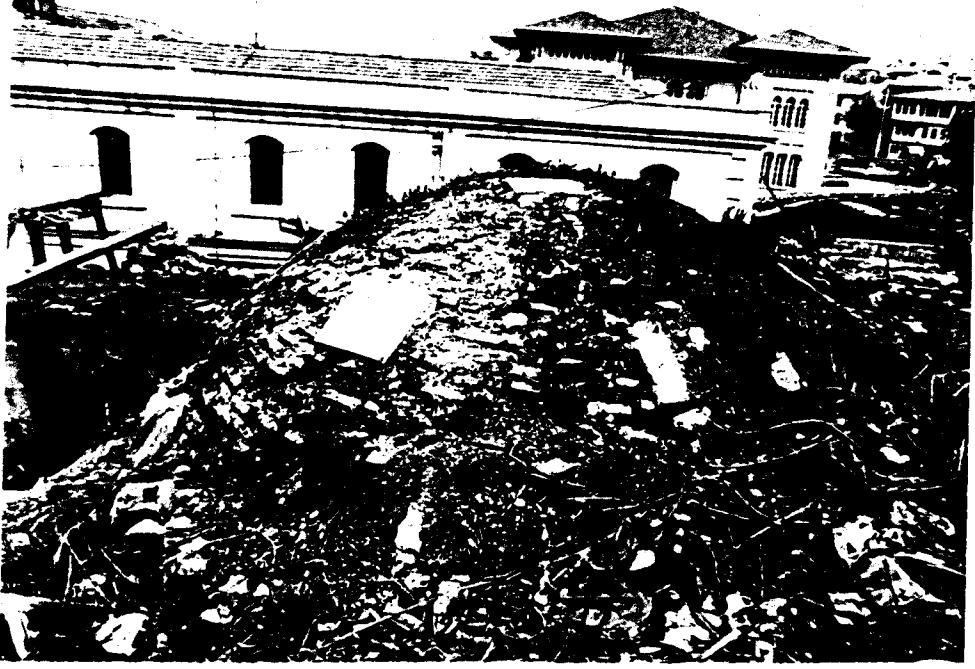
Foto 167. HZ05 nolu mekanın kubbesi
