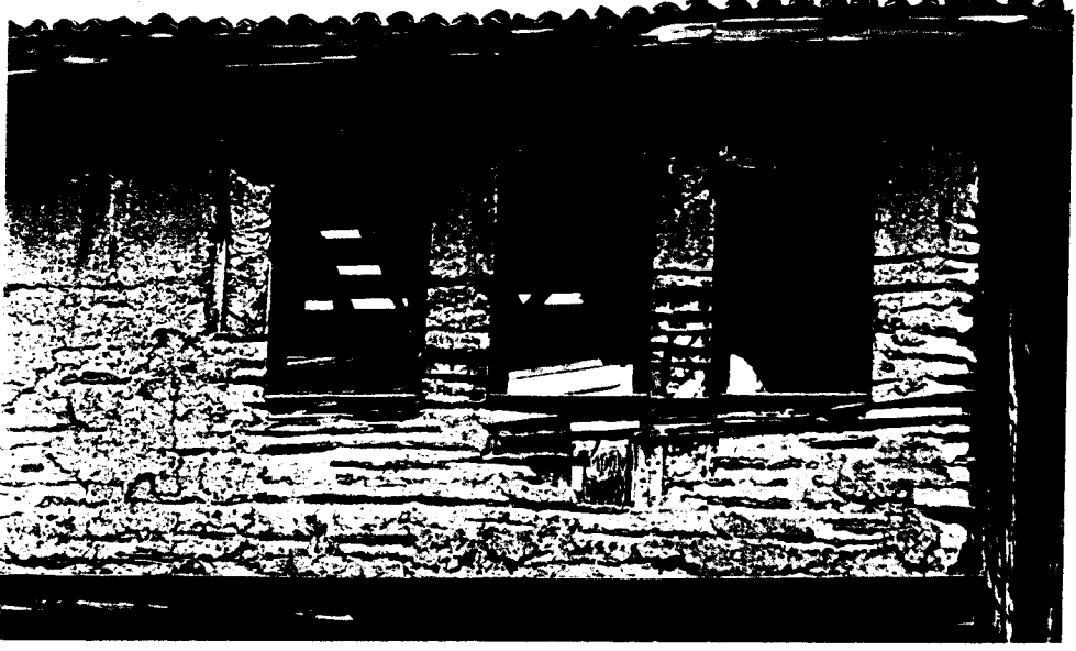
Foto 176. Kuzeybatı cephesi - P11, P12 ve P13 nolu pencereler
