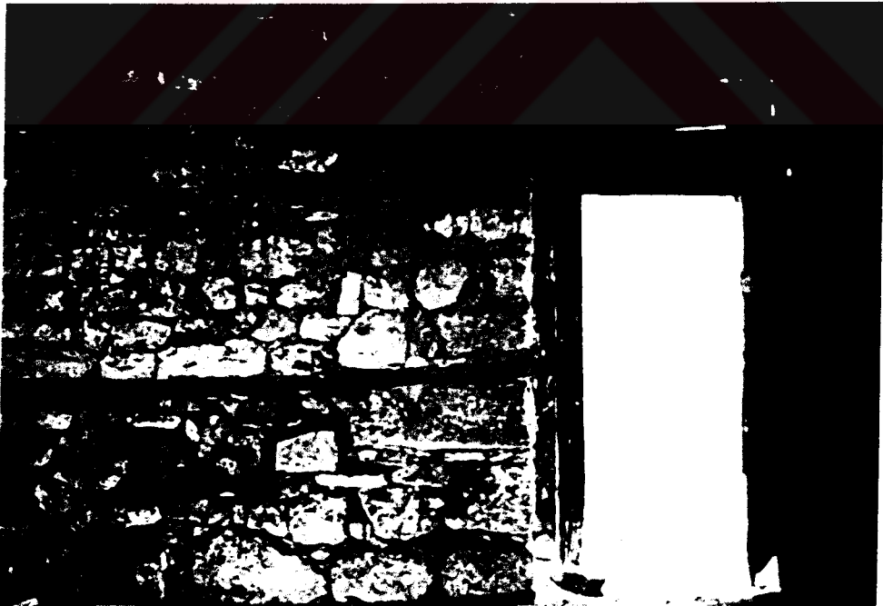
Foto 45. Z01 nolu mekan kuzeydoğu duvarı - K4 nolu kapı (04 1996)
