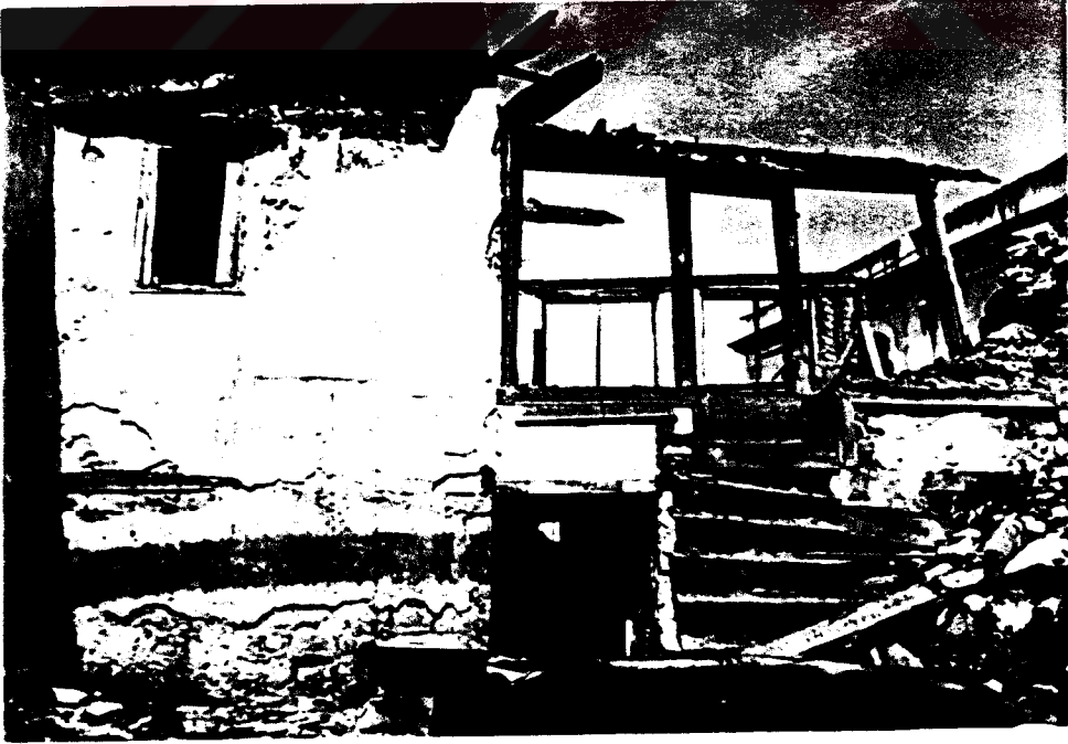
Foto 105. HZ01 nolu mekan kuzeybatı duvarı
