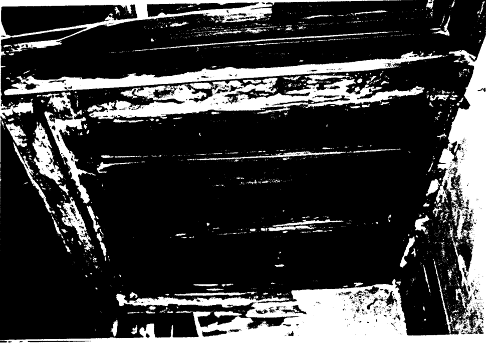
Foto 91. 105 nolu mekanın yıkılan abdesthane bölümüne ait tavan izi (04/1996)
