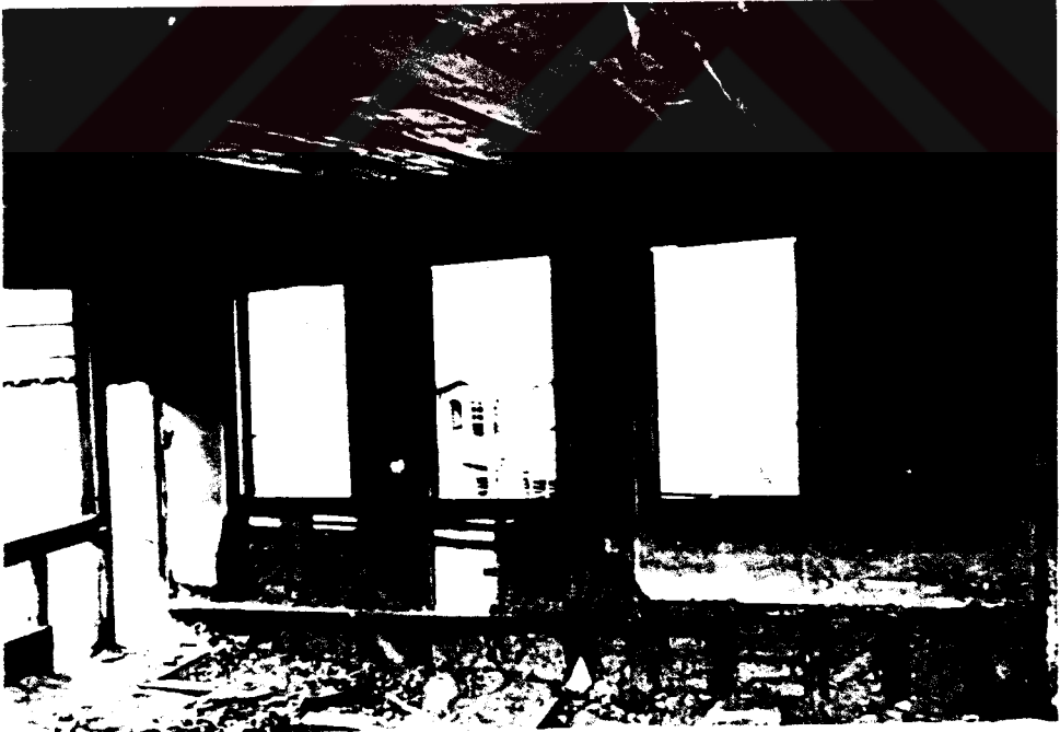
Foto 69. 101 nolu mekan kuzeybatı duvarı - P11, P12 ve P13 nolu pencereler (04/1995)
