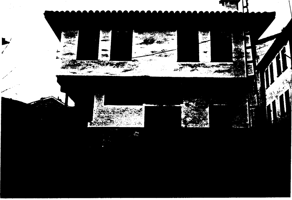
Foto 17. İsmail Bey hamamı - Hamamın üzerinde yer alan ahşap yapı (04/1996)
