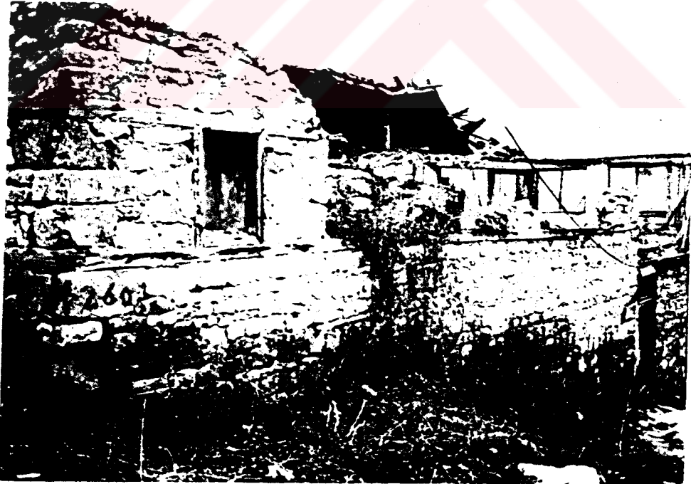
Foto 39. Kuzeydoğu cephesi - Soyunmalık duvarı
