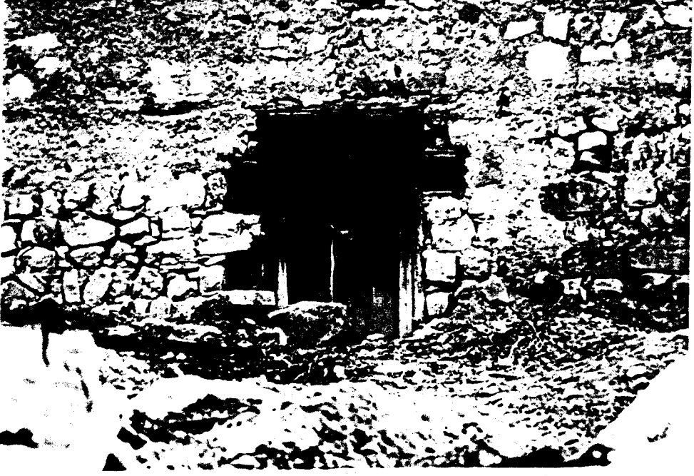
Foto 170. Kuzeybatı cephesi - P 1 ve P 2 nolu pencereler - K 1 nolu kapı (04/1995)
