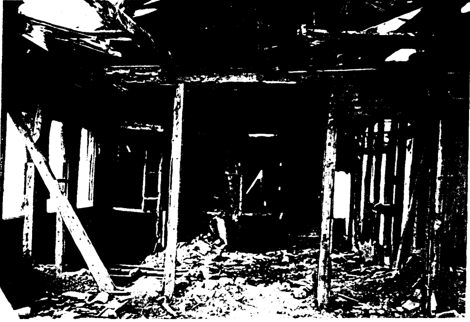
Foto 75. 102 nolu mekan kuzeydoğu duvarı
