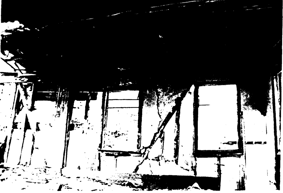
Foto 157. 101 nolu mekan güneybatı duvarının ahşap iskeleti (04/1995)
