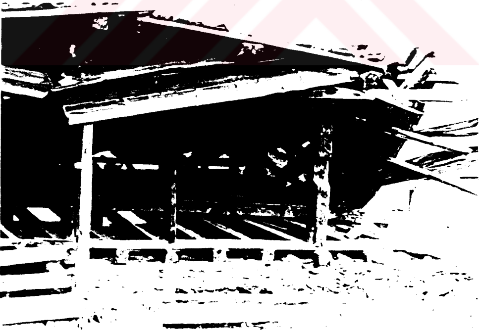
Foto 162. Çatı - Güneydoğusunda kalkan duvarın bitimi ve çatı arası
