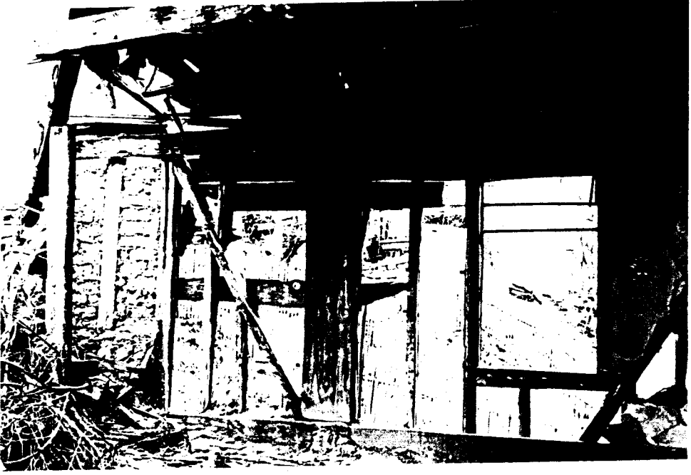
Foto 68. 101 nolu mekan güneybatı duvarı - P9 ve P10 nolu pencereler (04/1996)
