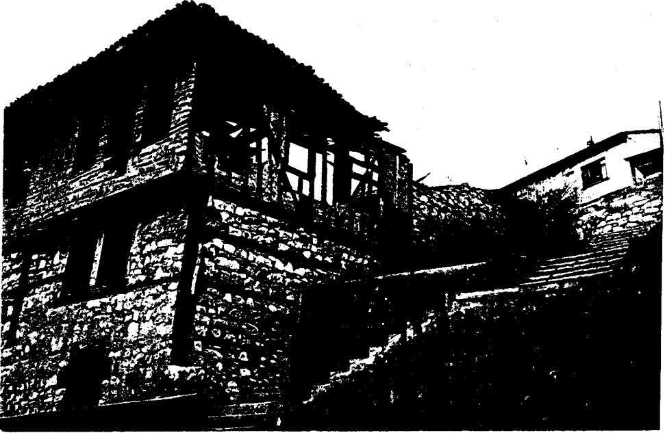
Foto 38. Ahşap karkas konut bölümü ve hamamı çevreleyen kabayonu moloztaş duvar (güneybatı cephesi)
