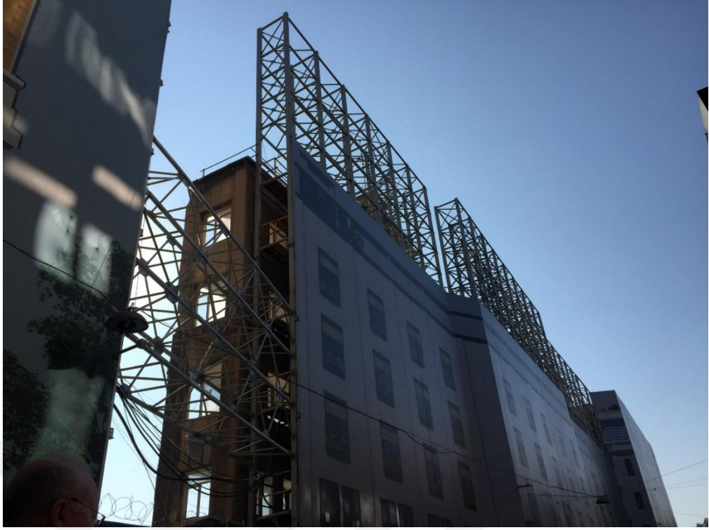
Şekil 3.18 : Paket Postanesi’nin iç yıkım sonrası cephesinin bırakılması, 2018.
