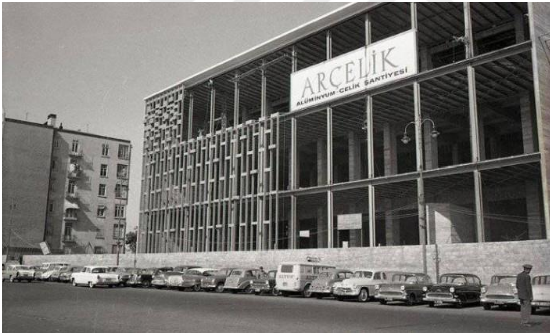
Şekil 3.16 : AKM cephe inşaatı (Gür, 2018).
