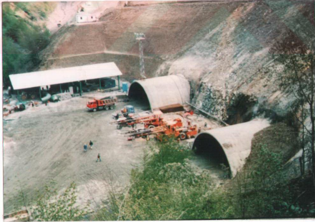
Şekil 4.13 Tünel Şantiyesinden Bir Görüntü
