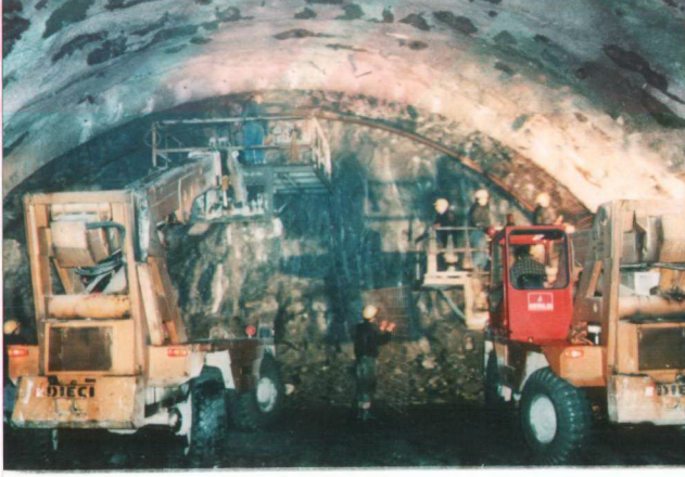
Şekil 4.15 Tünel İksa Yerleştirme Çalışması
