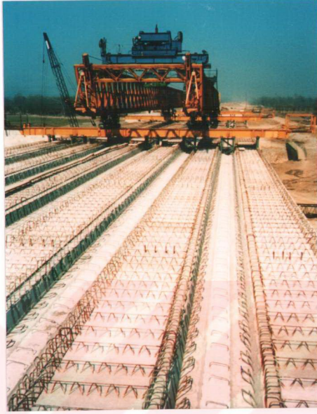
Şekil 4.18 Köprü Yapım Çalışmaları
