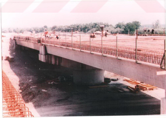
Şekil 4.19 Köprü Yapım Çalışmaları
