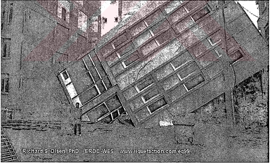
Şekil 2.7. Adapazarı'nda (1999) temelden devrilmiş bir bina.
