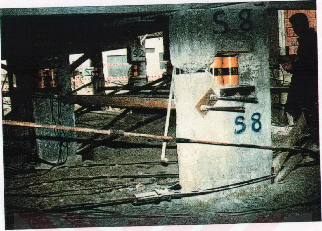
Şekil 6.2 Kriko kullanılarak binaların kaldırılması [38]
