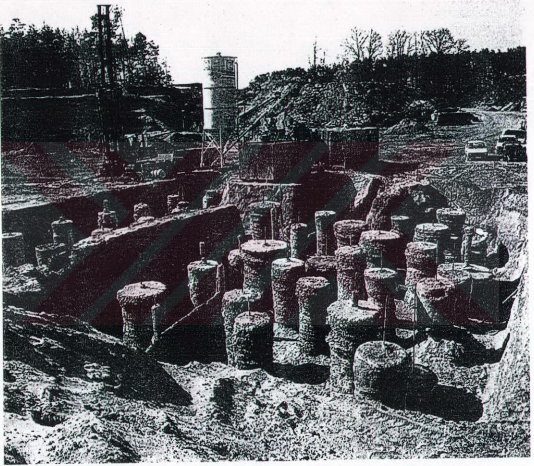
Şekil 4.13 Çeşitli jet grout elemanlar [9]
