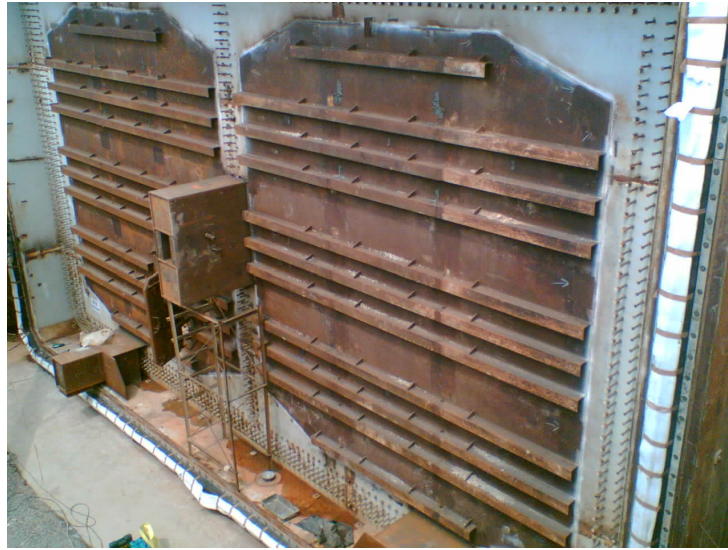
Şekil 4.10: Marmaray Boğaz Tüp Geçiş Projesi batırma tüpün havuzlarda imalatı
