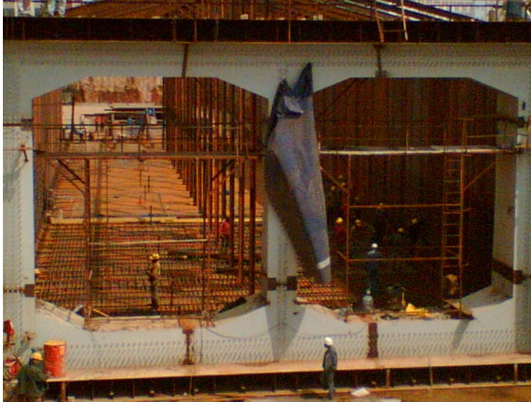
Şekil 4.9: Marmaray Boğaz Tüp Geçiş Projesi batırma tüpün havuzlarda imalatı
