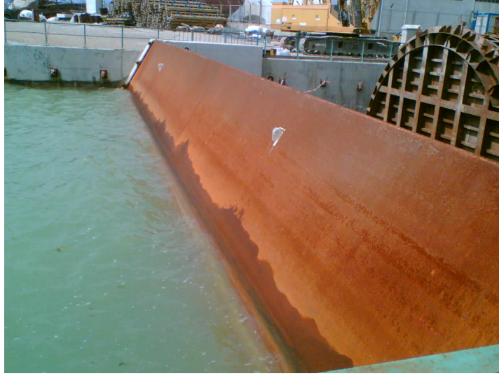
Şekil 4.11: Marmaray Boğaz Tüp Geçiş Projesi batırma tüpün havuz çıkışı
