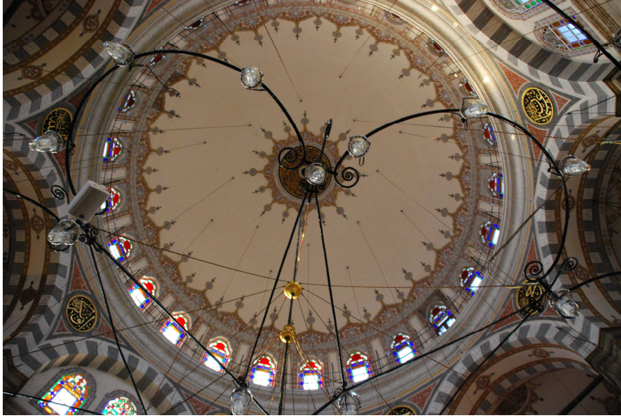
Şekil C.14: Kubbe, kubbe kasnağı ve mevcut kalemişi (Demir, 2009)
