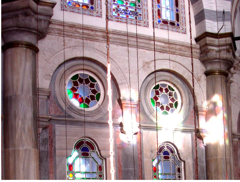
Şekil E.46: Duvar yüzeyinde yarım daire kemerler (Demir, 2009)
