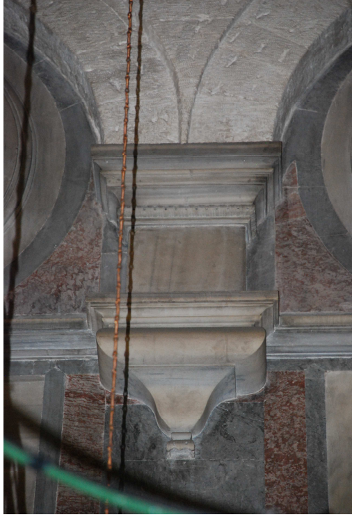
Şekil E.24: İç mekanda duvar yüzeyindeki konsollar (Demir, 2009)
