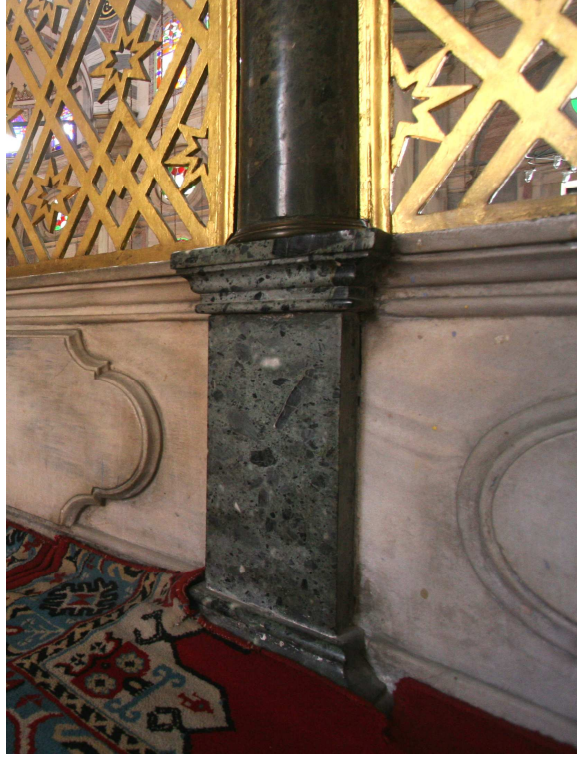
Şekil E.8: Hünkar mahfilinde bulunan ahşap kafesi taşıyan sütunların kaidesi
