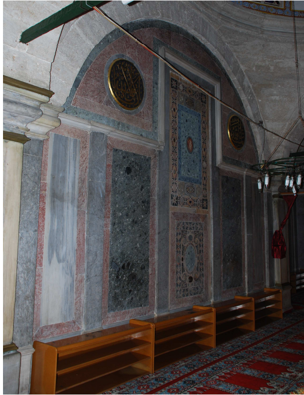
Şekil C.25: Mahfil üst katında duvar yüzeyindeki renkli panolar (Demir, 2009)
