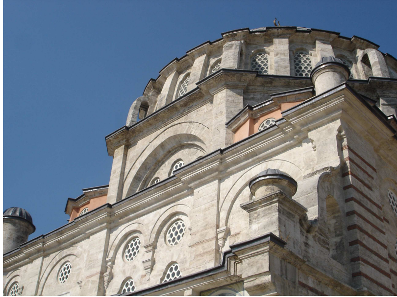
Şekil E.19: Payandalara dönüşen pilasterler (Demir, 2009)
