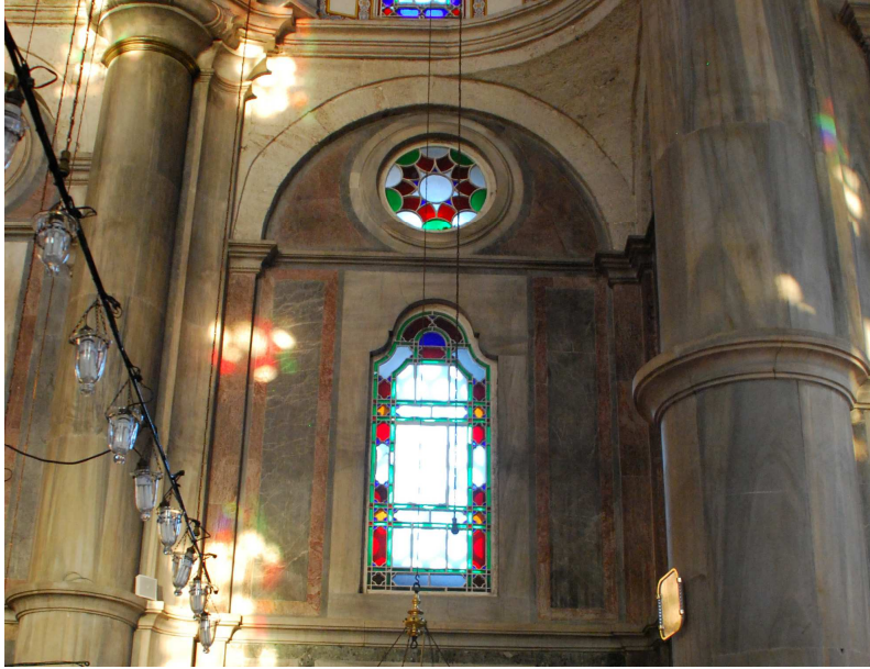
Şekil E.25: Trompların altında bulunan duvar yüzeyindeki pilasterler (Demir, 2009)
