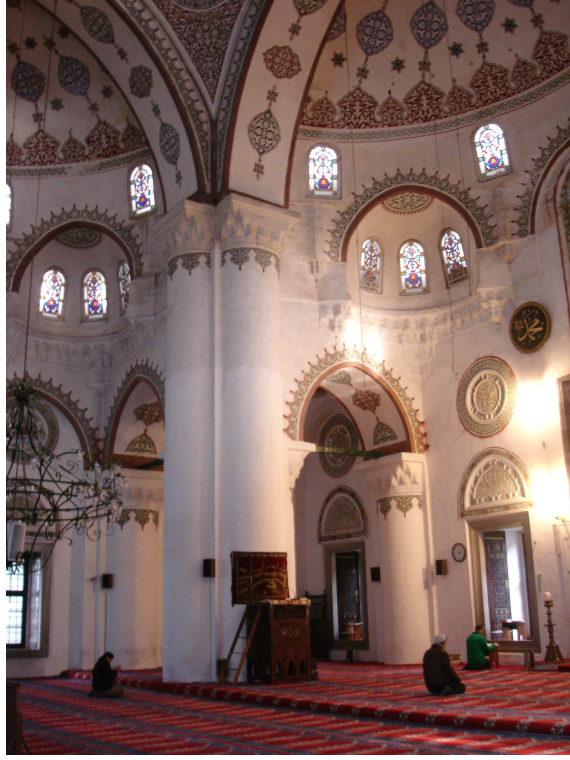
Şekil E.36: Üsküdar Mihrimah Sultan Camisi- yarım sütun şeklinde biçimlenmiş ana taşıyıcı ayak (Demir, 2009)
