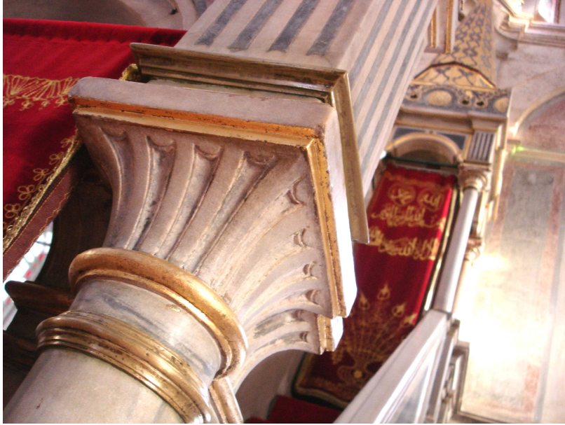
Şekil E.13: Minbere çıkış kemerini taşıyan sütun başlığı (Demir, 2009)
