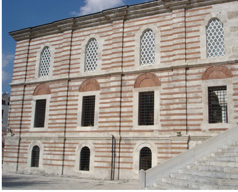
Şekil E.18: Avlu dış cephesi (Demir, 2009)
