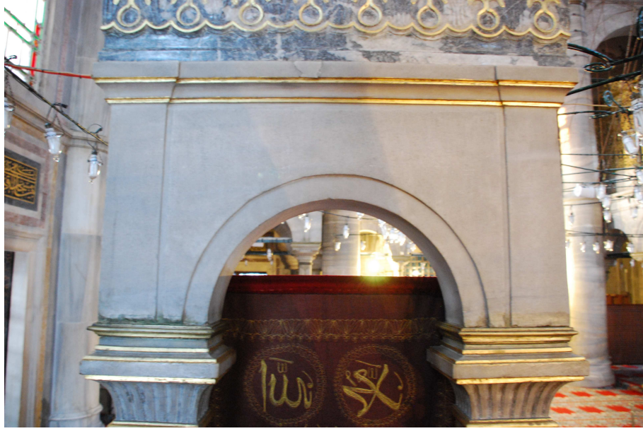
Şekil E.48: Minberden görünüm-yarım daire kemer (Demir, 2009)
