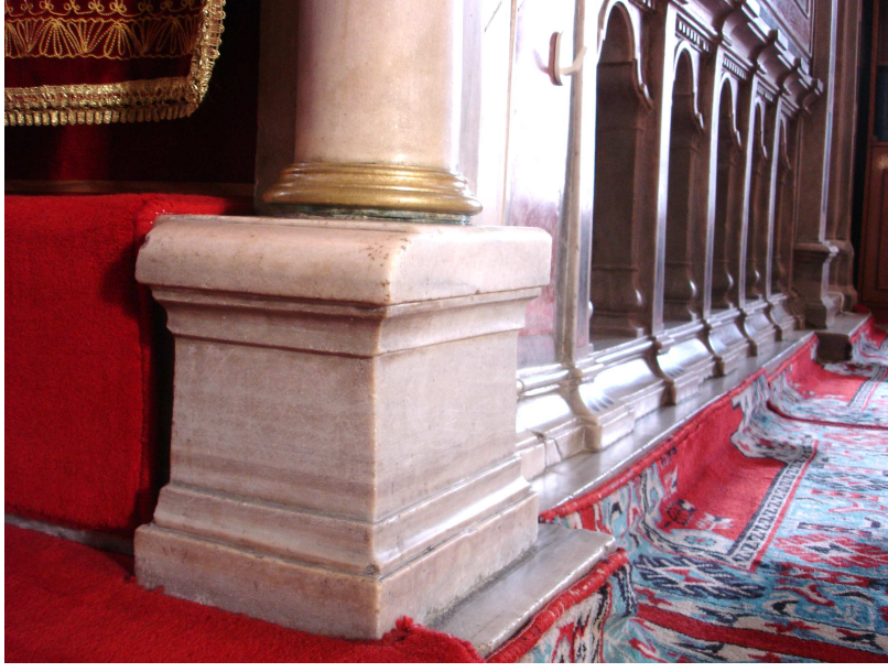
Şekil E.12: Minbere çıkış kemerini taşıyan sütun kaidesi (Demir, 2009)
