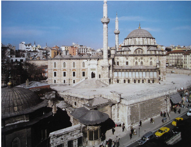
Şekil 2.2: Laleli Külliyesi'ne genel bakış (Kuban, 2007: 540)
