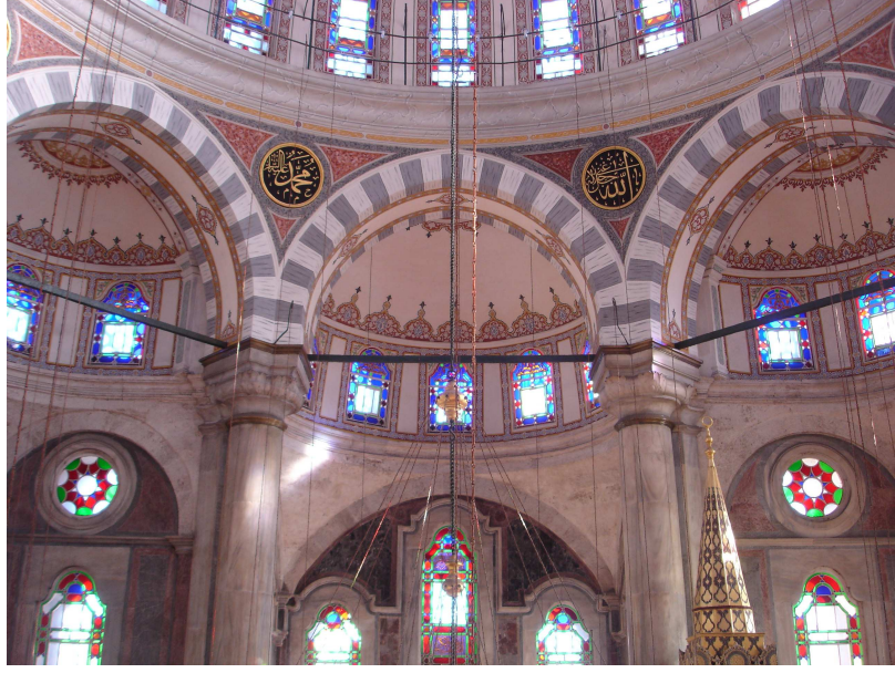
Şekil D.5: Laleli'deki taşıyıcı sivri kemerler (Demir, 2009)
