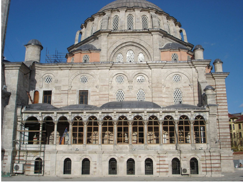
Şekil 2.4: Laleli Camisi güneybatı duvarındaki yan sofalar
