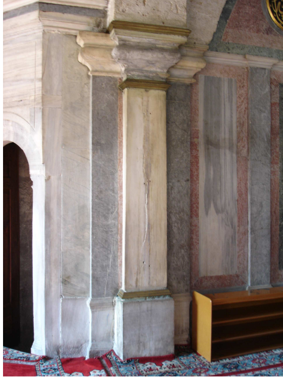
Şekil E.26: Mahfil duvar yüzeyinde pilaster demeti (Demir, 2009)
