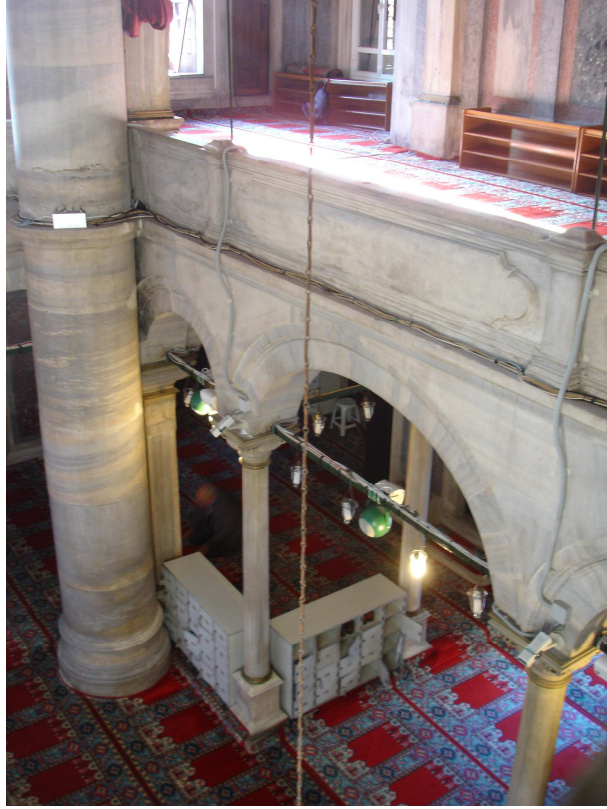
Şekil C.24: Mahfil taşıyıcı sütunları, kemer ve parapet ilişkisi (Demir, 2009)
