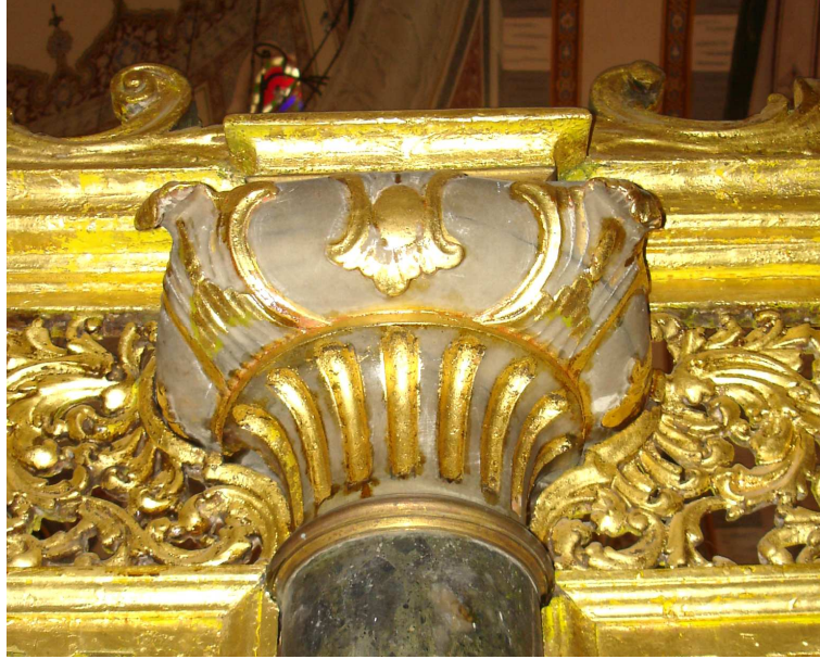
Şekil E.9: Hünkar mahfili ahşap kafes taşıyıcı sütun başlığı (Demir, 2009)
