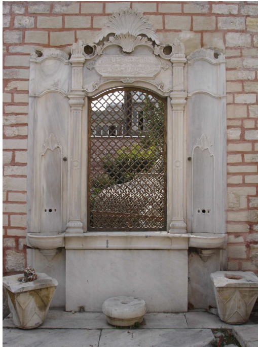
Şekil E.15: Rampa üzerindeki kullanımda olmayan çeşme (Demir, 2009)
