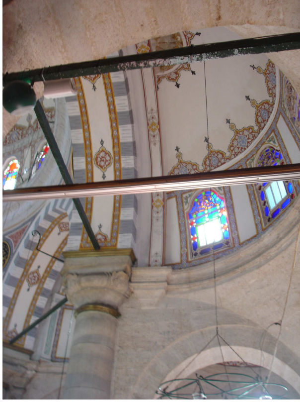
Şekil C.12: Yarım kubbelerin iç yüzeyi, ana taşıyıcı kemer ve iç yüzeydeki ikinci kemerin oturduğu sütunsuz başlık (Demir, 2009)
