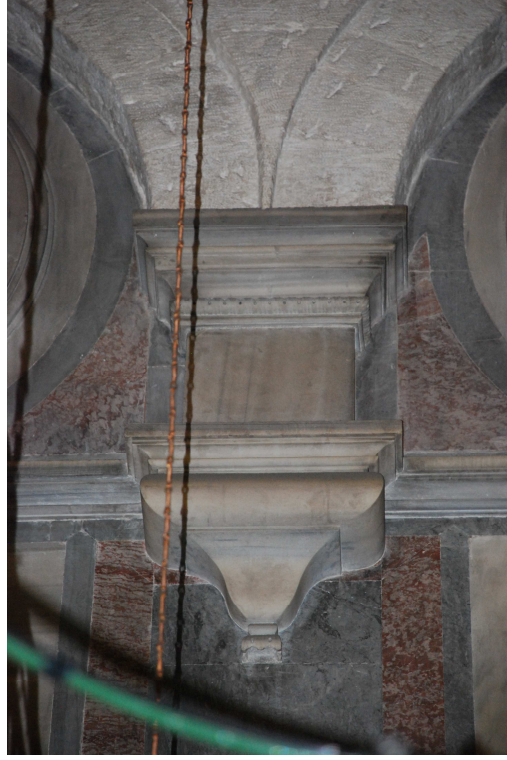
Şekil E.52: Duvar yüzeyinde kemerlerin oturduğu konsollar (Demir, 2009)
