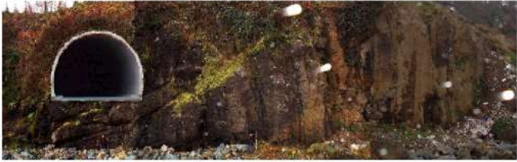
Şekil 1.3: Pazar Tüneli Sağ Tüp Girişi (EMAY 2002)
