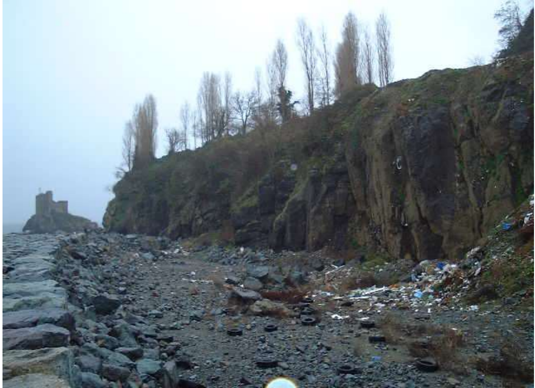
Şekil 1.1: Tünel güzergahının geçeceği inceleme sahasının görünümü.
