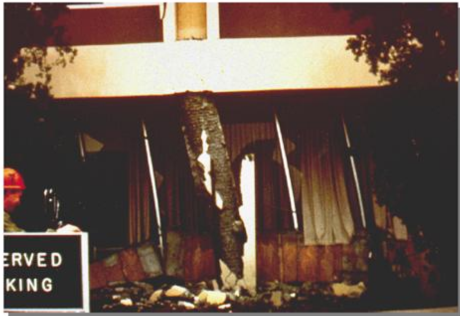
Şekil 2.6 : Sargı donatılı kolon
