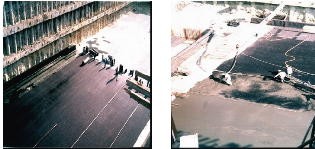
Şekil 4.11. Yalıtım üzerine keçe serilmesi ve koruma betonu dökümü [23]
