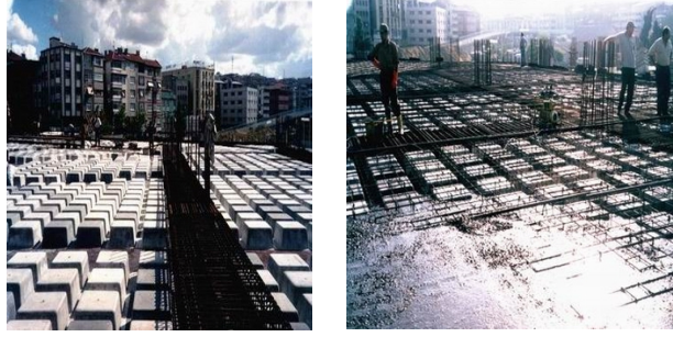
Şekil 5.52. Kaset döşeme hazırlık ve beton döküm aşamaları [24]
