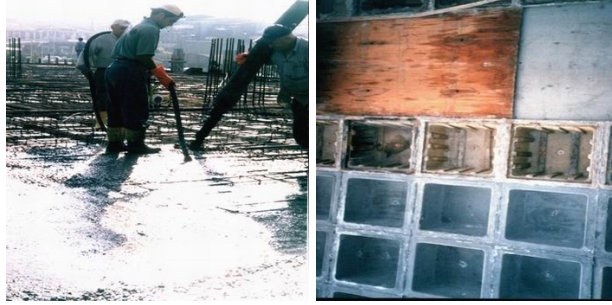
Şekil 5.53. Kaset döşeme beton döküm ve uygulama sonrası söküm işlemi [24]
