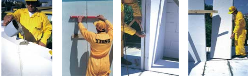
Şekil 5.32. Gazbeton taşıyıcı duvar uygulama yöntemleri [40]
