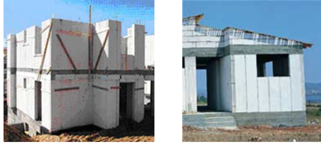
Şekil 5.33. Taşıyıcı duvar elemanı ve uygulaması [40]
