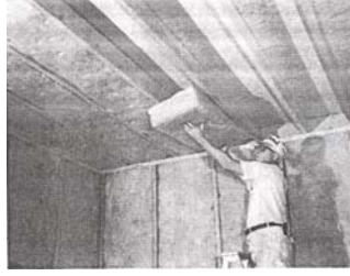
Şekil 4.22. Döşeme altına ses yalıtım malzemesi kaplanması [25, s.78]
