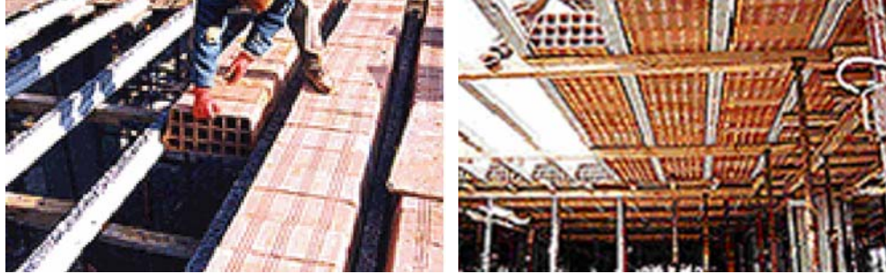
Şekil 5.71. Prefabrike döşeme kirişleri kullanılmış uygulamalar [68]
