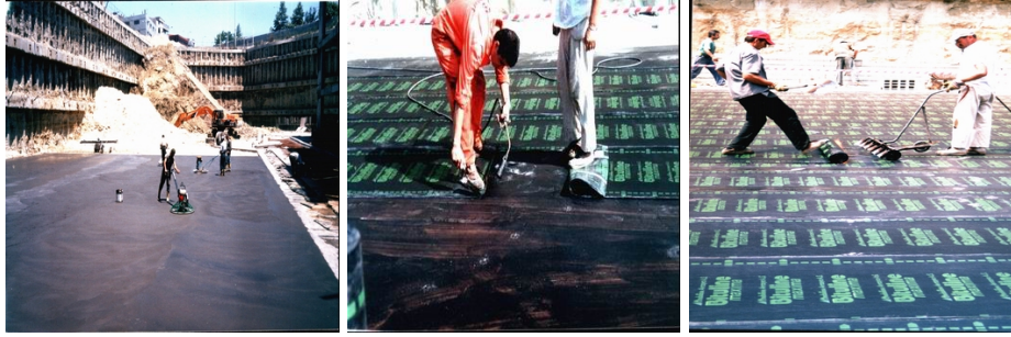
Şekil 4.10. Grobeton üzeri perdahlama ve su yalıtımı [23]
