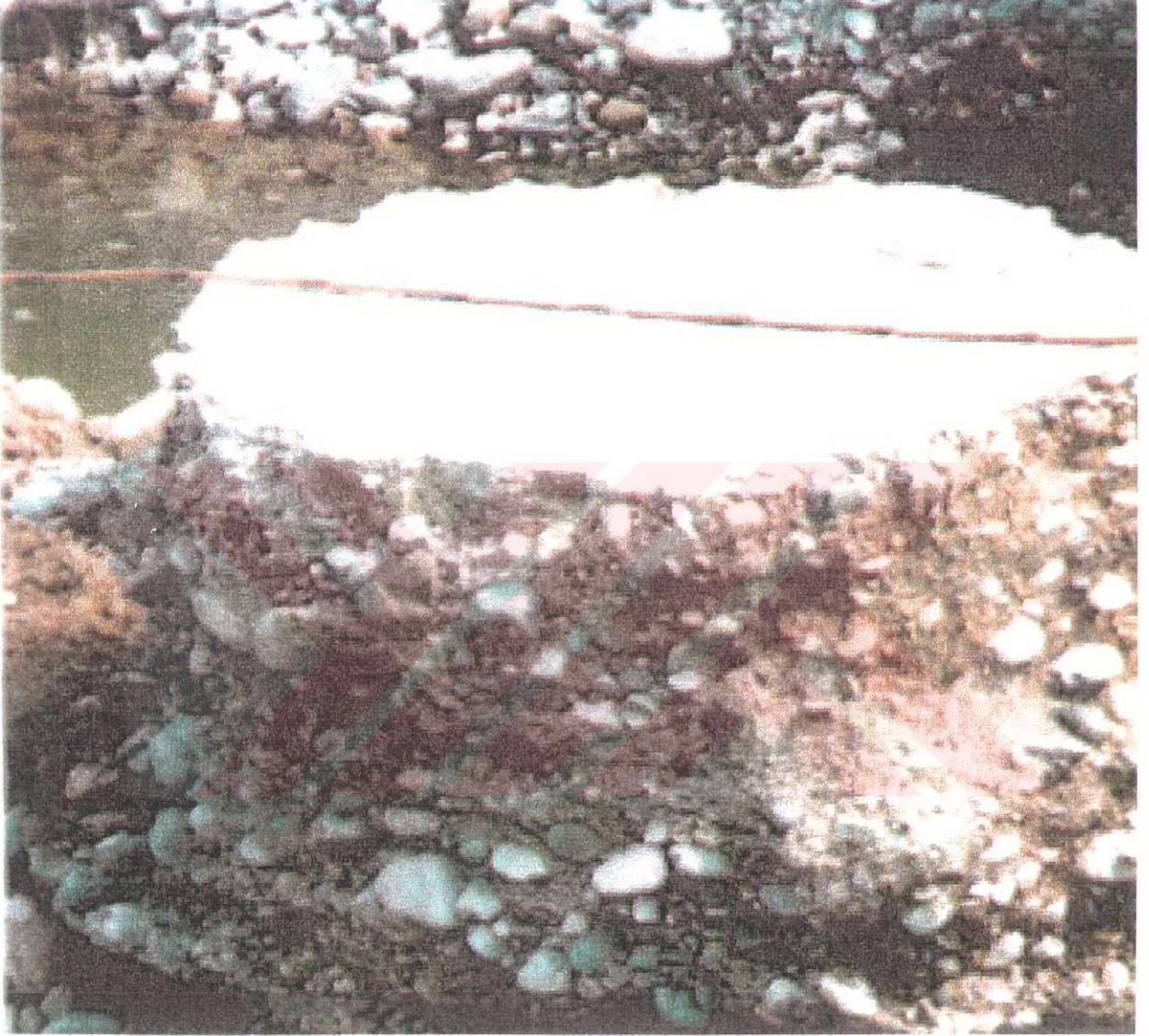
Şekil 5.1. Çakıl zeminde gerçekleştirilen jetgrout kolonu [23]
