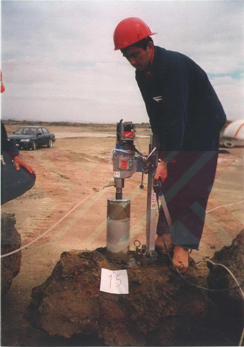
Şekil 9.2. Jetgrout kolonundan karot alınması [25]
