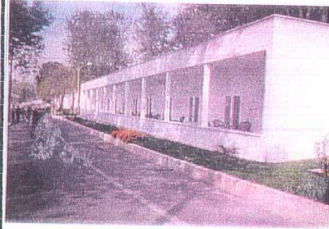
Şekil(3.3.1)5.3-5. Komplekse Ait Dış Görünüşler
