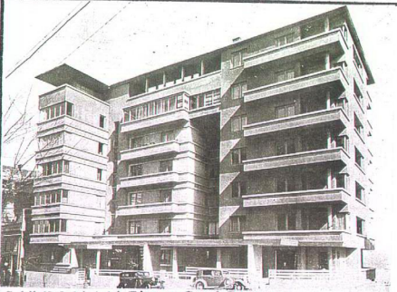
Şekil (3.3.1.) 1.1.b.Binanın Genel Görünüşü
