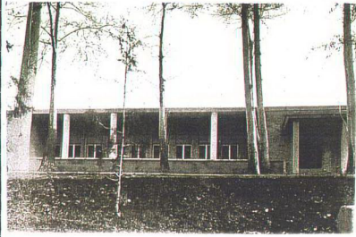
Şekil(3.3.1)4.6.1.a.Binanın Cephesinden Bir Görünüş
