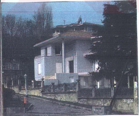
Şekil(3.3.1)1.8.a.Binanın Yoldan Görünüşü(foto:U.Tanyeli)
