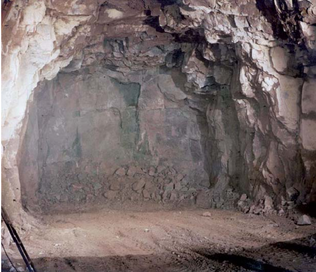
Şekil 3.10 : A sınıfı, Roma-L'aquila karayolu tüneli [9]
