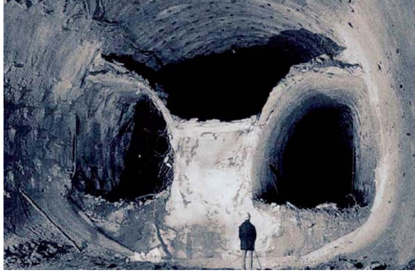
Şekil 2.8 : NATM 3 aşamalı kazı [12]
