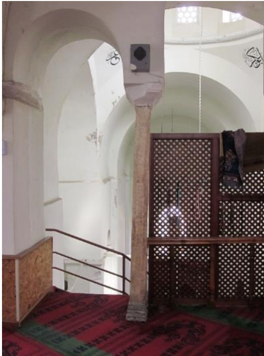
Şekil 6.4: Galeri katındaki sütunlarda düşeyden sapmalar.
