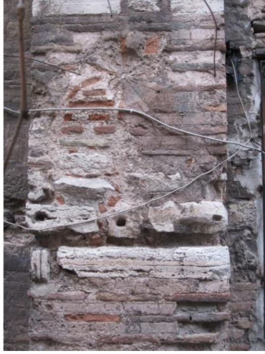
Şekil 4.60: Pilastrın alt kısımlarındaki taş-tuğla örgü ve yukarıdaki dairesel motif.
