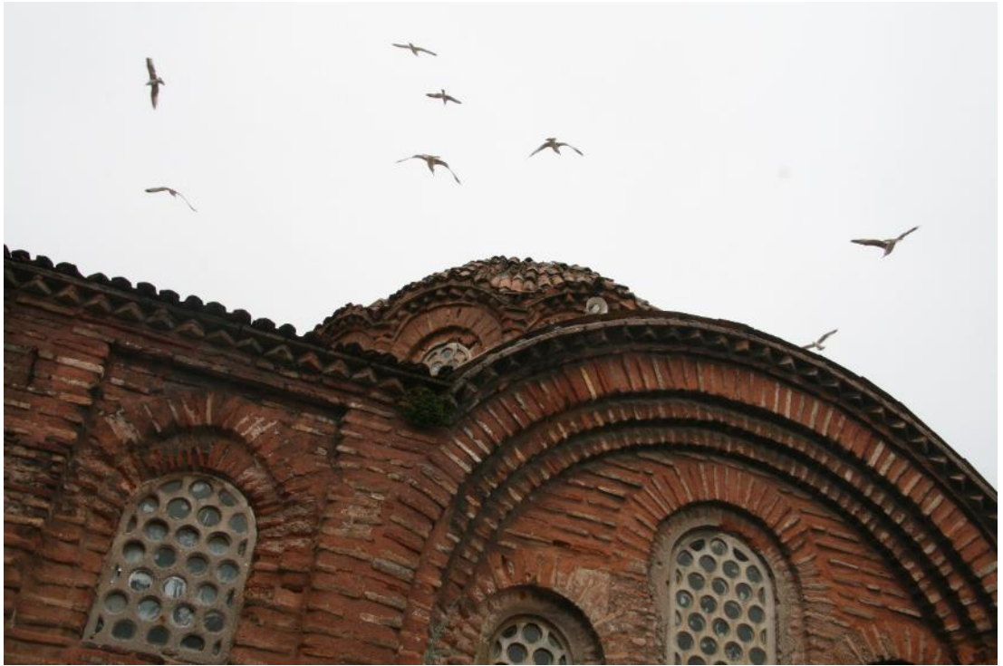
Şekil B. 88: Güney cephesi.
