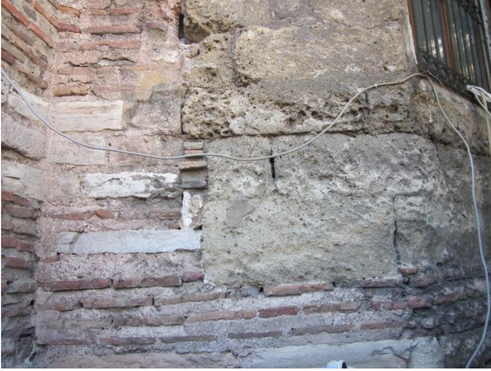
Şekil 4.109: Doğu cephesinde, yapının camiye dönüştürülmesi sırasında apsisin kapatılmasında kullanılan od taş bloklor.
