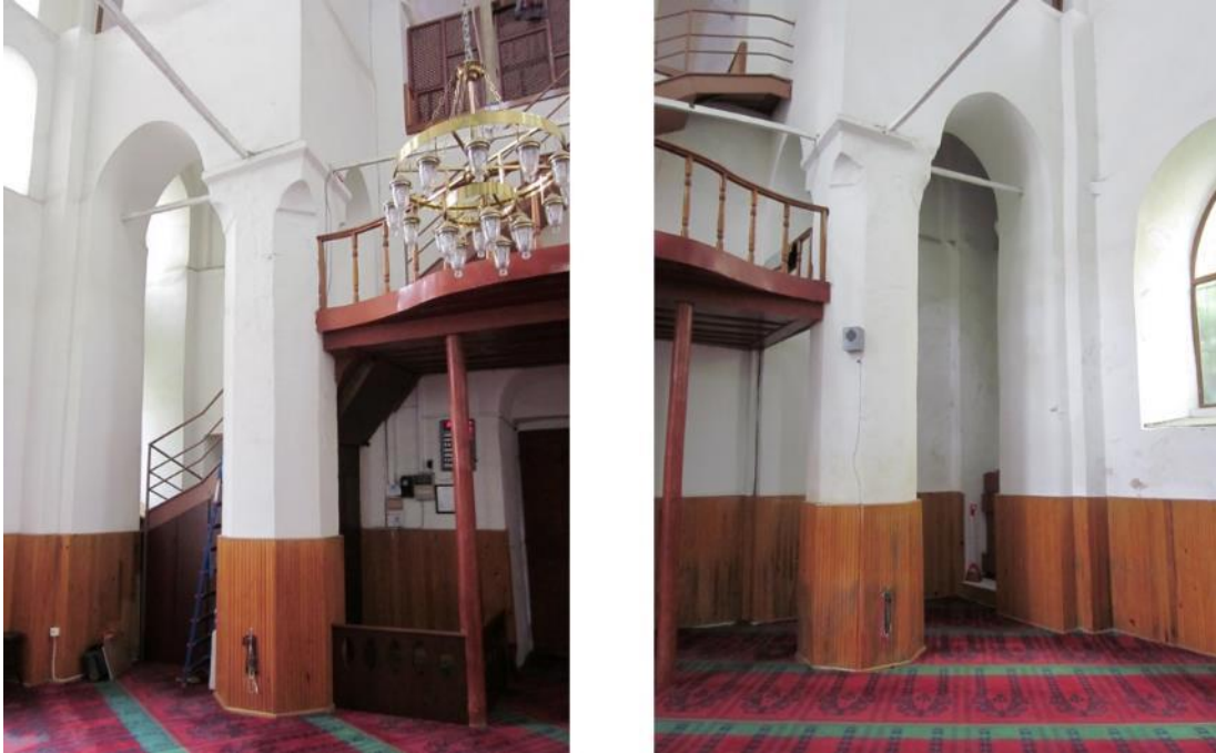
Şekil 4.37: Ana kubbeyi taşıyan, batı yönündeki sekizgen ayaklar (Soldaki fotoğraf güneybatı yönündeki ayak, sağdaki fotoğraf kuzeybatı yönündeki ayak)
