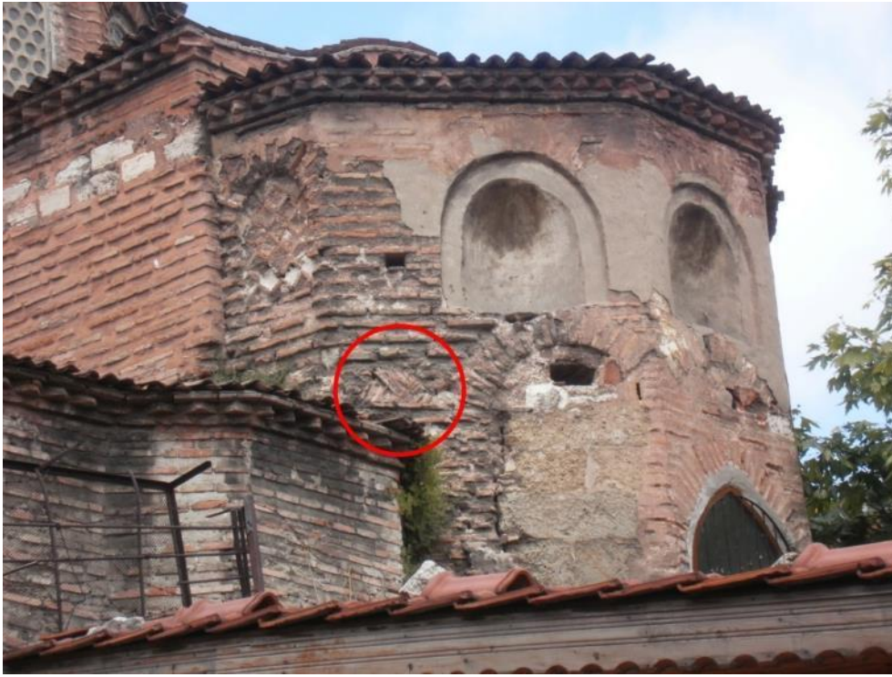
Şekil 4.79: Apsisin en üst kısmındaki sıvalı kör nişler- alt kotta kapatılmış nişler.
