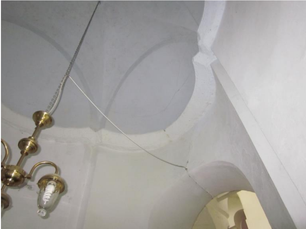
Şekil 4.43: Kuzey hücrede, dairesel kısımda iki parça halindeki taş silme.
