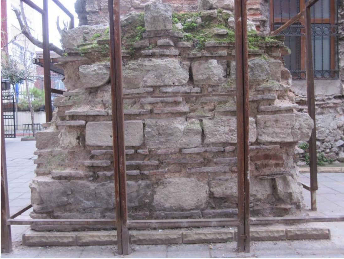
Şekil 4.94: Minarenin, yapının güney cephesinden görünüşü.
