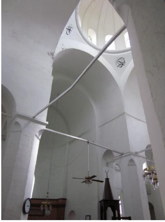
Şekil 6.3: Yangın etkisi ile demir gergilerde oluşmuş hasarlar.
