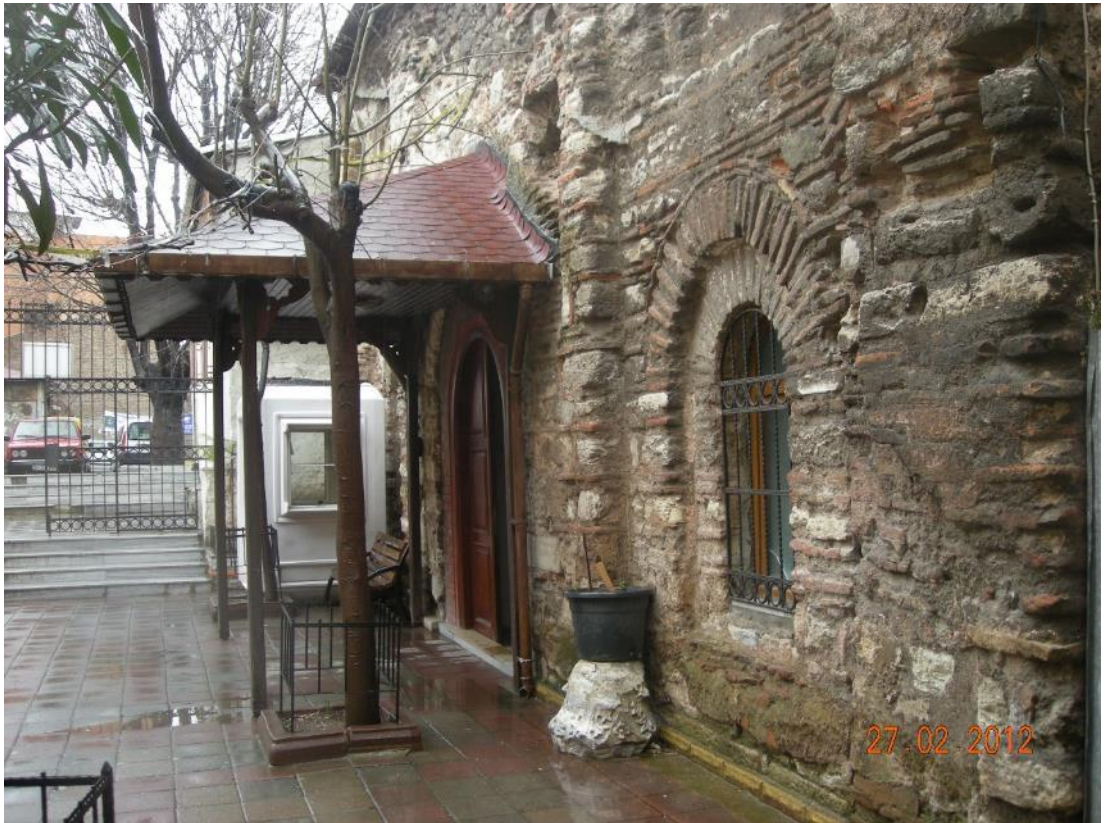
Şekil B. 84: Batı cephesi.
