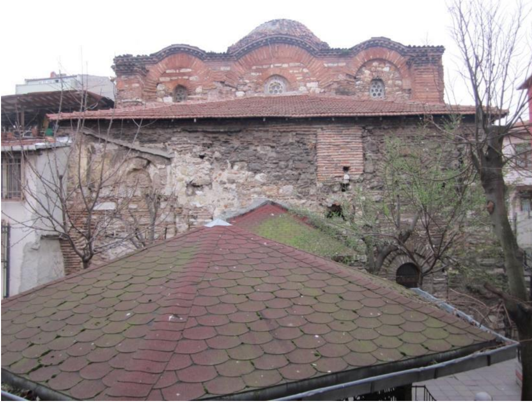
Şekil 4.46: Batı cephesi genel görünüm.
