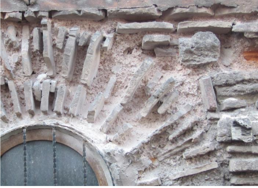
Şekil 4.111: Güney cephesi bölüm 5'teki kemer tuğlalarının arasında görülen, içinde tuğla kırıkları bulunan pembe renkli harç.
