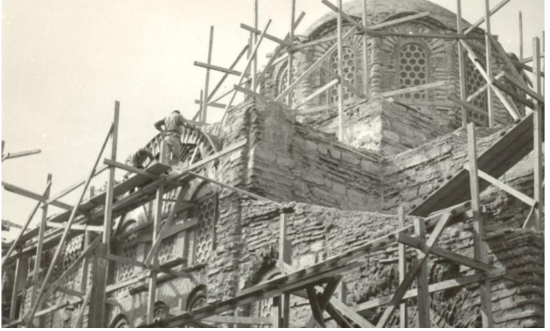
Şekil 5.19: 1970'lerdeki restorasyonda, özgün kemerlerde tamamlama yapılması.
