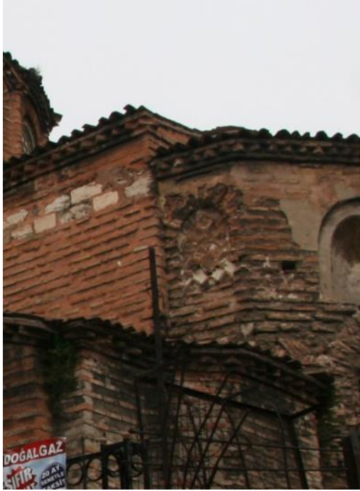
Şekil 4.72: Solda apsis üzerindeki kör niş - sağda resimde köşede balıksırtı motif.
