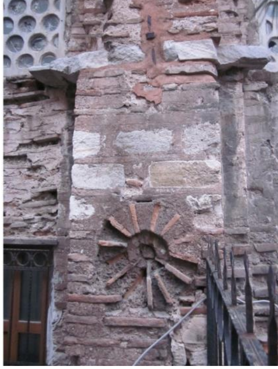
Şekil 4.64: Taş-tuğla pilastr, ortasında dairesel motif ve üstte demir kılıç.
