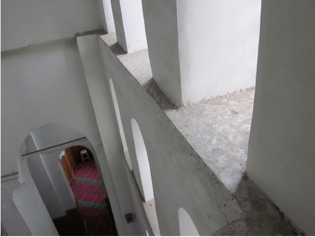
Şekil B. 70: Harimin ana kubbesini destekleyen güney tonozunun iç kısmındaki duvarda, alt ve üst kısım arasında var olan iki kademe
