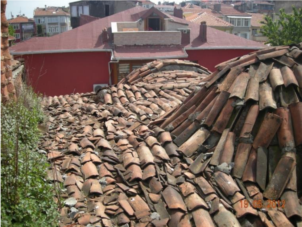
Şekil 4.90: Alaturka kiremit kaplı iç son cemaat yeri orta kubbesi ve arkada alaturka kiremit kaplı dairesel parapet.
