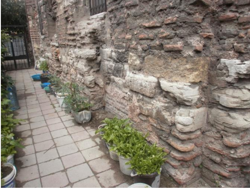
Şekil 4.105: Güney cephedeki taş-tuğla duvar örgüsü.
