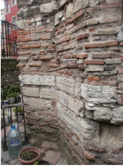
Şekil 4.76: Solda güney hücre dış duvarlarının alt kısımlardaki taş ve tuğla duvar örgüsü - Sağda üst kısımlardaki düz tuğla örgü ve pencere.
