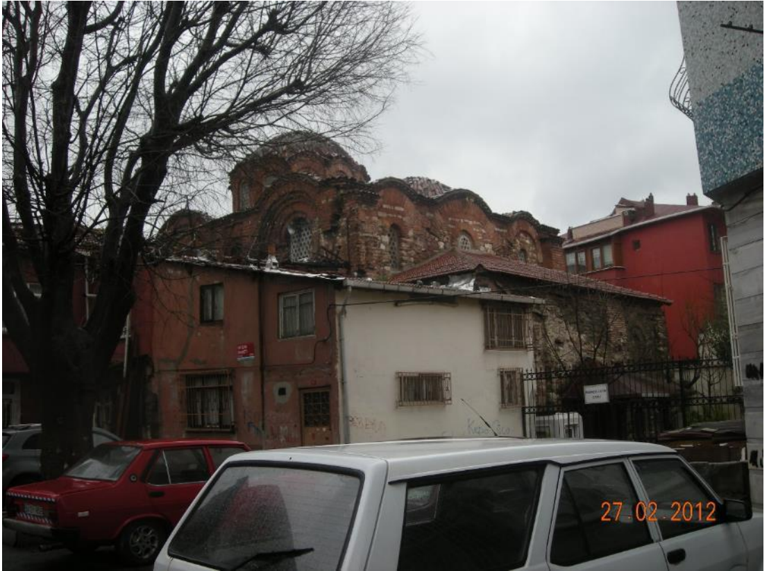
Şekil B. 80: Yapıya kuzeybatıdan bakış.
