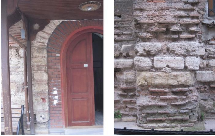
Şekil 4.107: Soldaki fotoğrafta batı cephesinin ortasındaki kemerde ve sağdaki fotoğrafta güney cephesindeki bir pilastrda gizli tuğla tekniğinin kullanımı.
