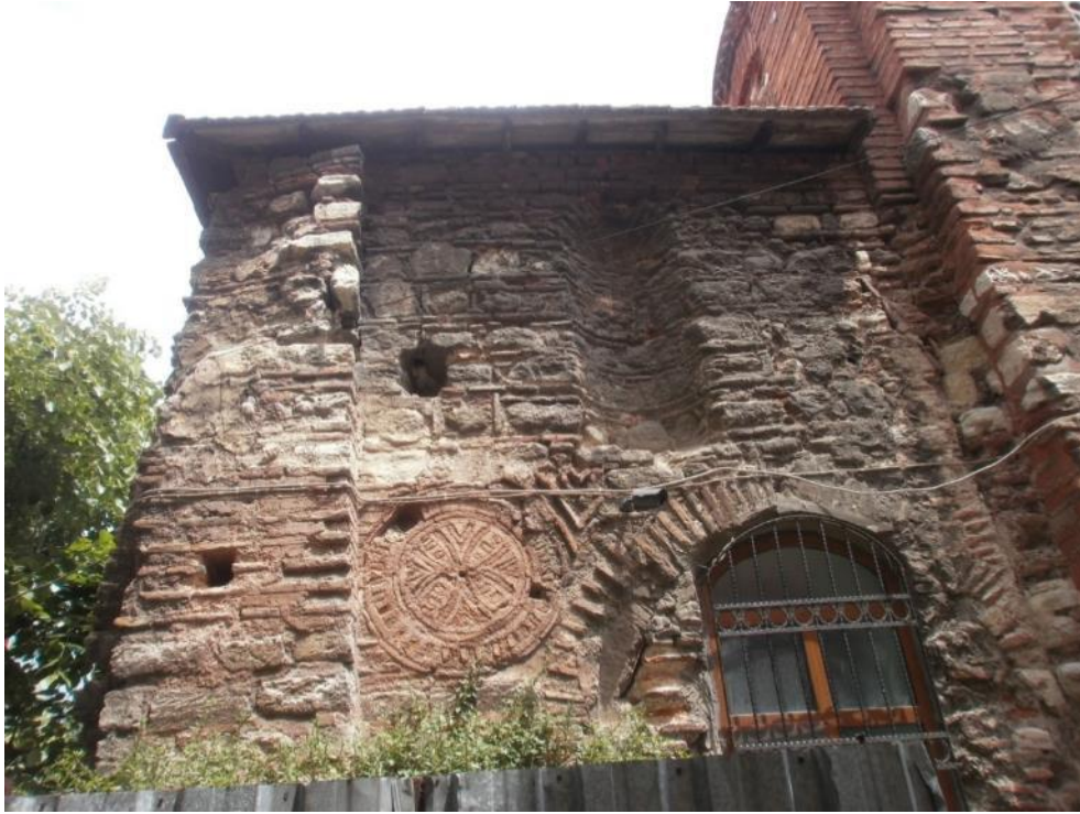
Şekil 4.53: Güney cephe, 1.bölüm.
