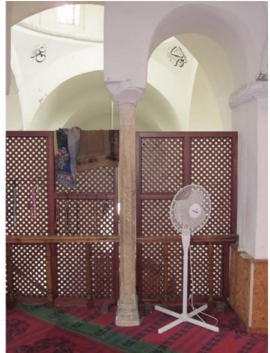
Şekil 6.4: Galeri katındaki sütunlarda düşeyden sapmalar.
