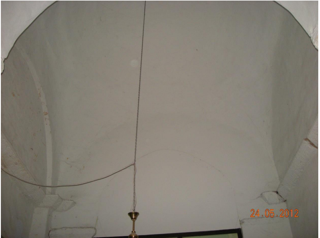
Şekil B. 41: Dış son cemaat yerinin orta kısmının üst örtüsünü oluşturan kubbe.
