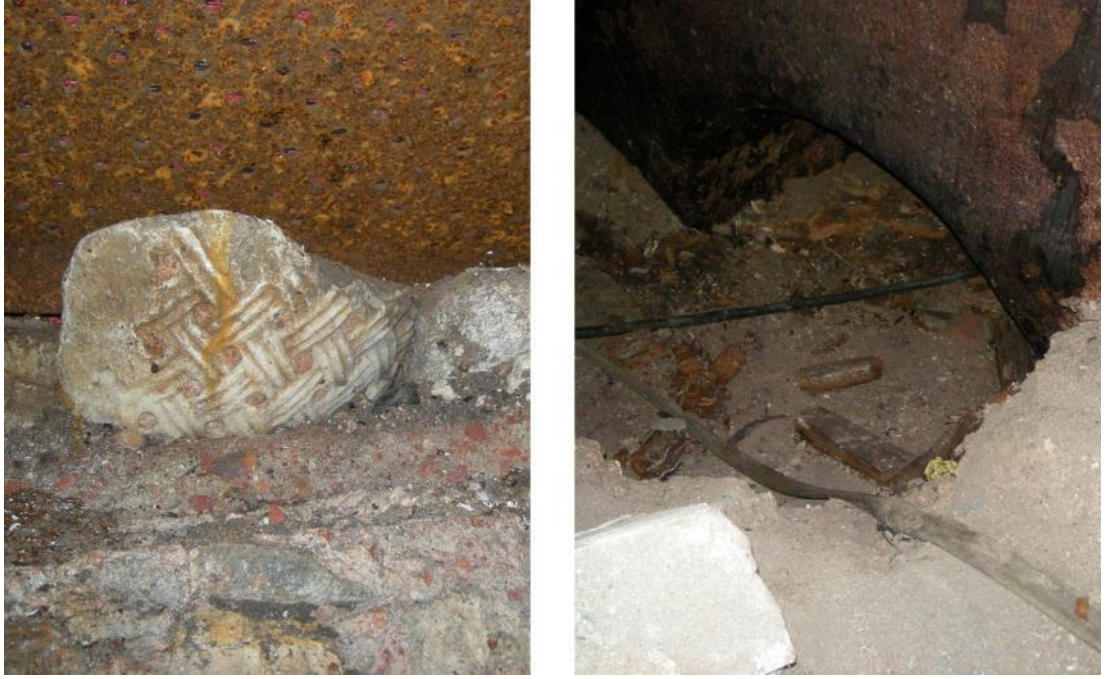
Şekil 4.28: Altındaki sarnıca girişi sağlayan demir kapağın hemen altındaki taş (Soldaki fotoğraf) ve diğer mekânlarla bağlantıyı sağlayan neredeyse kapanmış kemerli geçiş (Sağdaki fotoğraf).
