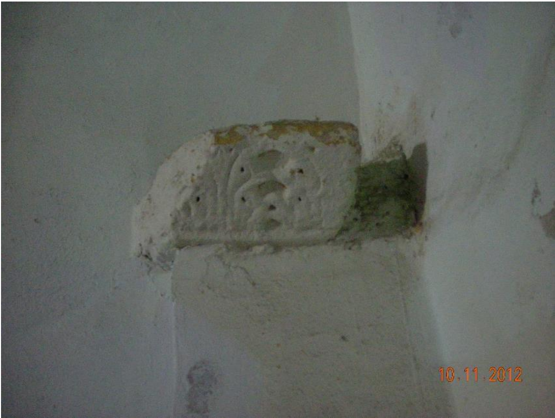
Şekil B. 35: Dış son cemaat yerinin, içerden kuzeybatı köşesindeki sütun başlığı.
