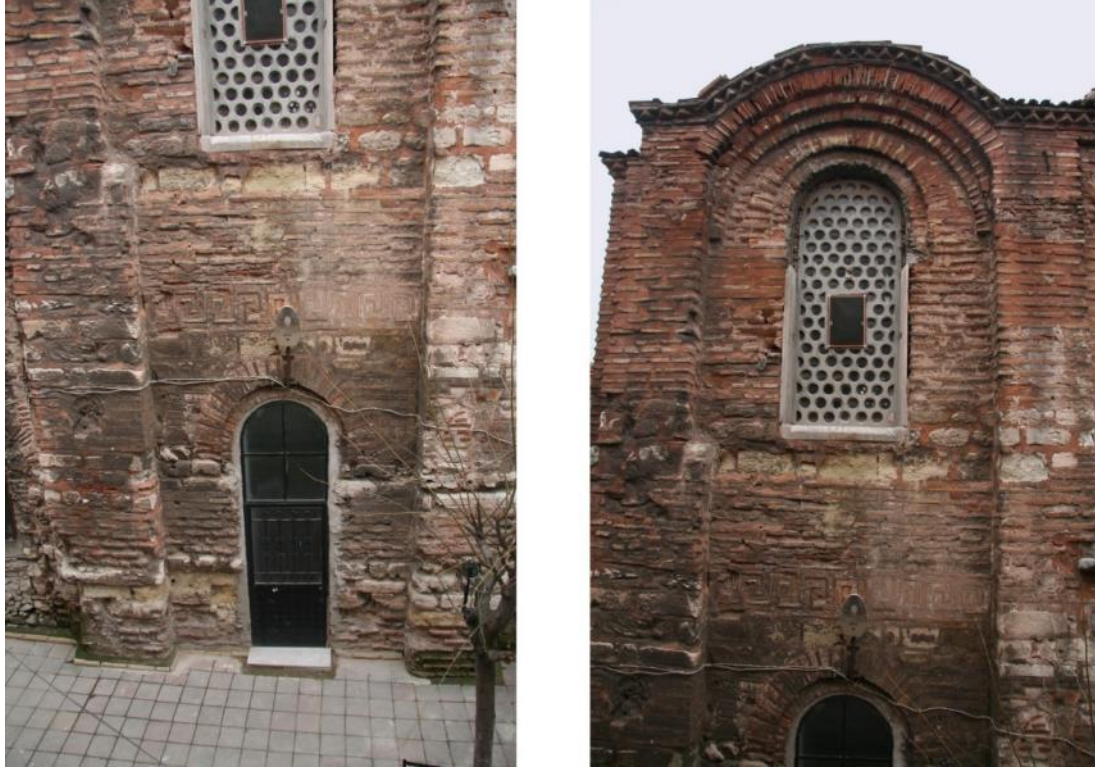
Şekil 4.56: Güney cephe 2. Bölüm.
