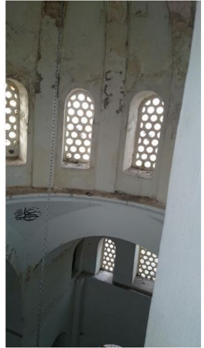
Şekil B. 72: Harimdeki, ana kubbe eteğini dolaşan profilli taş silme
