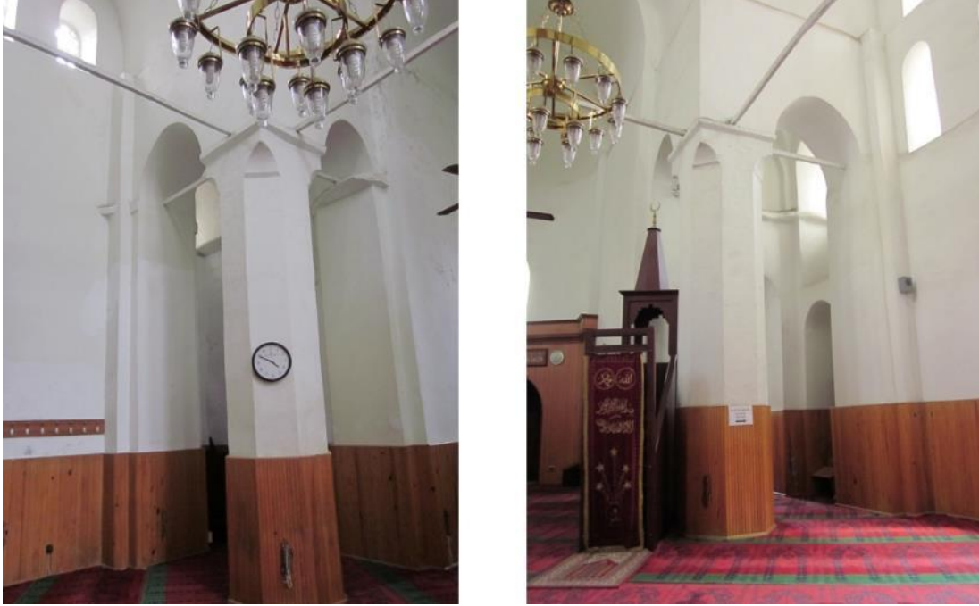
Şekil 4.36: Ana kubbeyi taşıyan, doğu yönündeki sekizgen ayaklar (Soldaki fotoğraf kuzeydoğu yönündeki ayak, sağdaki fotoğraf güneydoğu yönündeki ayak).
