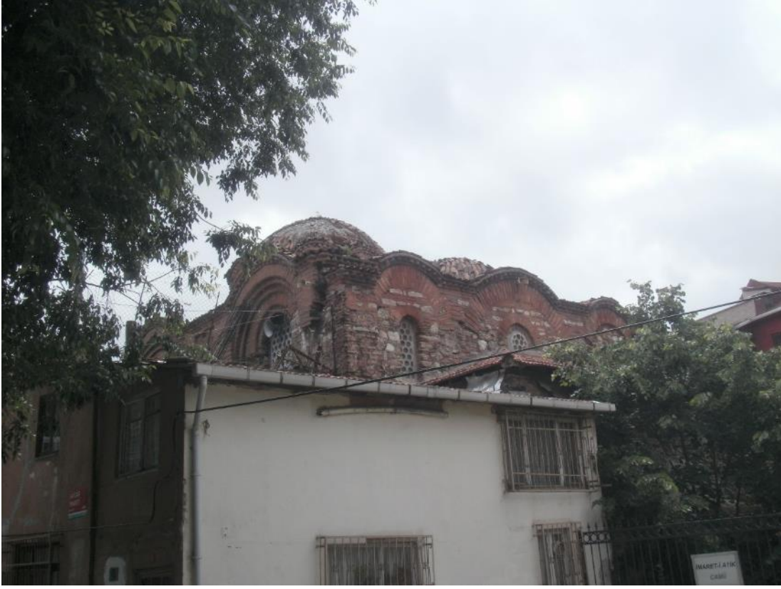
Şekil B. 85: Batı cephesi.
