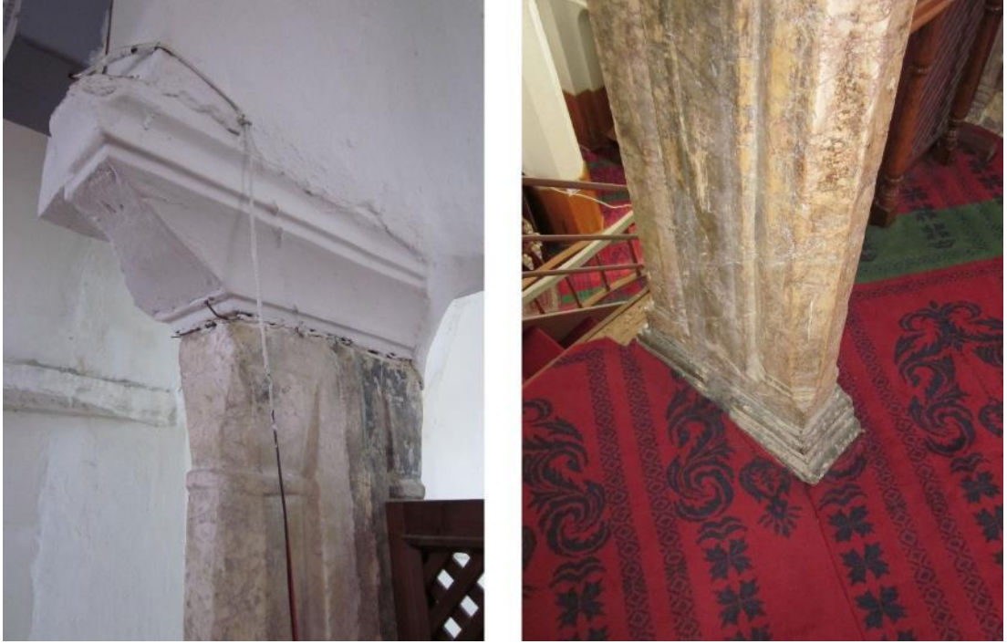
Şekil B. 56: Galeri katındaki taş sütundan detay- soldaki fotoğrafta dışa taşkın sütun başlığı (Eski fotoğraflarda tespit edilmiş olan haç motifinin üstü sıvanmış) ve sağdaki fotoğrafta profilli taş kaide.
