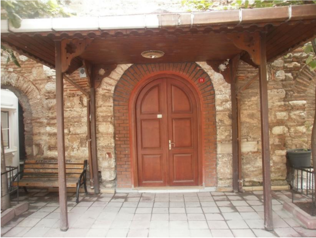
Şekil 4.47: Ahşap giriş kapısı ve saçak.
