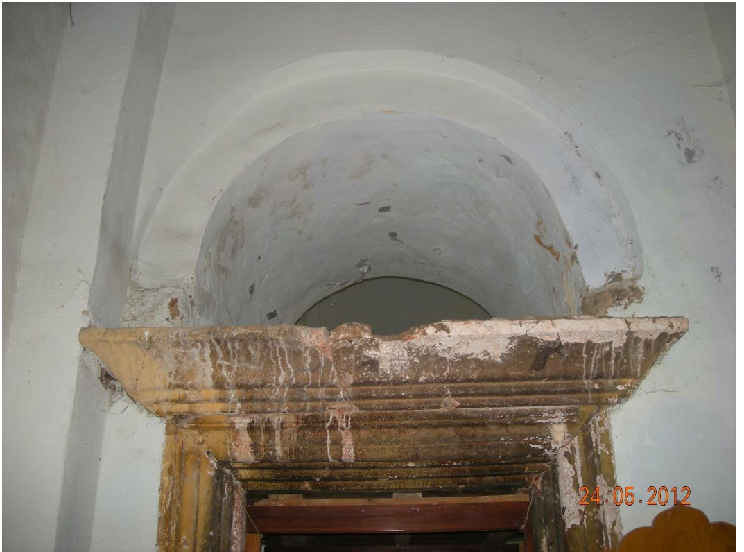
Şekil B. 33: Dış son cemaat yerini iç kısma bağlayan kuzey kapısı (Üstteki profilili taştaki haç mofiti neredeyse yok olmuş durumdadır).
