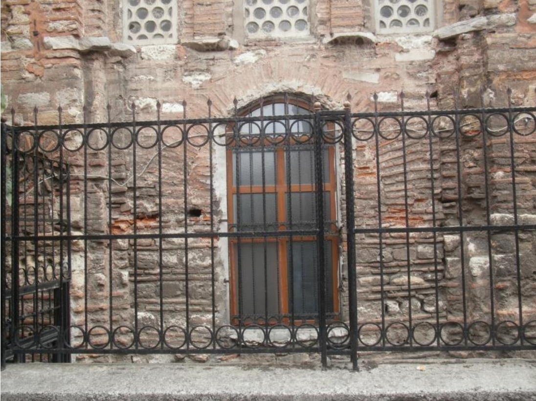
Şekil 4.65: Dairesel kemerin altında, yanları ve alt kısmı kısmen doldurularak elden edilen boşlukta bulunan pencere, üst kısımda mermer sütun başlıkları.
