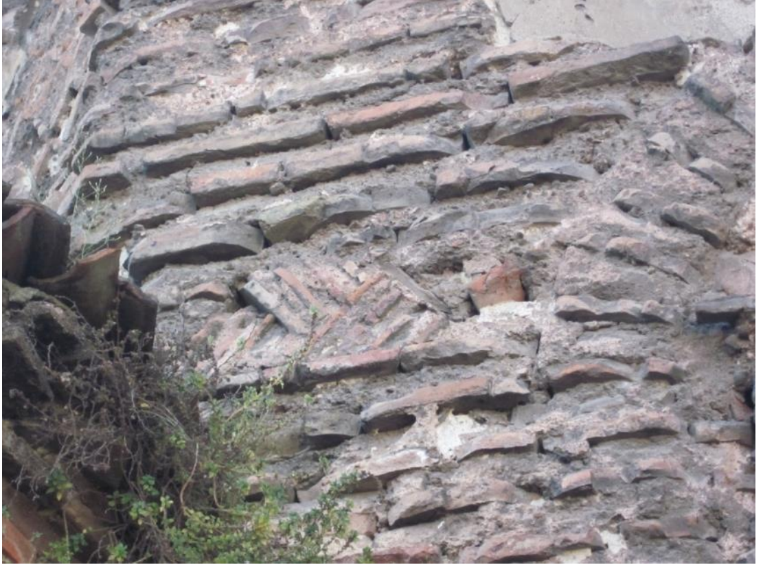
řekil 4.80: Kemerin yan kısmındaki eđik dama řeklinde tuđla friz.
