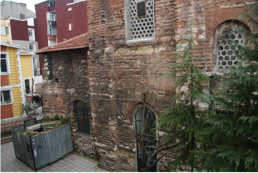
Şekil B. 89: Güney cephesi.
