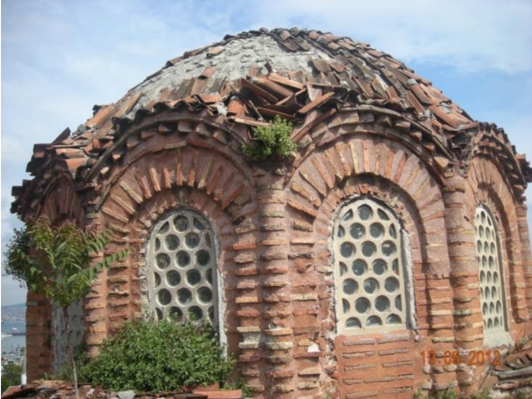
Şekil 4.92: Kubbe üstü beton kaplama ( en üstte alaturka kiremit kubbe örtüsü).
