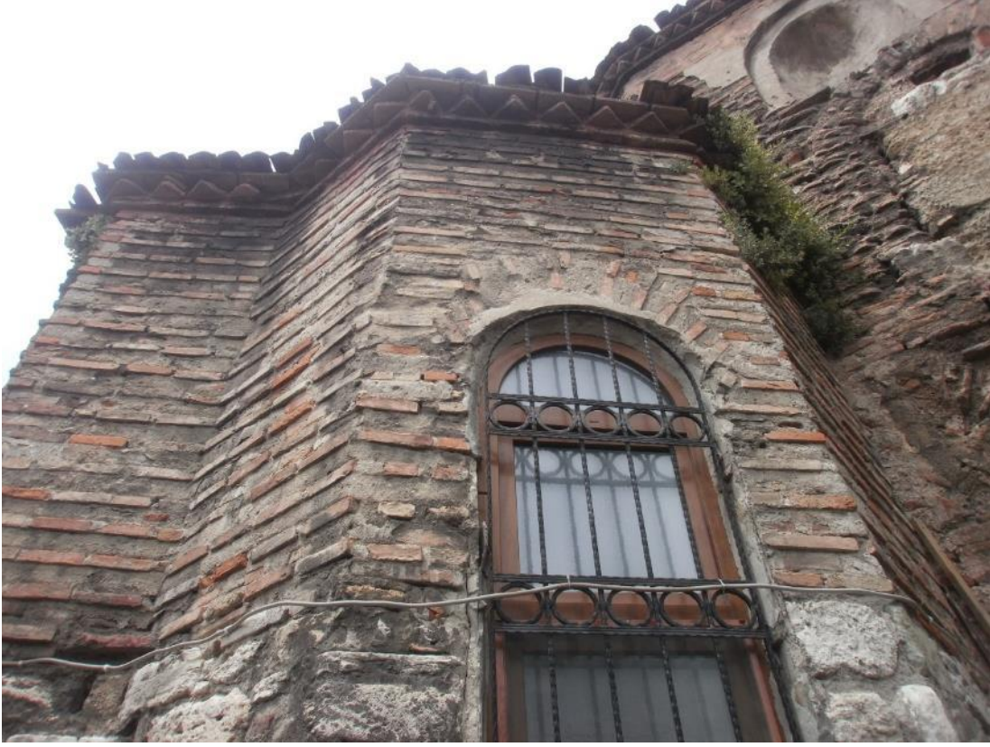
Şekil B. 93: Doğu cephesi
