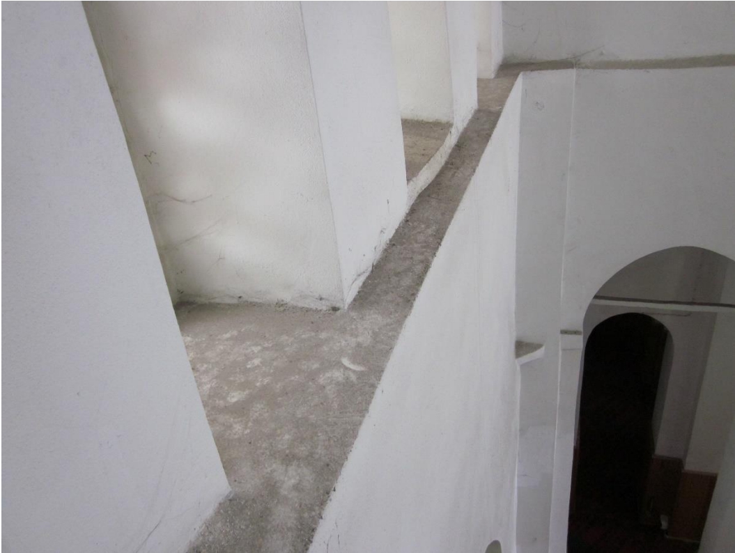
Şekil B. 71: Harimin ana kubbesini destekleyen güney tonozunun iç kısmındaki duvarda, alt ve üst kısım arasında var olan tek kademe
