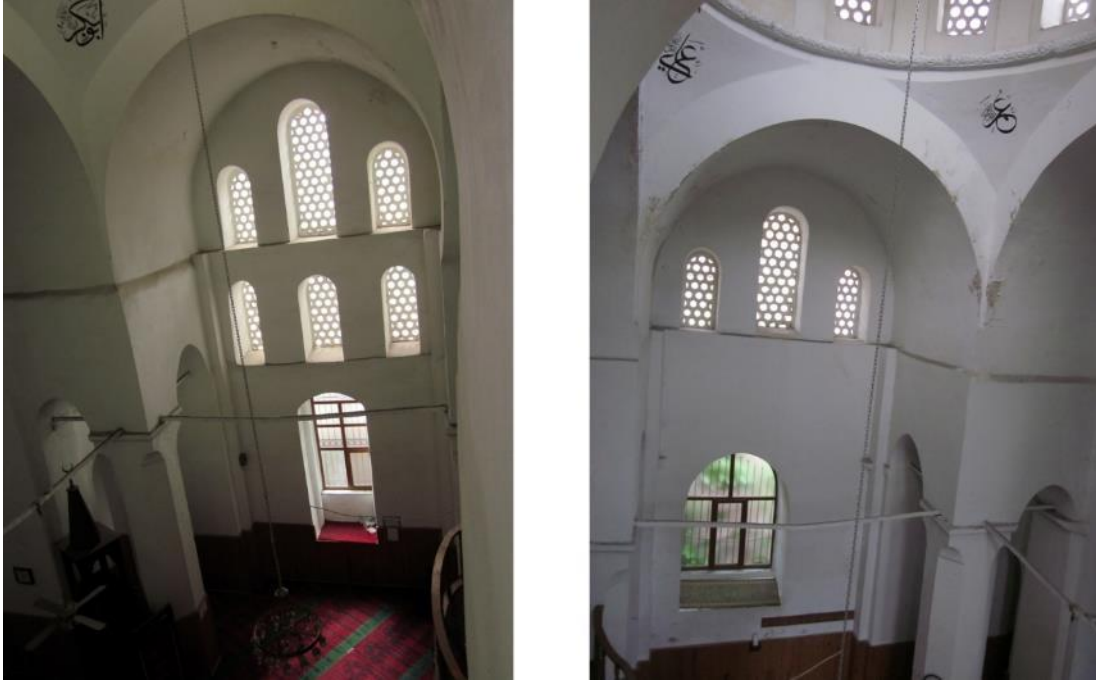
Şekil 4.38: Harim bölümünde, güney ve kuzey haç kollarının altındaki duvarlar (soldaki fotoğraf güney duvarı, sağdaki fotoğraf kuzey duvarı).
