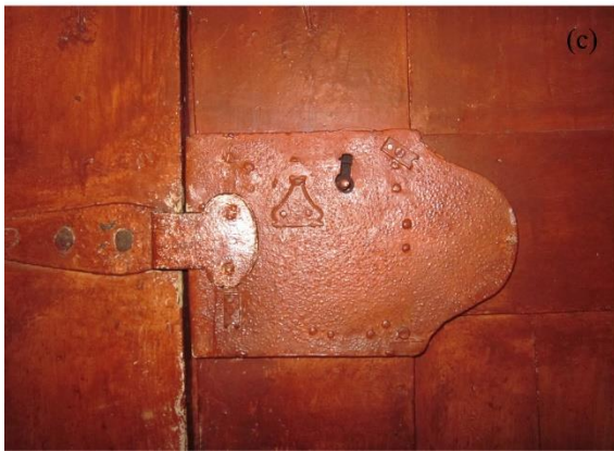
Şekil B. 78: Harimin ahşap kapısından detaylar: (a)İç bakış, (b)Demir kilit, (c) Demir kilit mekanizması, (d) Demir güllap, (e) Demir üst sürgü, (f) Demir alt sürgü
