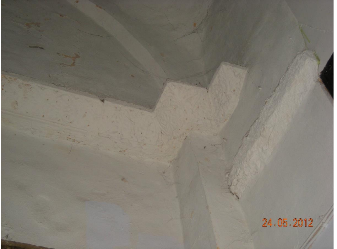
Şekil B. 32: Dış son cemaat yerinden iç kısma geçişin hemen üstünde, payanda tarafından kesilmiş mermer silme.
