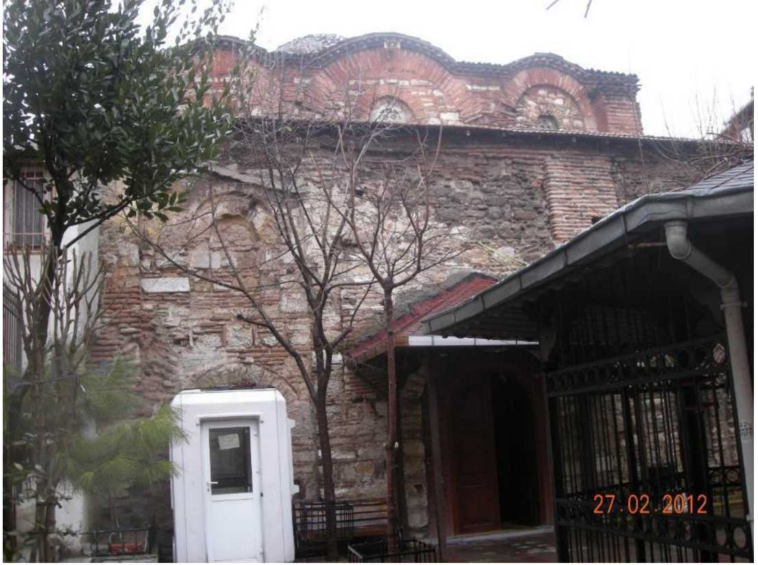
Şekil B. 83: Batı cephesi.
