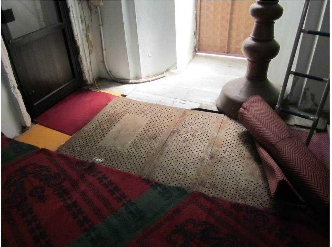
Şekil B. 49: İç son cemaat yeriyle alt yapı bağlantısını sağlayan demir kapaklar
