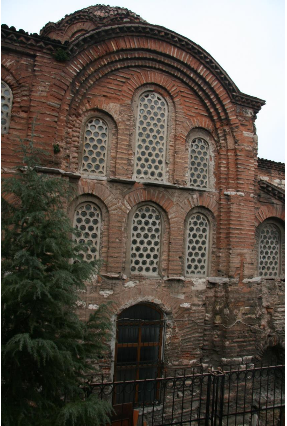
Şekil 4.63: Güney cephe 4. Bölüm.
