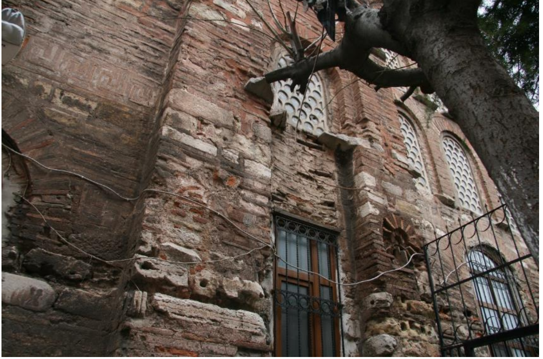
Şekil B. 91: Güney cephesi.
