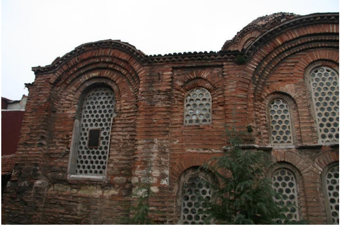
Şekil B. 87: Güney cephesi.
