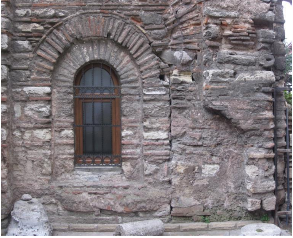
Şekil 4.49: Sağdaki pencere, üstte kesilmiş kemer ve kırık mermer başlık.
