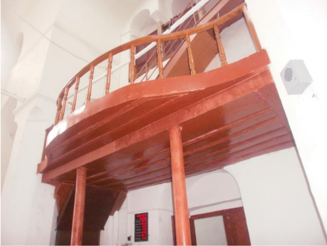
Şekil B. 75: Ahşap dikmelerle taşıyan çıkıntılı asma kat
