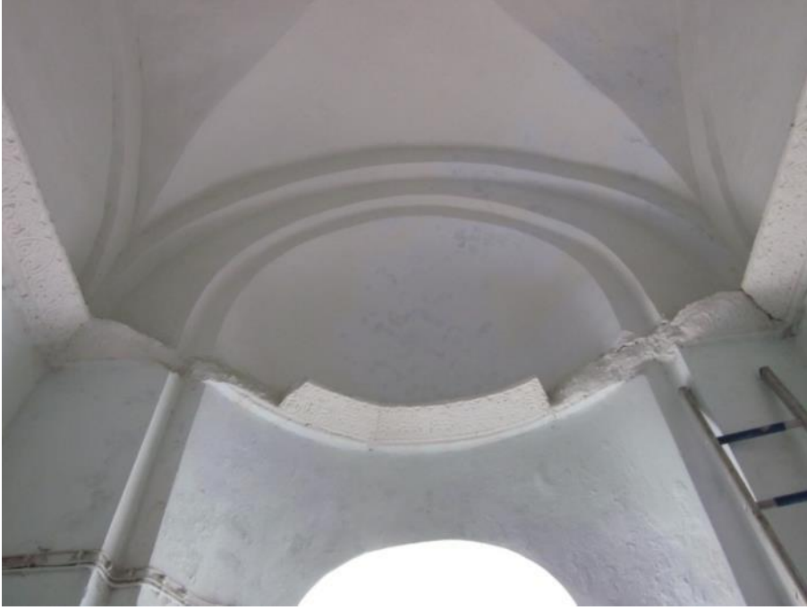
Şekil 4.17: Yuvarlak girintilerin olduğu duvarlardaki taş silmeler.
