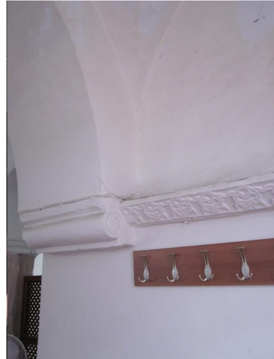
Şekil B. 59: Galeriye üç bölüme ayıran sıvalı dairesele kemerlerin alt kısımlarındaki çıkıntılı taş payandalar.
