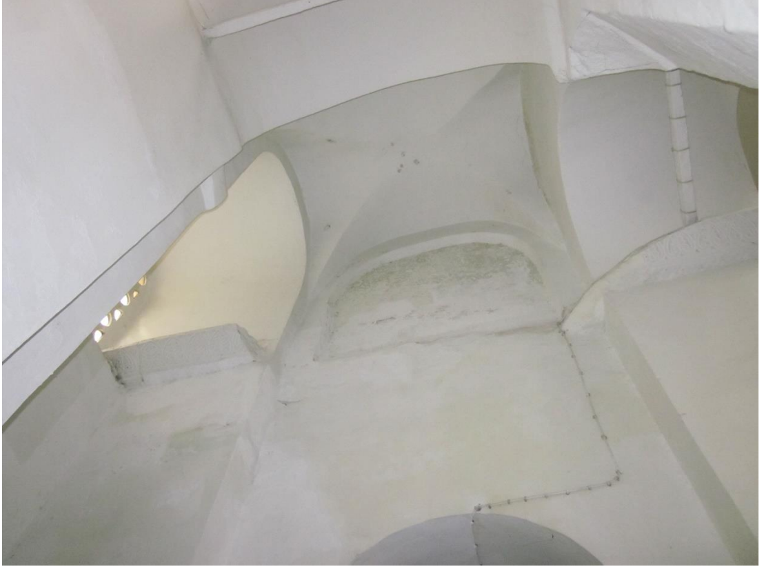
Şekil B. 76: Ana kubbeyi destekleyen kuzey ve batı tonozları arasında kalan dikdörtgen bölümün çapraz tonozlu üst örtüsü
