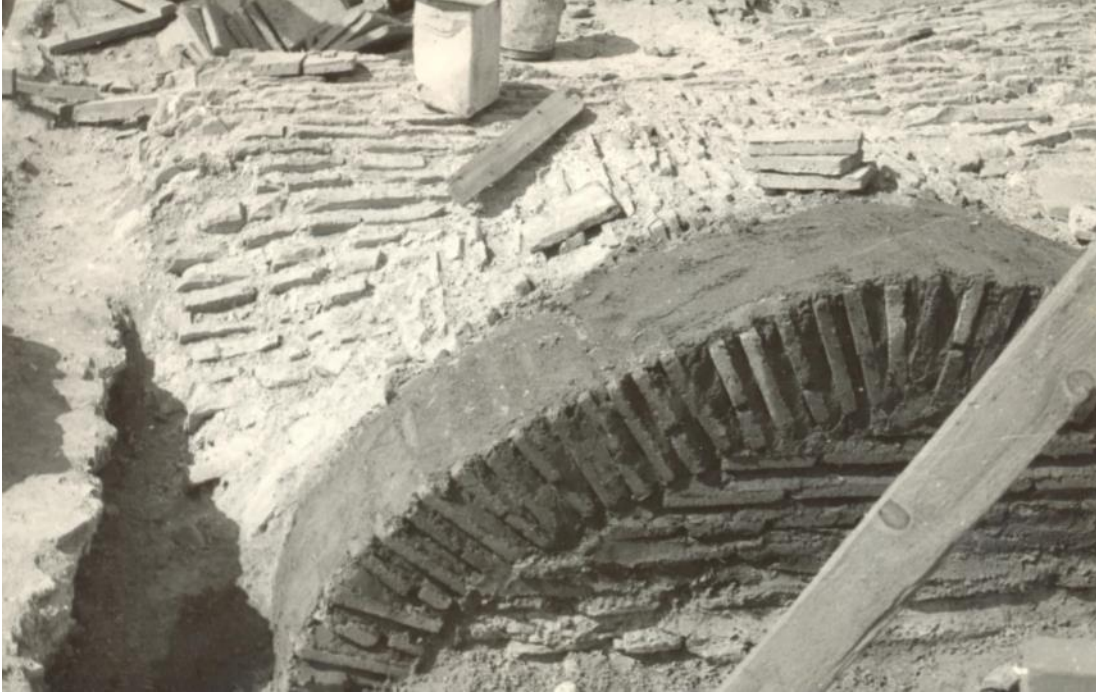
Şekil 5.20: 1970'lerdeki restorasyonda yapılan yeni kemerlerden biri.
