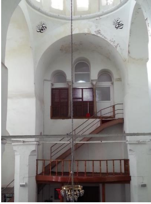
Şekil B. 52: Alt katları, üstteki asma kata ve galeriye bağlayan demir merdiven.
