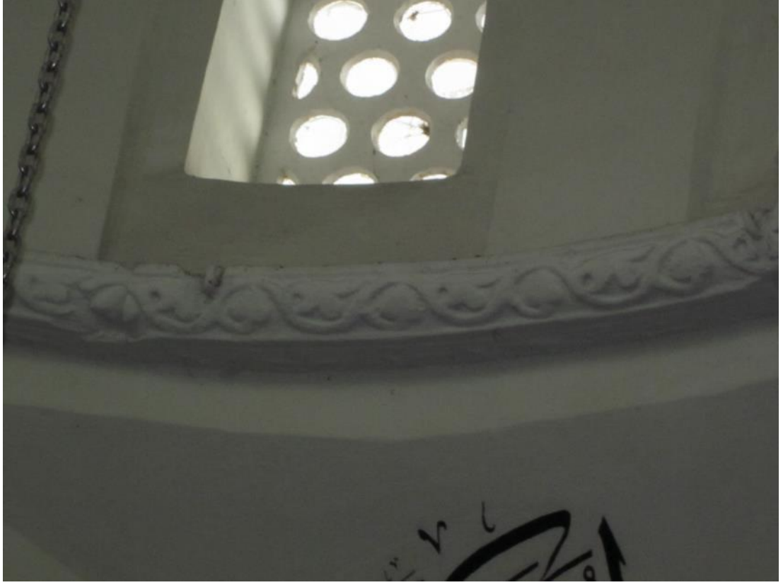
Şekil B. 72: Harimdeki, ana kubbe eteğini dolaşan profilli taş silme
