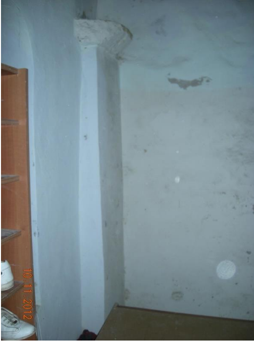
Şekil B. 34: Dış son cemaat yerinden kuzeye bakış-Soldaki fotoğrafta köşedeki dikme ve mermer başlık, sağdaki fotoğrafta basit profilli taş söveleri olan kapatılmış geçiş
