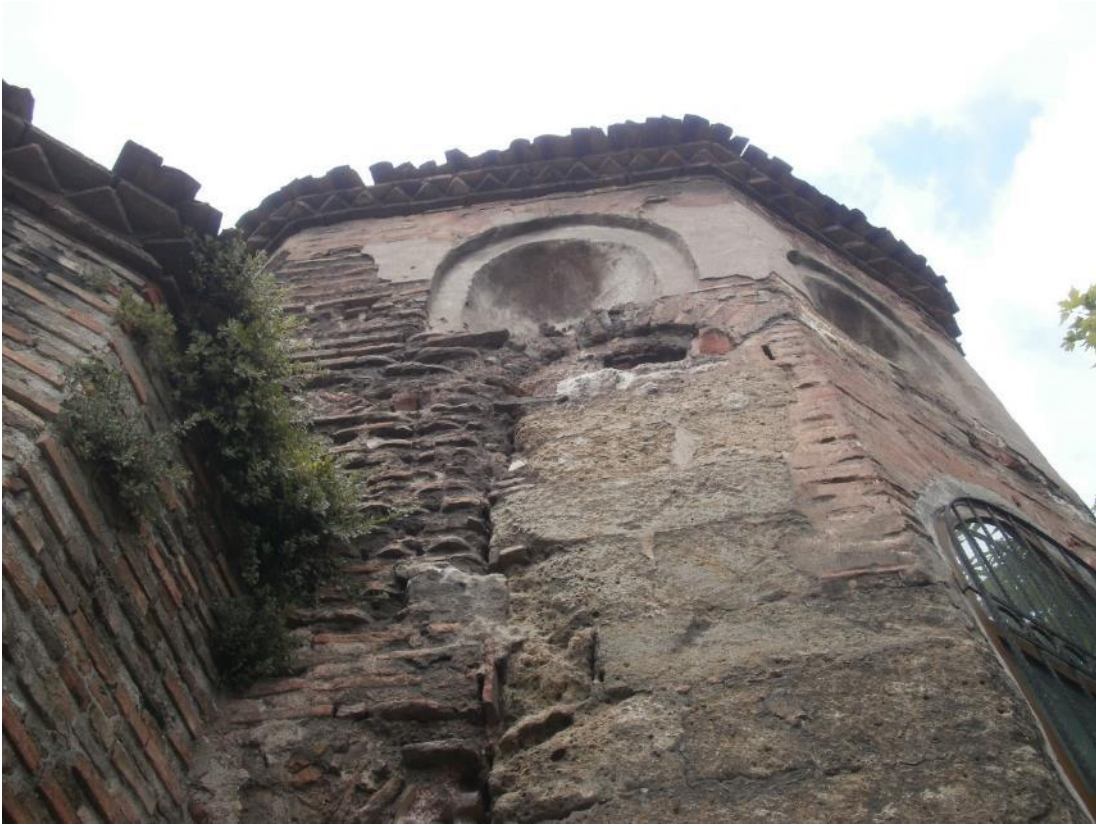
Şekil B. 94: Doğu cephesi.
