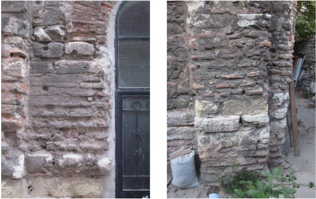
Şekil 4.110: Soldaki fotoğrafta, güney cephesi bölüm 2'deki tuğla örgü, sağdaki fotoğrafta güney cephesi bölüm 5'teki tuğla örgü.
