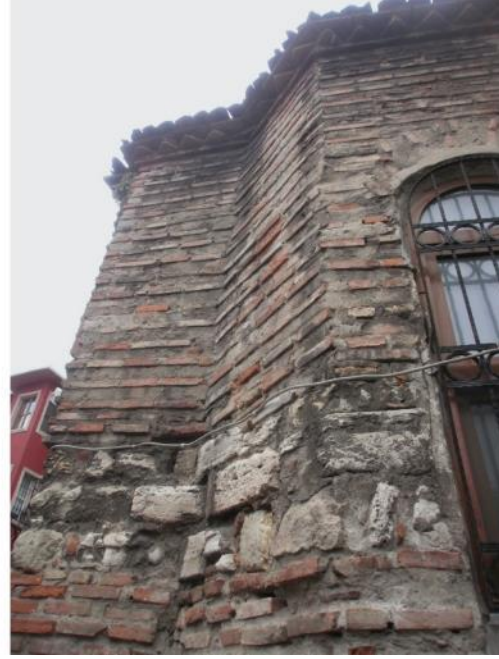
Şekil 4.76: Solda güney hücre dış duvarlarının alt kısımlardaki taş ve tuğla duvar örgüsü - Sağda üst kısımlardaki düz tuğla örgü ve pencere.
