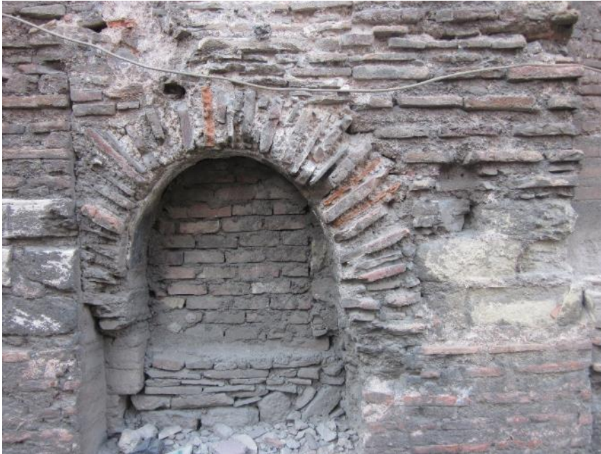
Şekil 4.106: Güney cephede yer alan ve gizli tuğla tekniğinin kullanıldığı bir kemerde, öndeki kalın ve gerideki ince tuğlalar.
