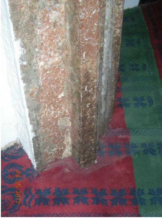
Şekil B. 40: Kapının profilli taş sövelerinden (kırmızı renkli hipüritli kalker) detay.
