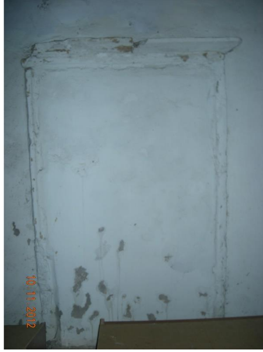
Şekil B. 34: Dış son cemaat yerinden kuzeye bakış-Soldaki fotoğrafta köşedeki dikme ve mermer başlık, sağdaki fotoğrafta basit profilli taş söveleri olan kapatılmış geçiş
