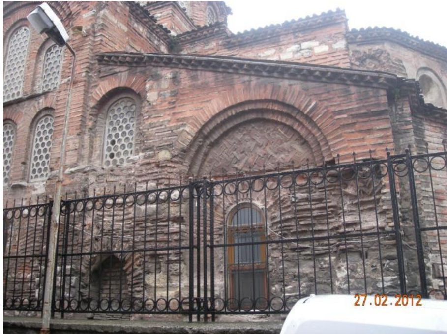
Şekil 4.69: Güney cephe 5. Bölüm.
