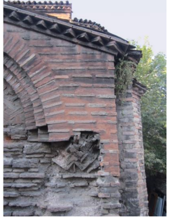
Şekil 4.72: Solda apsis üzerindeki kör niş - sağda resimde köşede balıksırtı motif.
