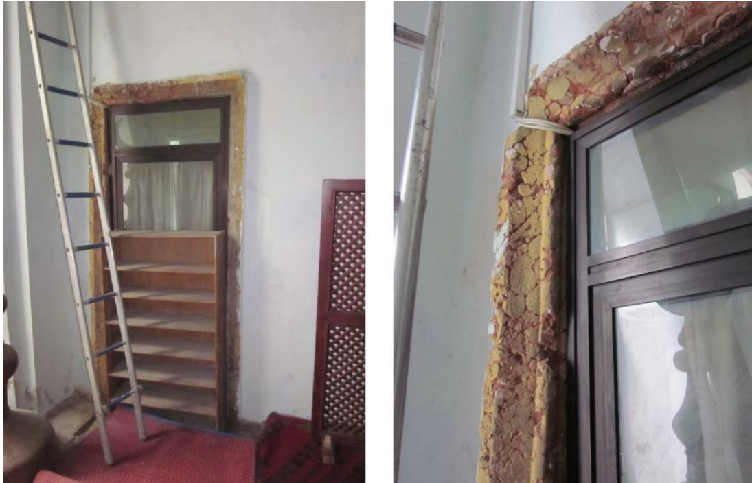
Şekil B. 47: İç son cemaat yeri ile imam odası bağlantısını sağlayan kapının profilli taş (Hereke pudingi) çerçevesi.
