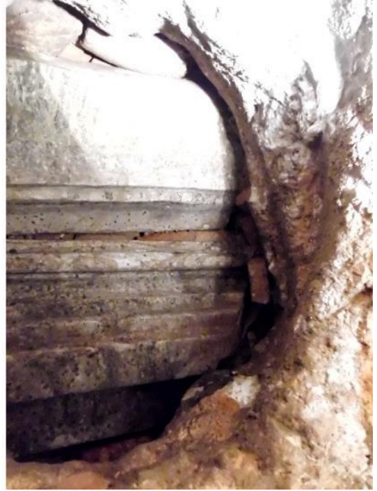
Şekil B. 65: Alt yapının güney koridoru ve tavanındaki delik (Delğin üstten kapatılması için kullanılan iki taş sövenin profilleri, iç ve dış son cemaat yeri kapı sövelerinin profilleriyle benzerlik göstermektedir).
