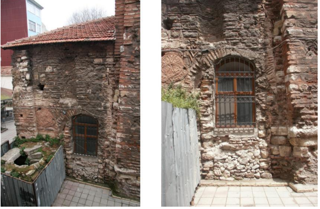
Şekil 4.54: Güney cephe 1.bölüm.
