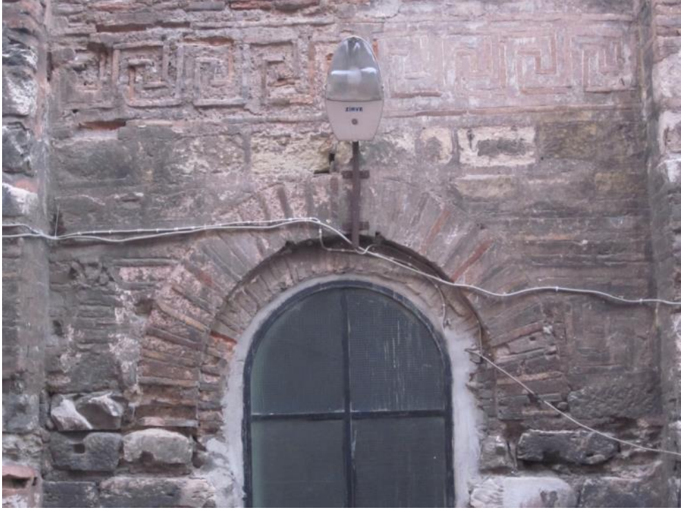
Şekil 4.59: Demir kapının üst kısmındaki meander frizi.
