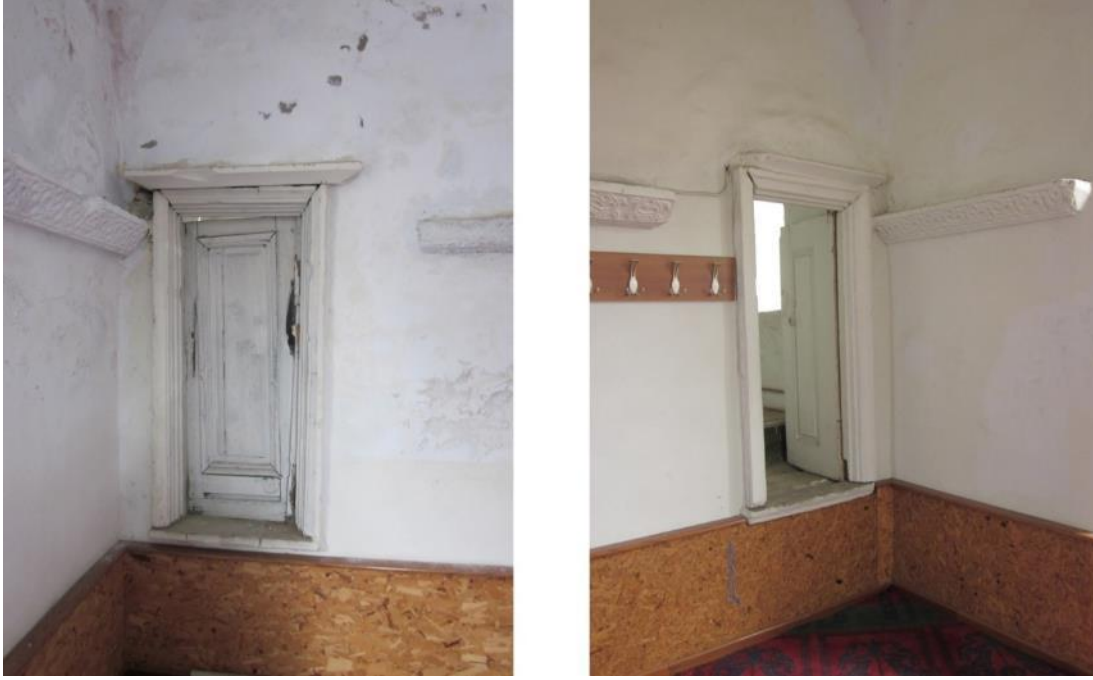
Şekil 4.23: Kuzeyde (Soldaki fotoğraf) ve güneyde (Sağdaki fotoğraf) hücre kapıları.
