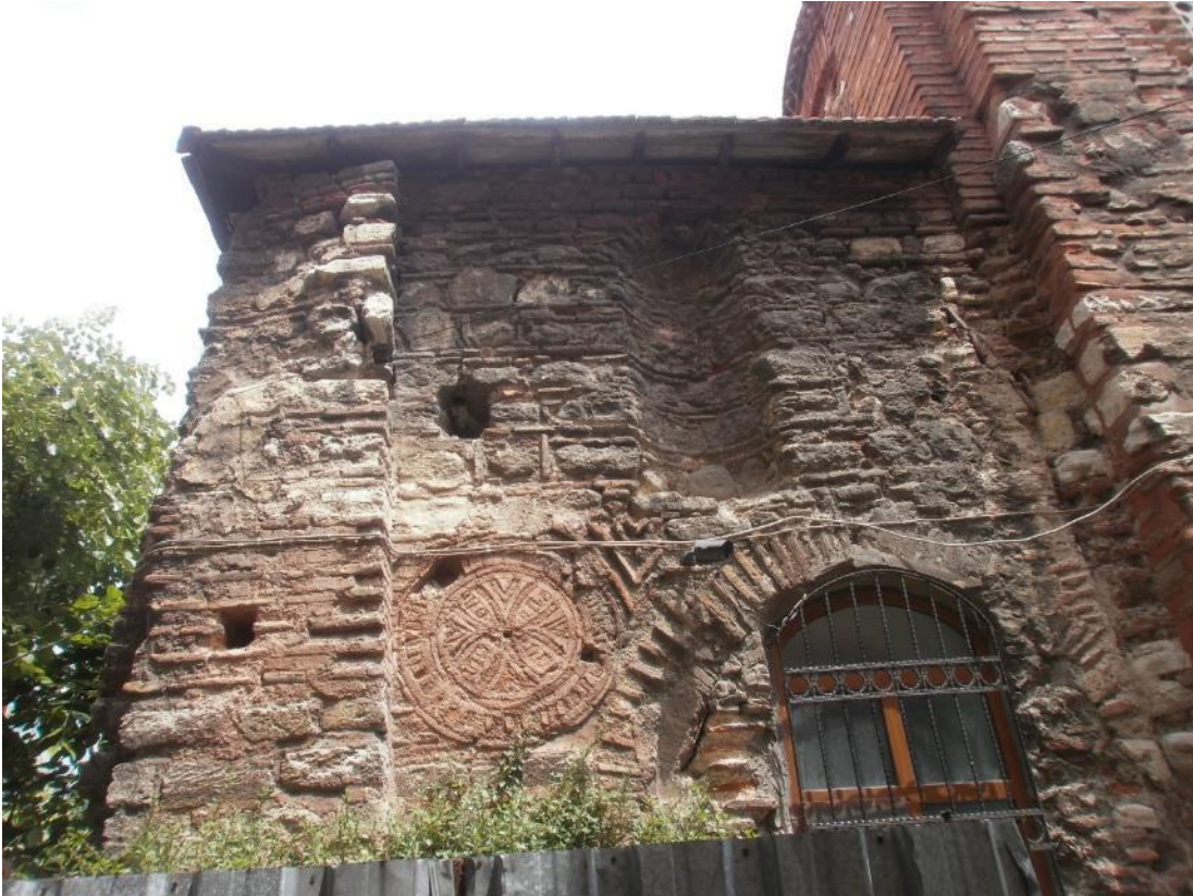
Şekil B. 90: Güney cephesi.
