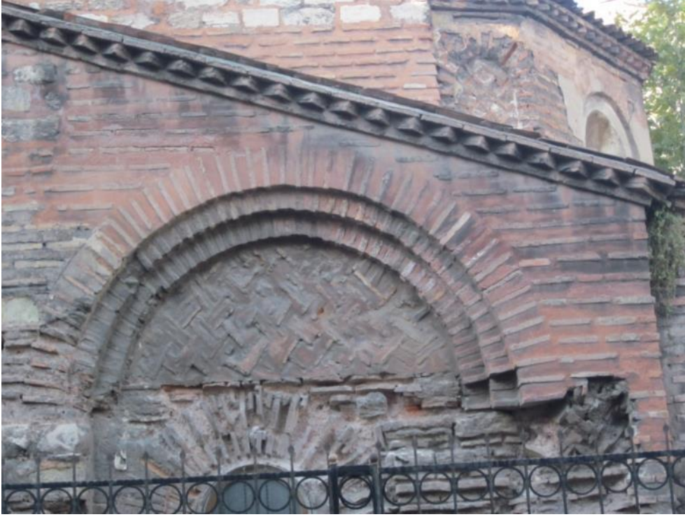
Şekil 4.73: Kademeli dairesel kemer ve uç kısmında balıksırtı döşenmiş tuğlalar.
