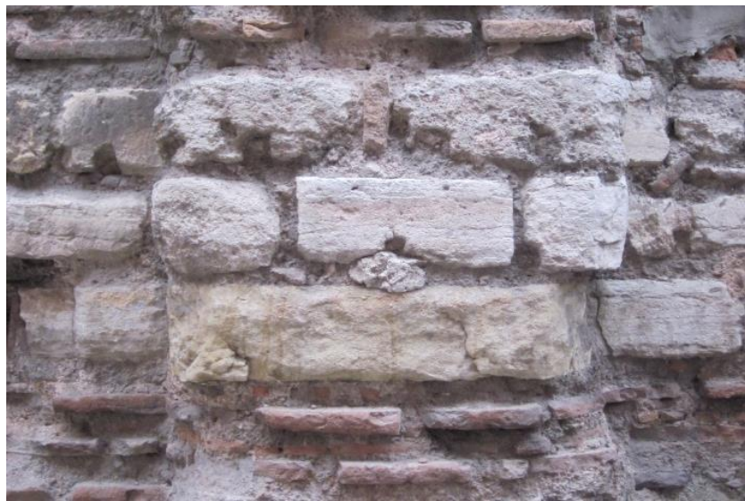
Şekil 4.108: Güney cephede, tuğla sıralarının arasında kalan 3 sıra halinde taşlar.
