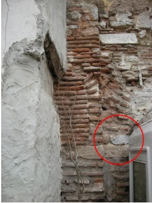
Şekil 4.50: Sol taraftaki pencere, kör niş, kesilmiş kemer ve mermer başlık.
