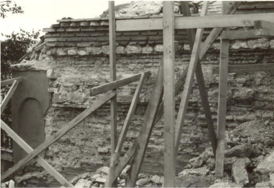
Şekil 4.86: Cephedeki tuğlaların çürütülmesi ve yeni yapılan kirpi saçak.
