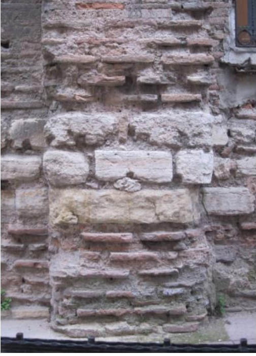
Şekil 4.60: Pilastrın alt kısımlarındaki taş-tuğla örgü ve yukarıdaki dairesel motif.
