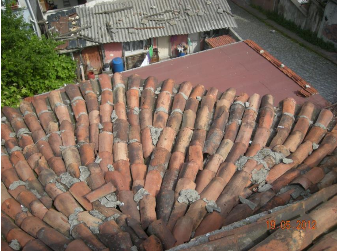
Şekil B. 99: Yapının mihrap/apsis çıkıntısının üst örtüsünü oluşturan, ııınsal olarak yerleřtirilmiř alaturka kiremitler.
