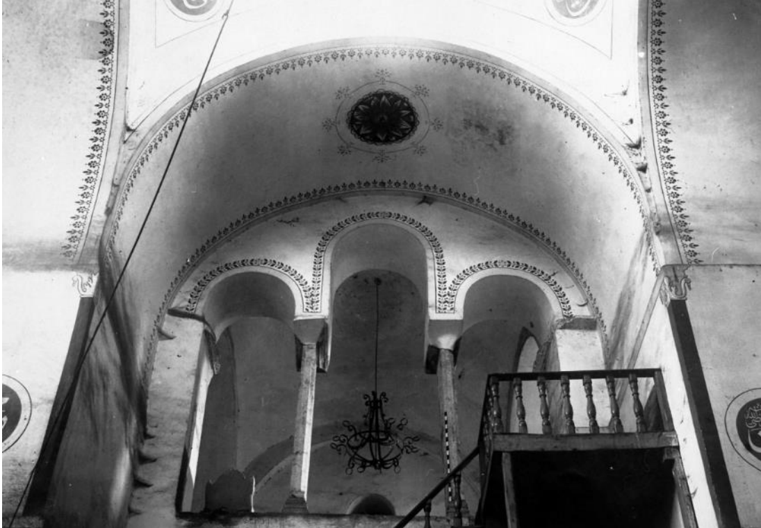
Şekil 4.20: Ahşap merdiven ve balkon 10 .
