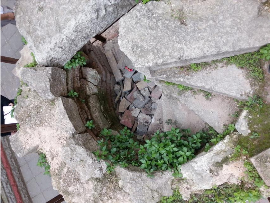
Şekil 4.95: Minareye üstten bakış, taş merdiven basamakları görünüyor.
