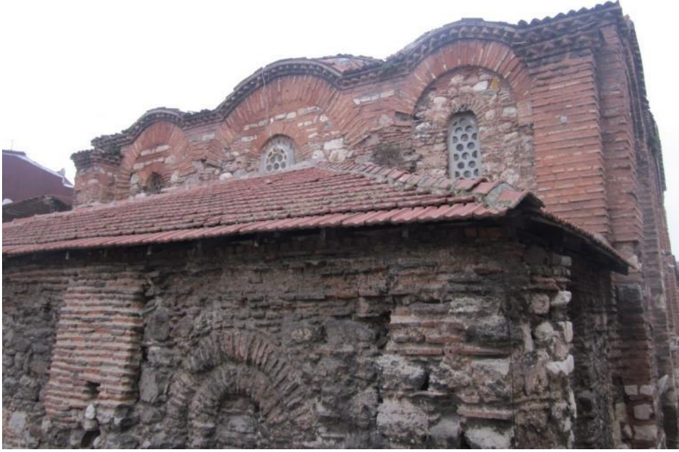
Şekil 4.88: Dış son cemaat yerinin, yapı geneline göre alçakta olan çatısı.
