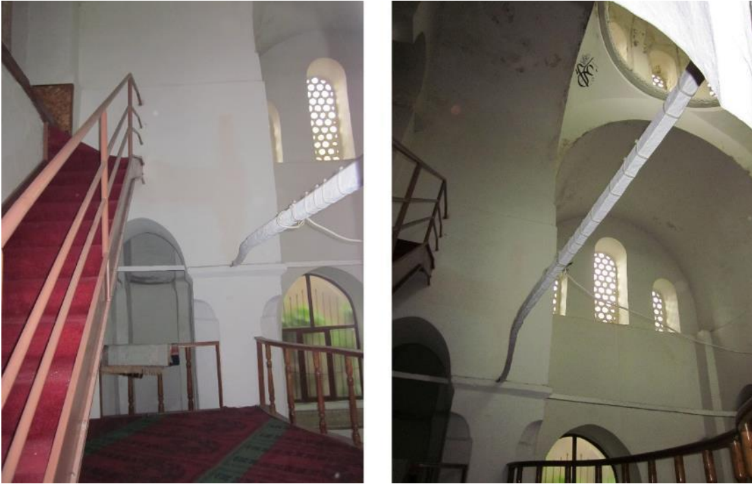
Şekil B. 51: Asma kat- soldaki fotoğrafta galeriye çıkan demir merdiven, sağdaki fotoğrafta alt noktasının asma kat zemininden yüksekliği yaklaşık 160 cm olan dövme demir gergi.
