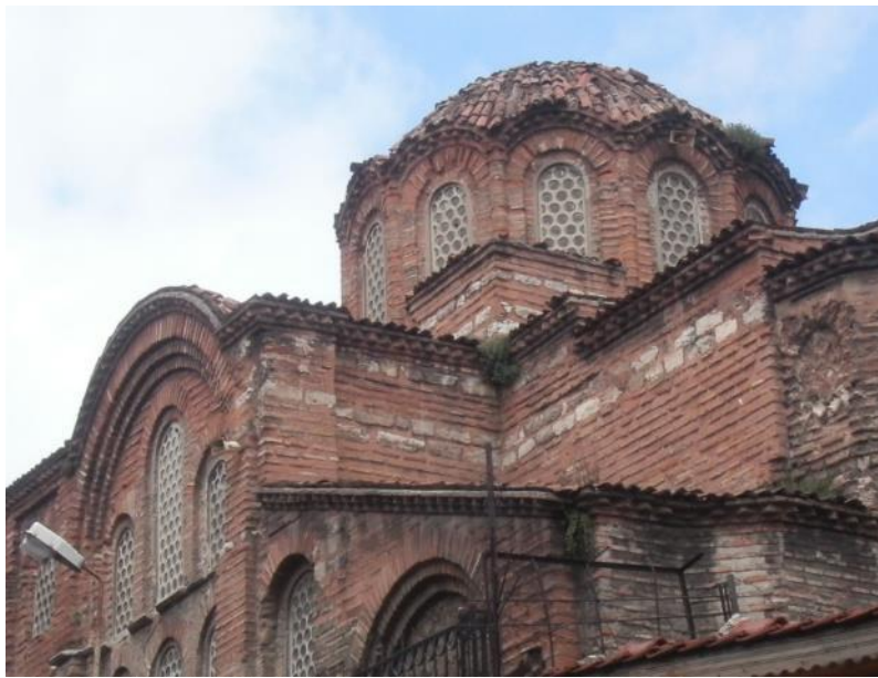
Şekil 4.77: Güney hücre çatısının üst kısmındaki duvarlar.
