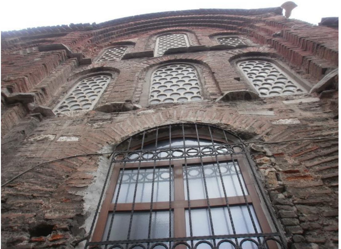
Şekil B. 92: Güney cephesi.
