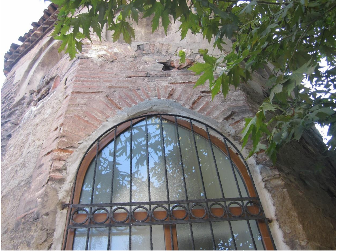
Şekil B. 95: Doğu cephesi
