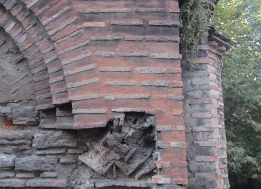
Şekil 4.112: Güney cephesi Bölüm 5'te, derzleme çalışmasında kullanılan yeni harç.
