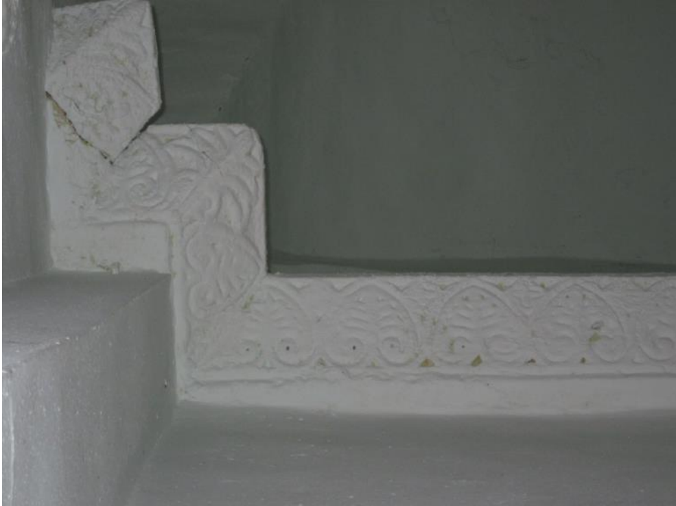
Şekil 4.9: Kabartmalı taş silme ve dış köşe detayı.
