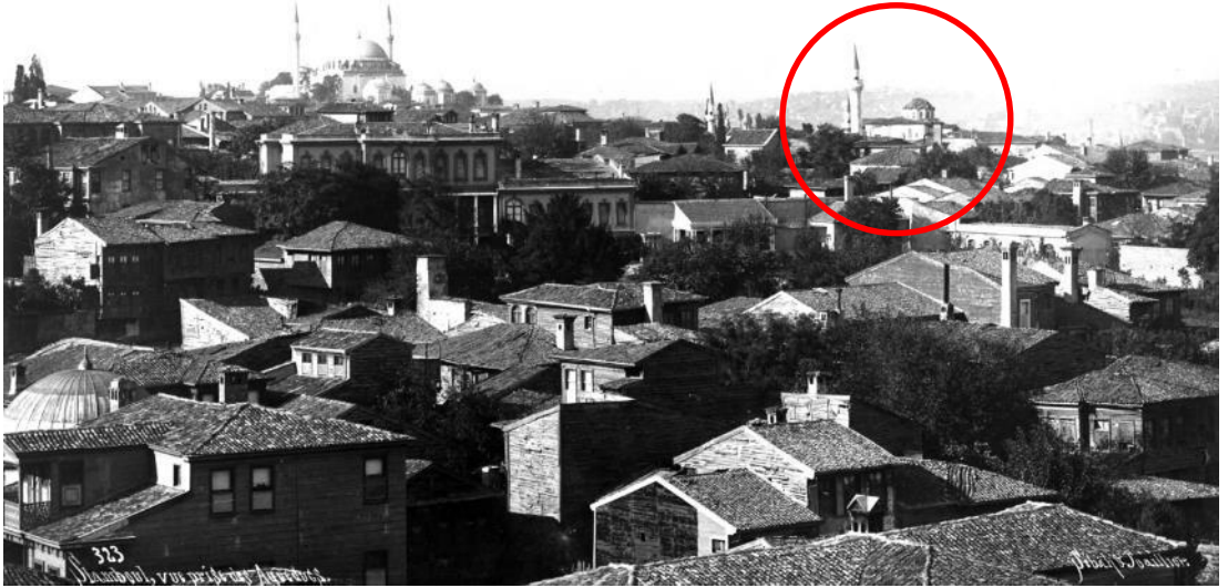
Şekil B. 13: Sağda üstte Eski İmaret Camii, DAI Fotoğraf Arşivi, R 24628, Env. No: 101872 (Yüksek olan minare, yapının güneyindeki Hacı Hasan Camii'ne aittir. Arkada kalan ve nispeten alçak olan minare ise Eski İmaret Camii minaresidir. Bu minarenin tamamen ayakta oluşu, fotoğrafın 1940'tan önce çekildiğini göstermektedir).
