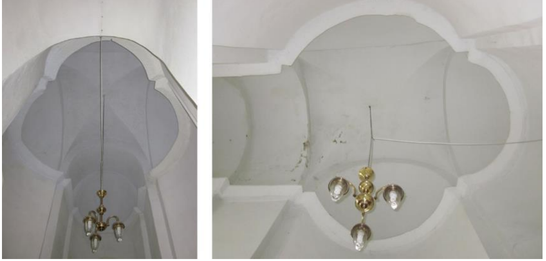
Şekil 4.41: Kuzey (Soldaki fotoğraf) ve güney (Sağdaki fotoğraf) hücrelerde üst örtüleri oluşturan çapraz ve beşik tonozlar.
