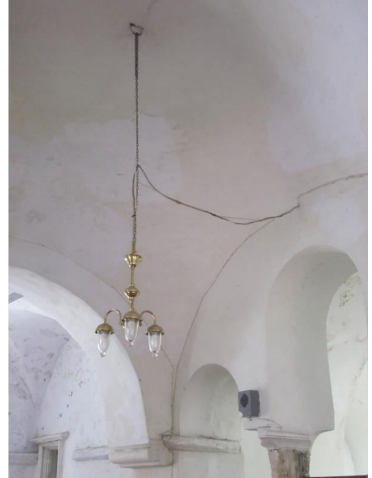
Şekil B. 61: Üst örtü- solda yan kısımlardaki çapraz tonozlardan biri ve sağda orta bölümün üst örtüsü kubbe.
