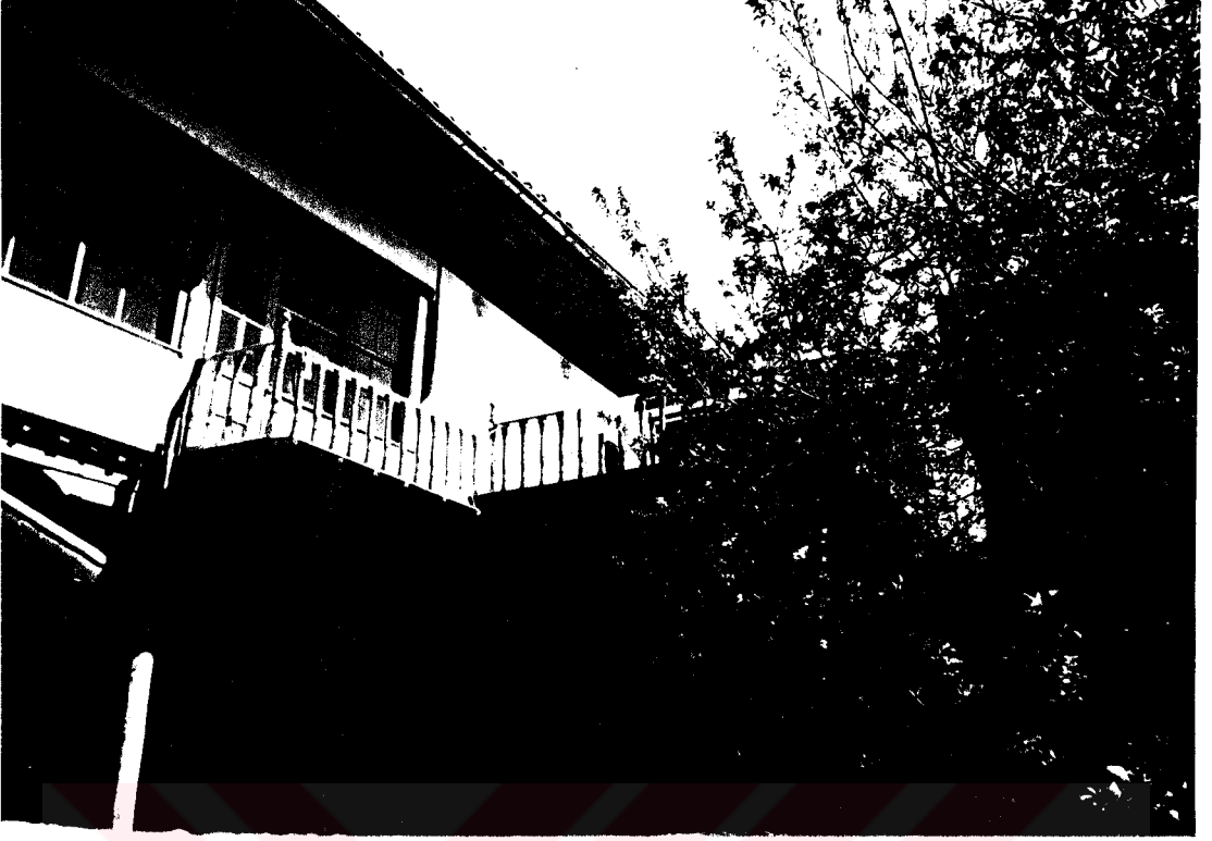
Foto B.279. Hesapçı Sokak No:36'daki ahşap teraslı ev
