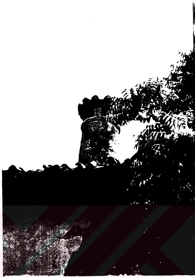
Foto B.134. P binasının çatısı üzerinde yer alan silindirik bacanın g neybatı y nt nden  ekilmi  foto rafı
