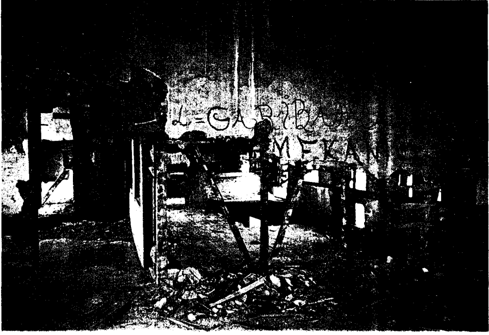
Foto B.65. P8 mekanının kuzeybatı duvarı
