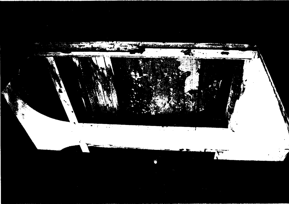
Foto B.61. P7 mekânının kuzeydoğu duvarı üzerindeki bir pencerenin kasası üzerindeki izler
