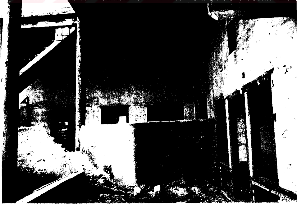
Foto B.18. 1994 Temmuz ayındaki arazi çalışmalarında Kurul izniyle yıktırılan, taşlığı ikiye ayıran ek duvar
