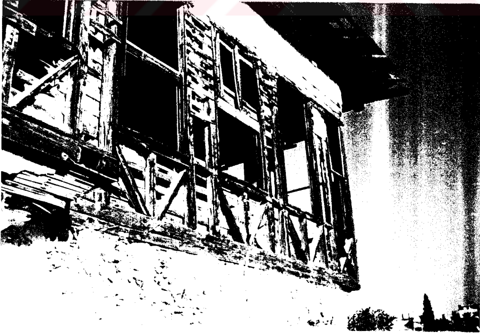
Foto B.133. P10 mekanından yapının g neybatı cephesine a ılan pencereler
