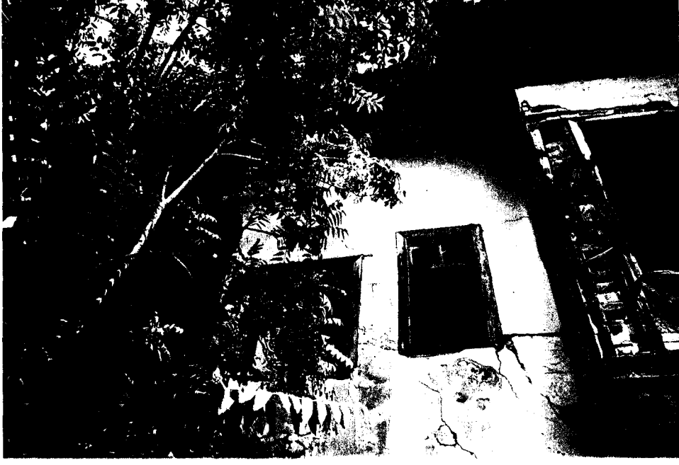
Foto B.130. P12 mekanından yapının g neybatı cephesine a ılan pencereler
