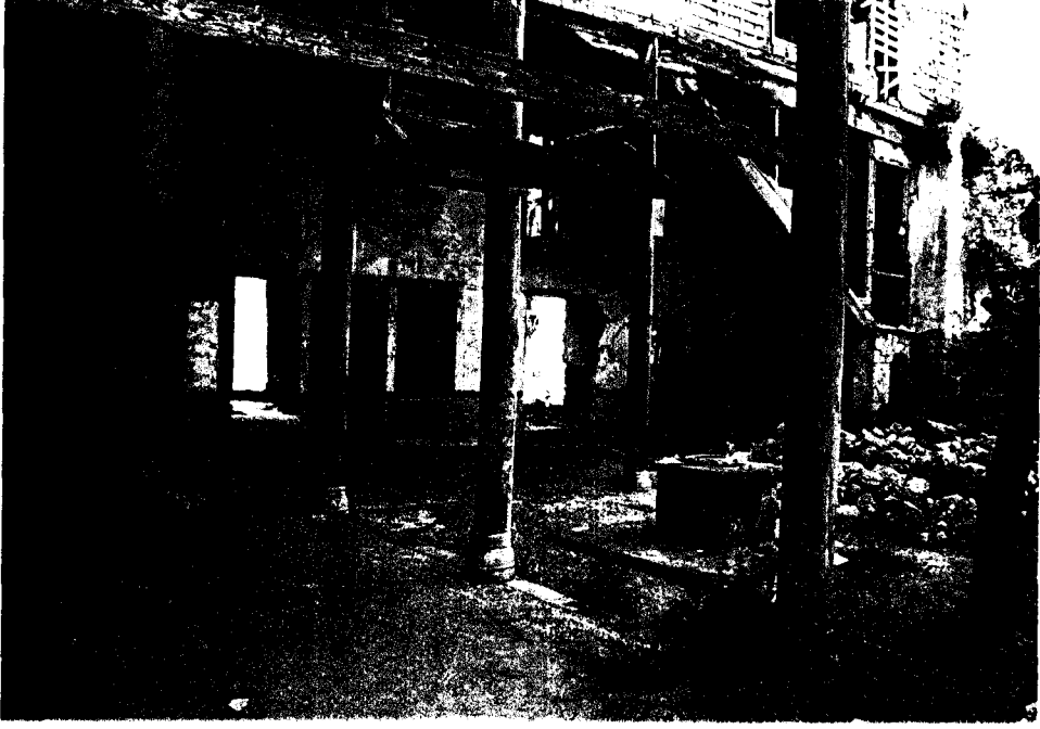
Foto B.9. P binası taşlığının genel görüntüsü
