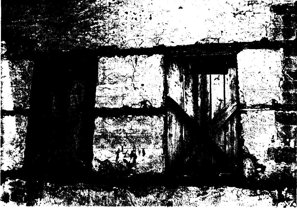
Foto B.103. P1 mekanından kuzeydoğu cephesine açılan pencereler
