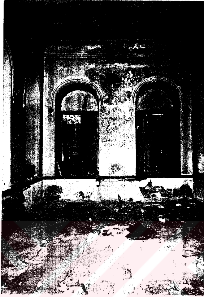
Foto B.25. P1 mekanının kuzeydoğu duvarı
