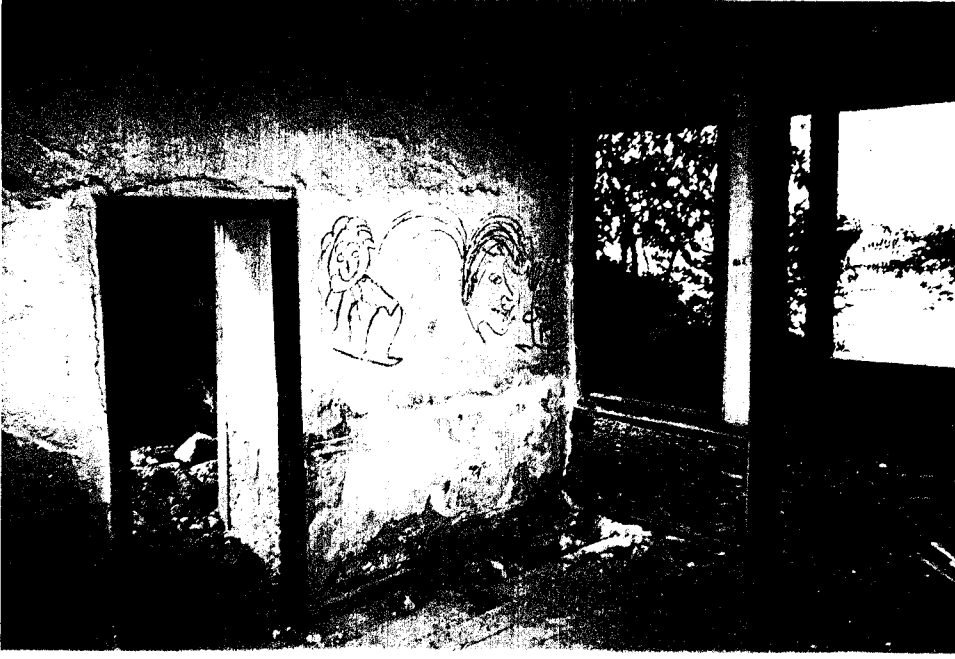
Foto B.47. P3 mekanından P4 mekanına açılan kapı boşluğu
