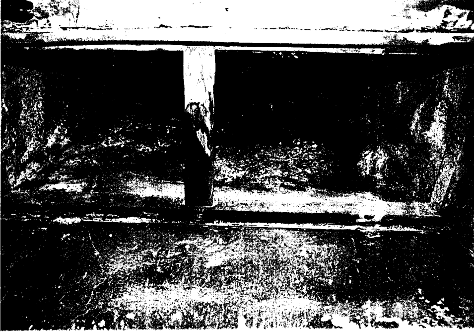
Foto B.277. U6 mekanındaki ocağın bacası içinde yer alan, ocağın kullanılmadığı zamanlarda örtülen kapağın kalan çerçevesi
