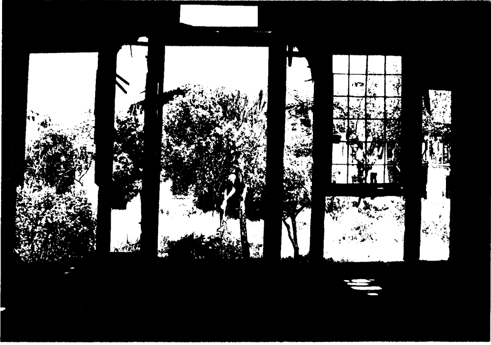
Foto B.221. U5 mekanının kuzey duvarı
