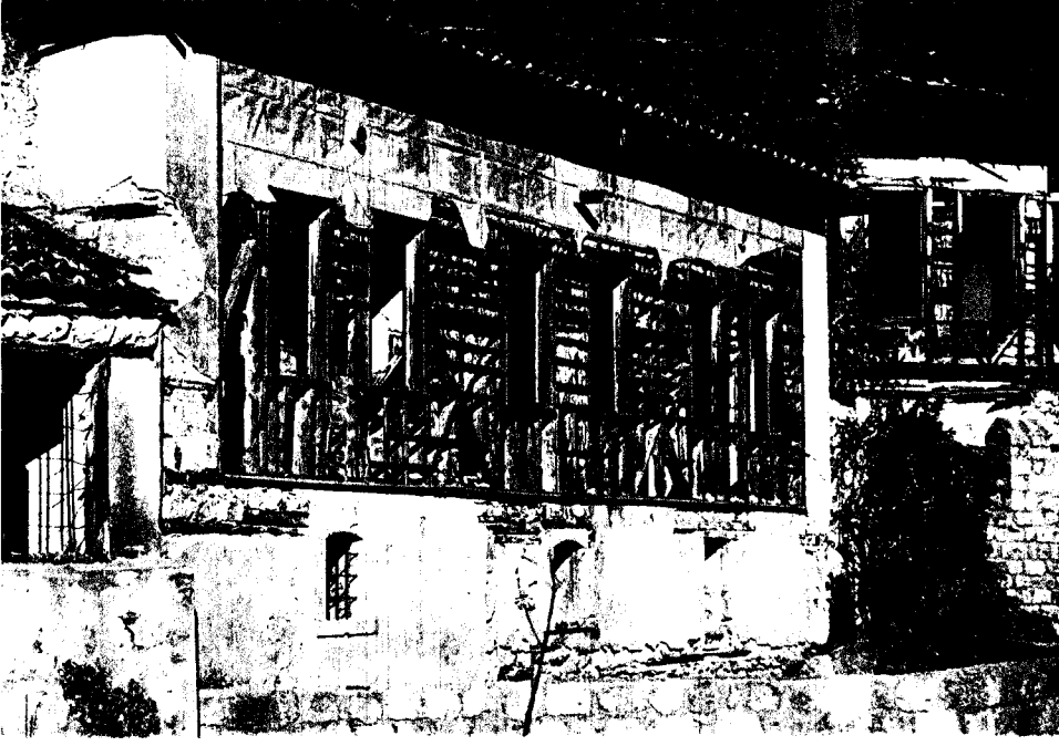
Foto B.179. U binasının g ney cephesi
