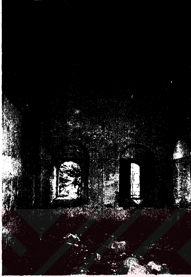
Foto B.37. P2 mekanının g neydoęu duvarı
