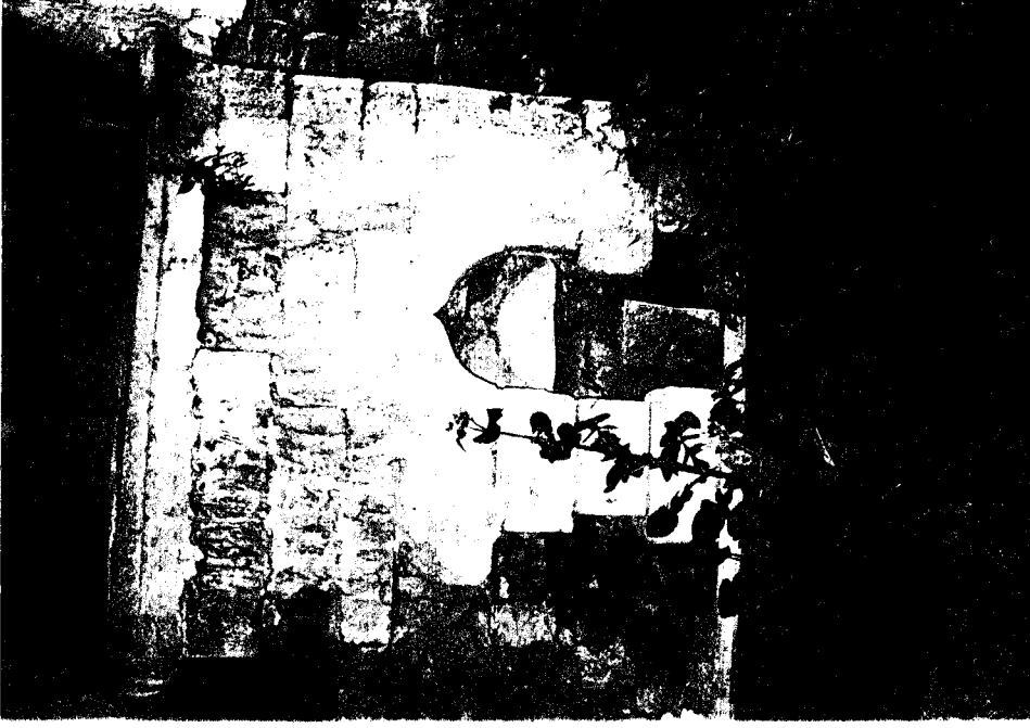
Foto B.16. Merdivenin bir ve ikinci sahanlıklarını taşıyan kesme taş duvarın taşıya bakan yönünde yer alan lambalık
