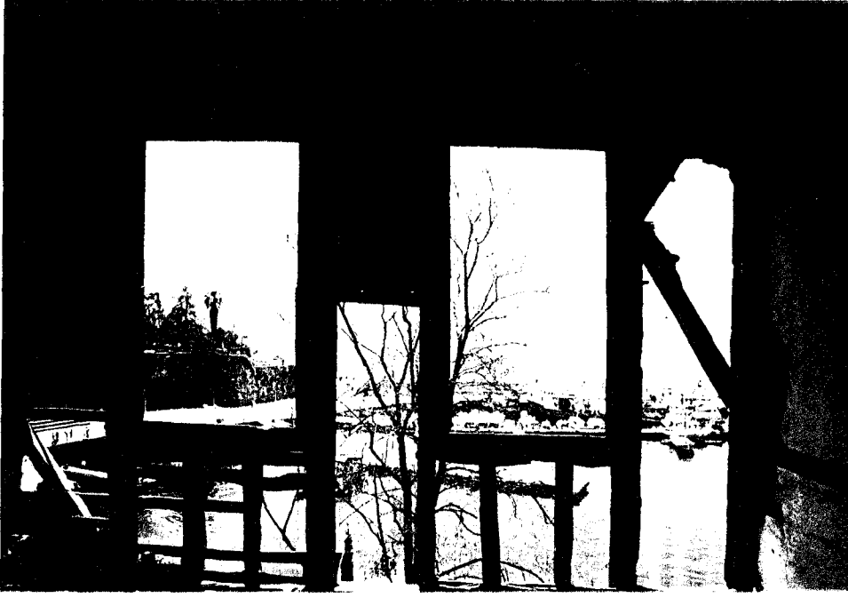
Foto B.253. U11 mekanının g ney duvarı  zerindeki iki pencere bo lu u
