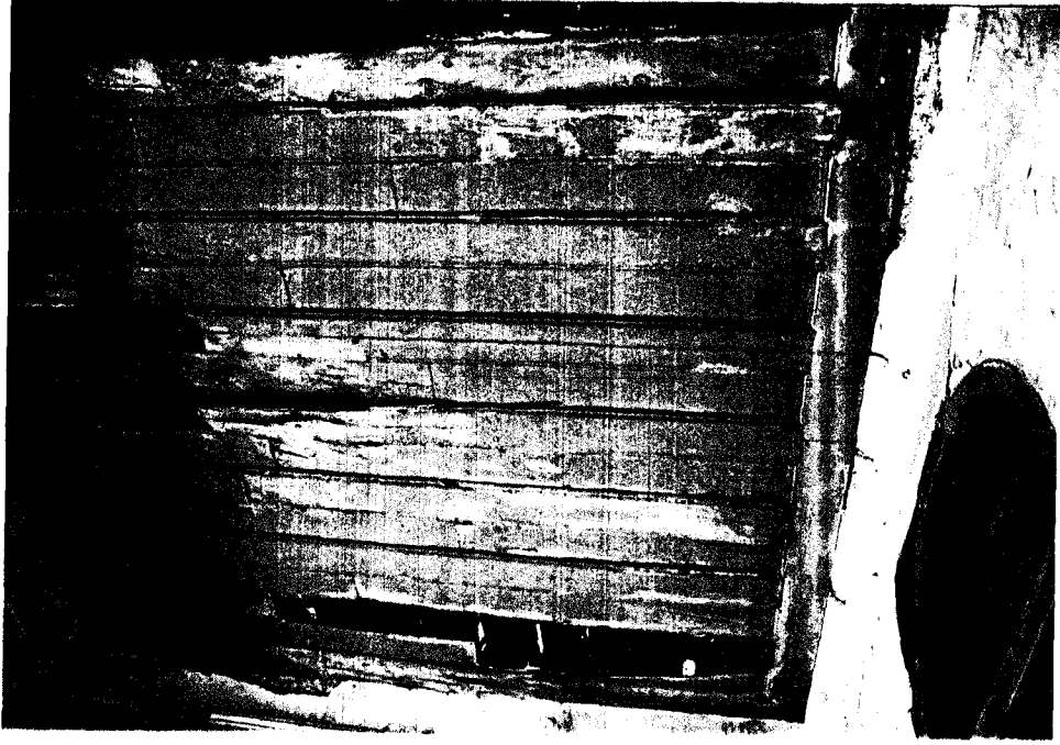
Foto B.225. U5 mekanının tavanı
