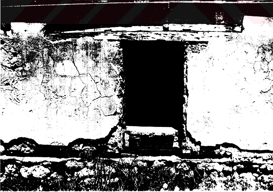
Foto B.182. U binasının g ney cephesinin zemin kat duvarındaki bir pencere bo luđu
