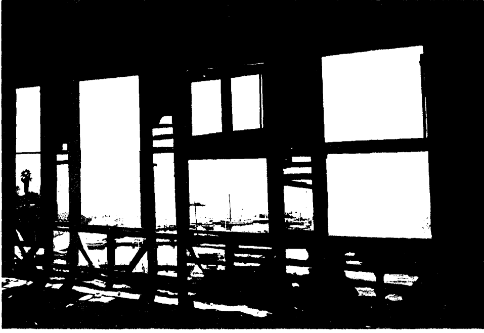
Foto B.87. P10 mekanının g neybatı duvarı
