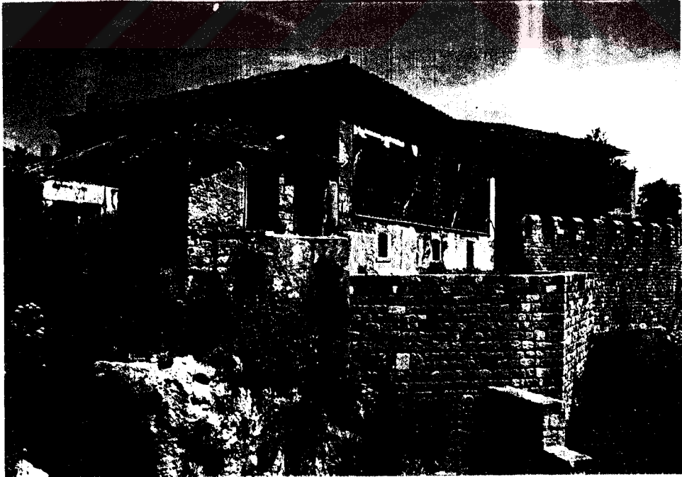
Foto B.184. U binasının genel olarak güney cephesi
