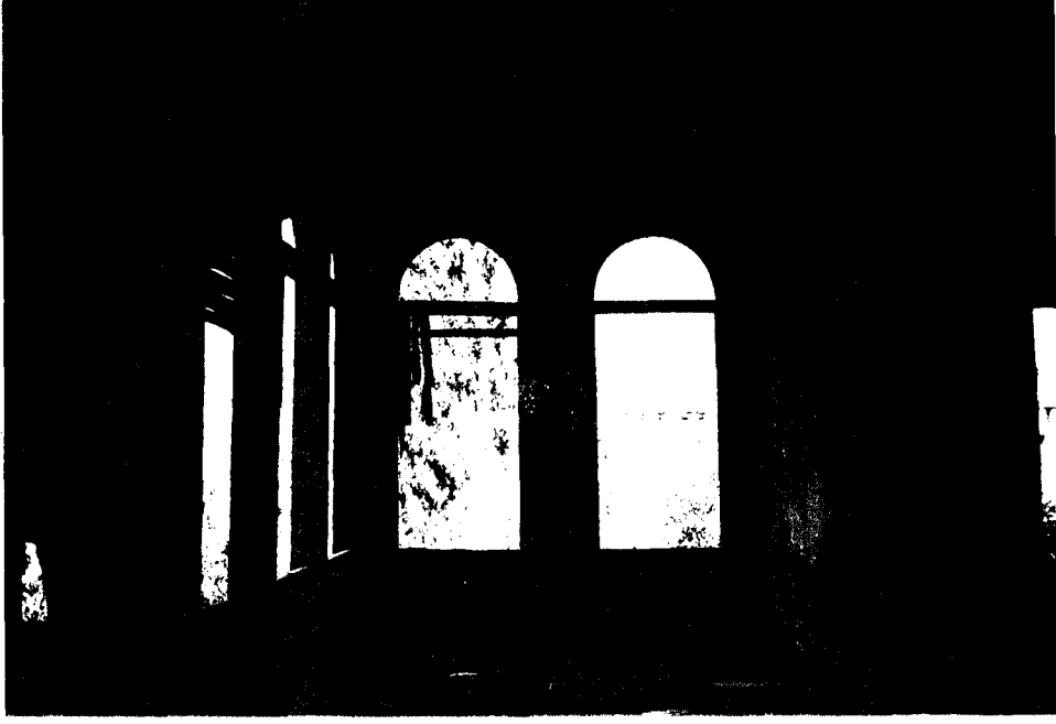
Foto B.69. P8 mekanının kuzeydoğu duvarı üzerinde yer alan pencere boşlukları
