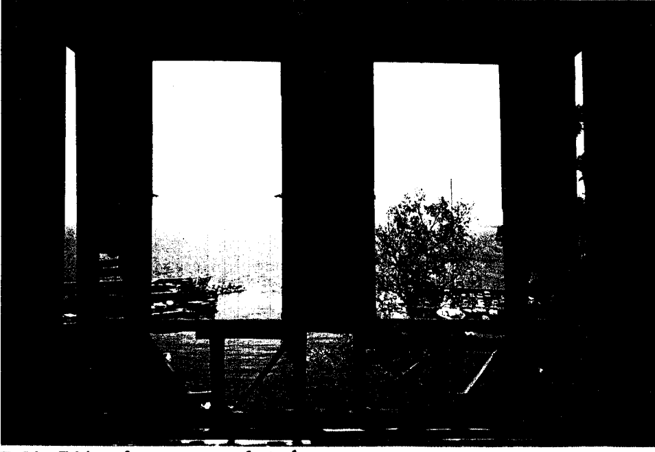
Foto B.91. P11 mekanının g neybatı duvarı
