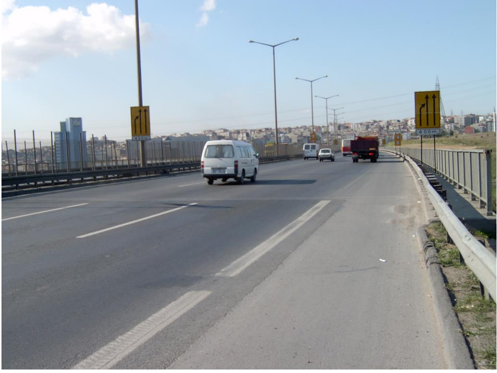
Şekil 1.2 Mahmutbey Viyadüğü üstten görünüş
