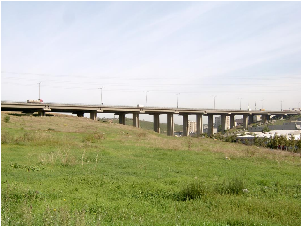
Şekil 1.1 Mahmutbey Viyadüğü genel görünüşü.
