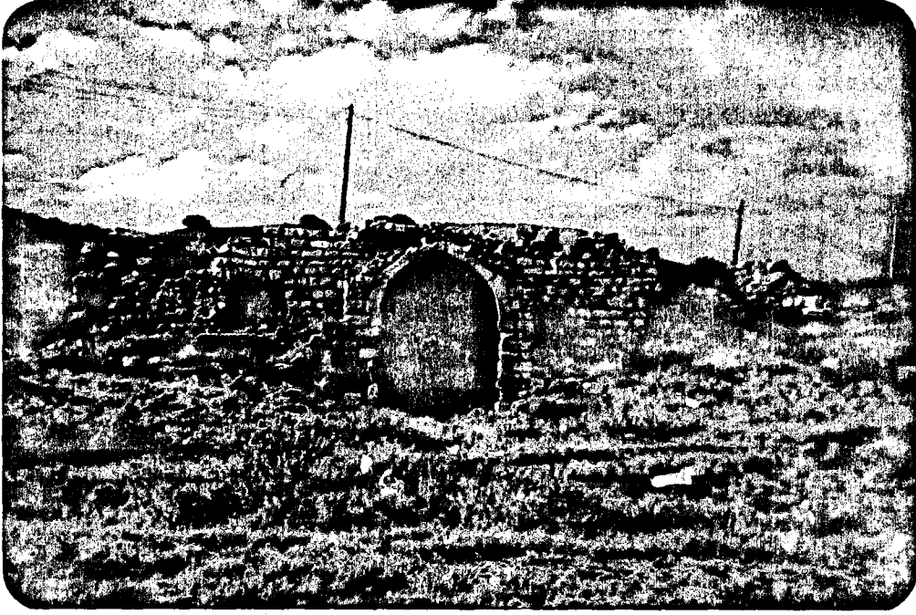
Fot.25 GİRİŞ CEPHESİ
