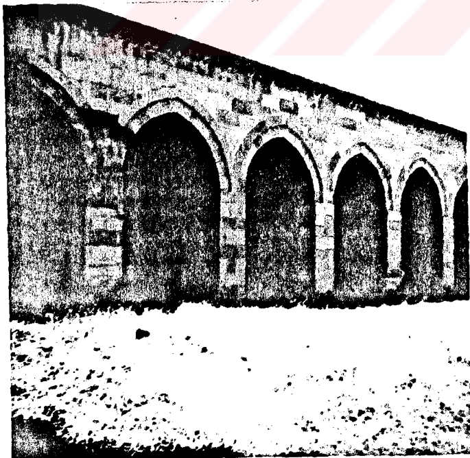
Fot.148 AVLU REVAKLARI 1989
