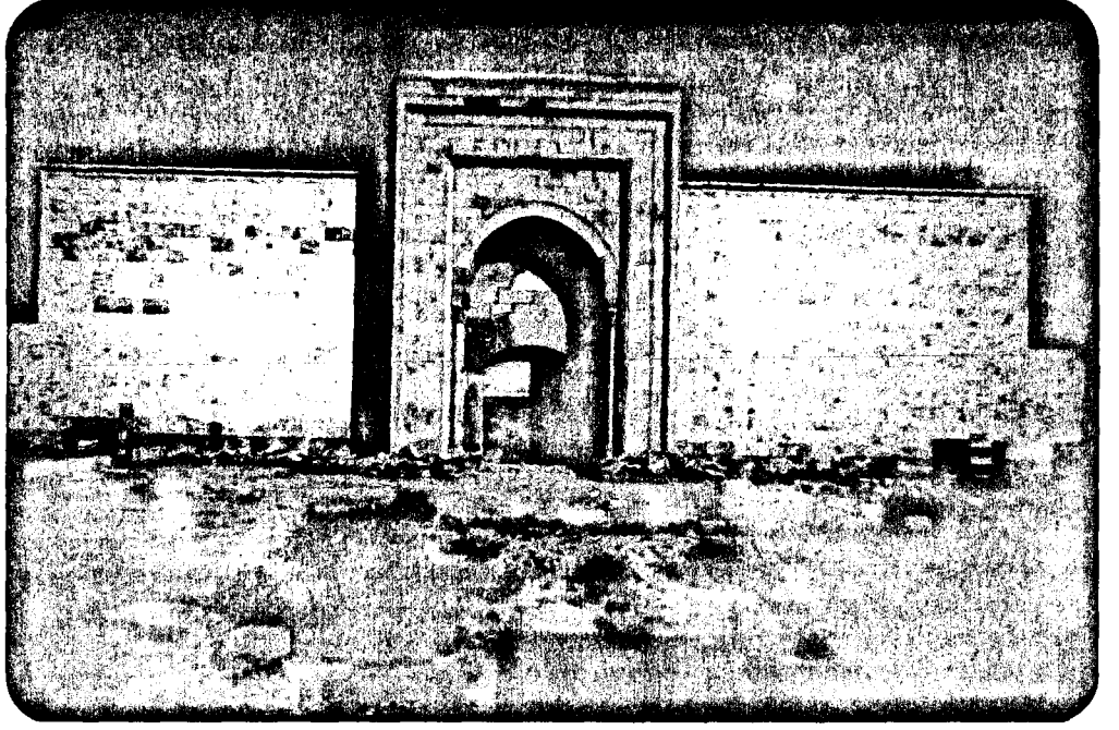
Fot.56 GİRİŞ CEPHESİ
