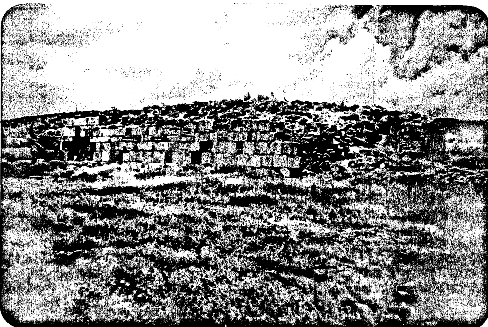
Fot.99 GÜNEY CEPHESİ
