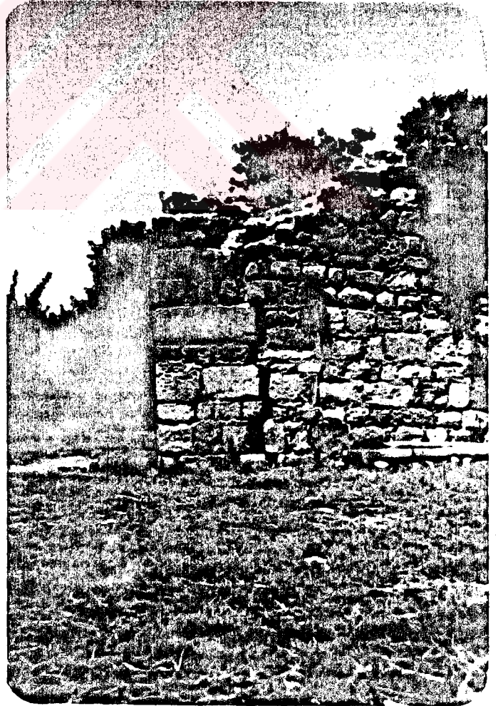
Fot.43 GIRİŞ CEPHESİ BATI KÖŞESİ
