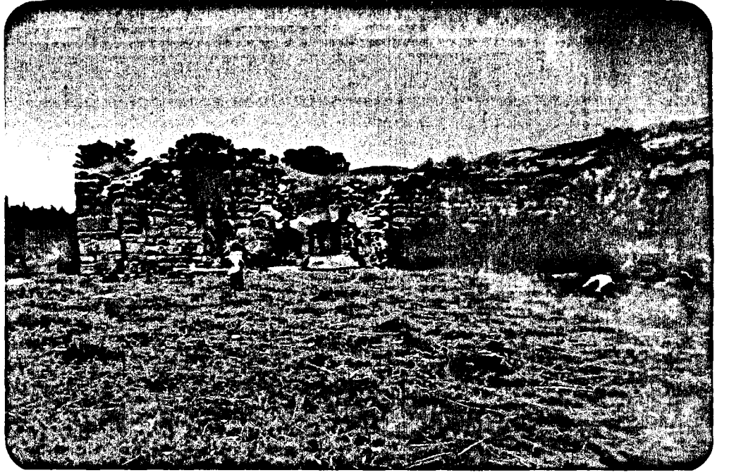
Fot.42 GIRİŞ CEPHESİ
