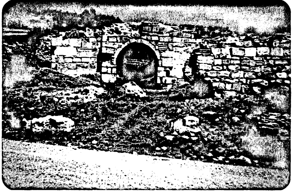
Fot.38 GİRİŞ CEPHESİ
