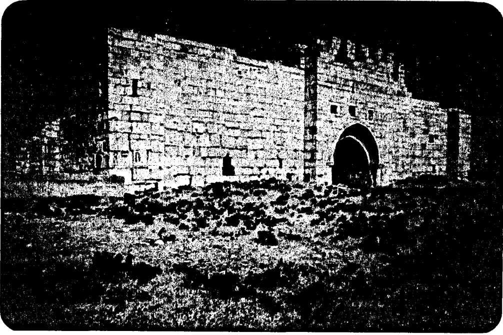
Fot.104 GİRİŞ CEPHESİ
