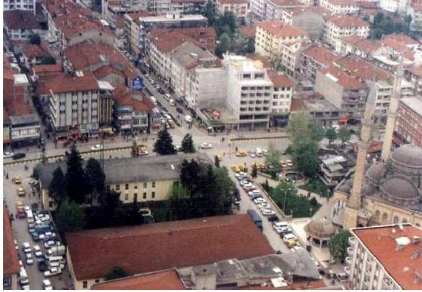
Şekil 4.7 : Deprem öncesi Düzce'den görünüm (Düzce Valiliği, 2002)
